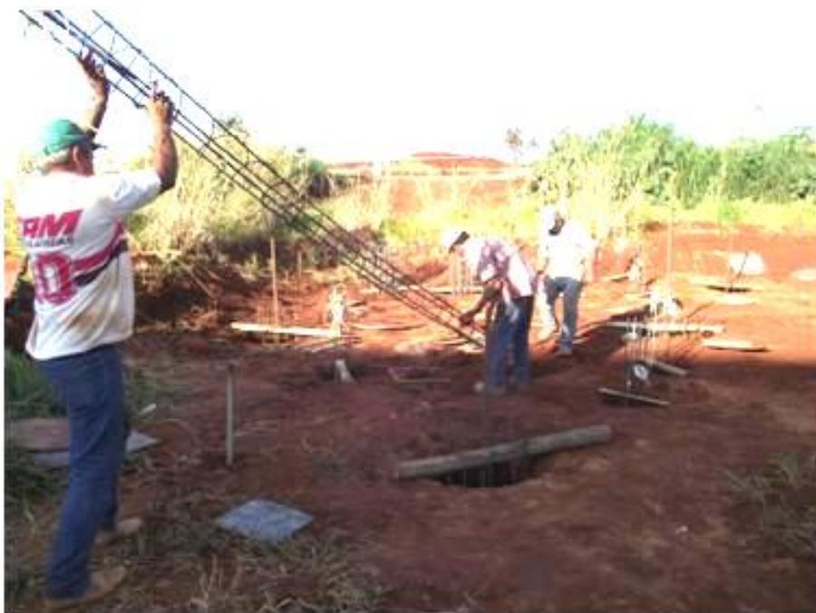
Figura 3.43 – Posicionamento da armadura longitudinal das estacas de teste.
