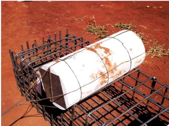
Figura 3.46 – Detalhe da vedação e amarração do defeito instalado nas estacas E9, E13 e E26.
