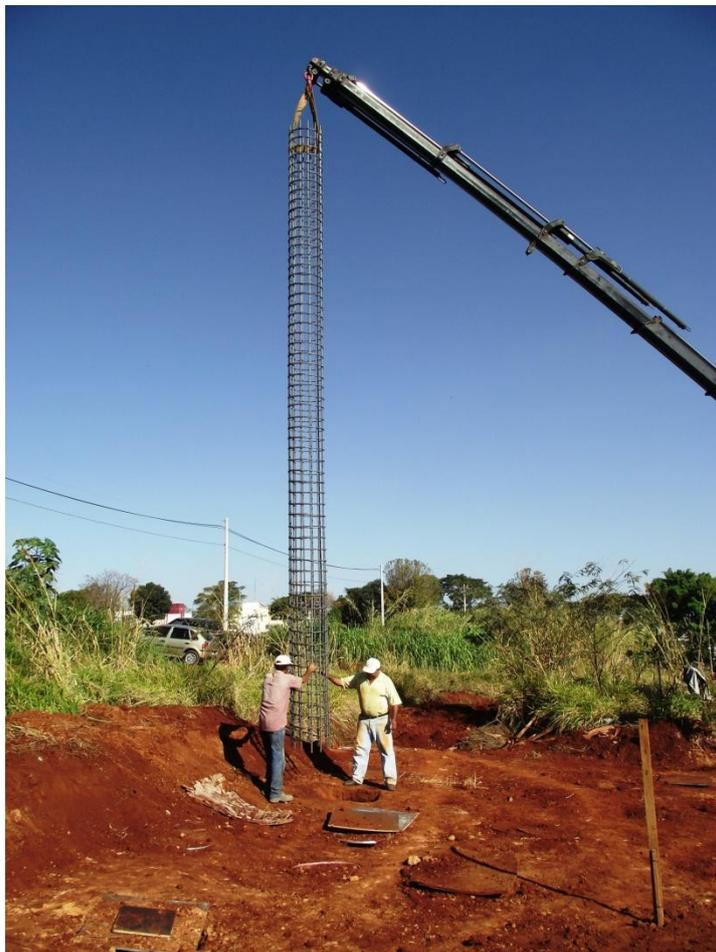
Figura 3.41 – Posicionamento da armadura longitudinal das estacas de reação.
