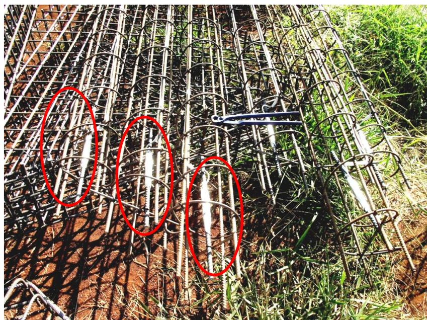
Figura 3.40 – Barras instrumentadas instaladas nas armaduras.
