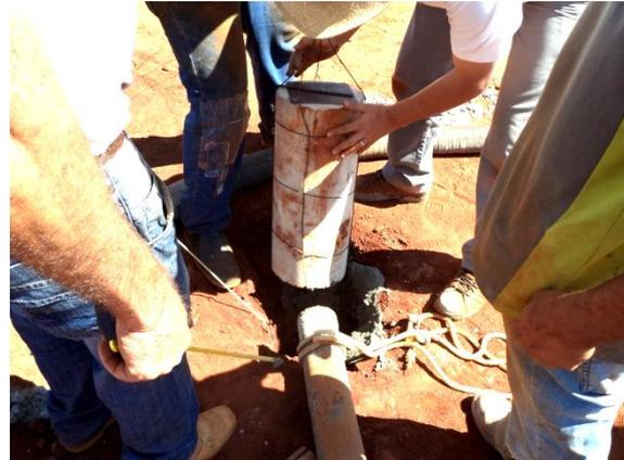
Figura 3.47 – Posicionamento do defeito para inserção no furo após a concretagem do trecho inferior da estaca defeituosa.
