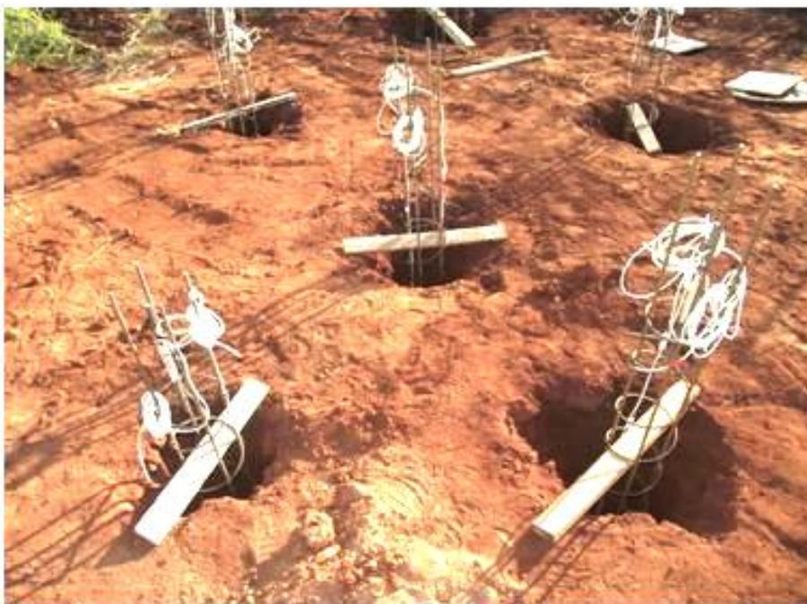
Figura 3.44 – Armaduras e instrumentação das estacas teste posicionadas a espera da concretagem.
