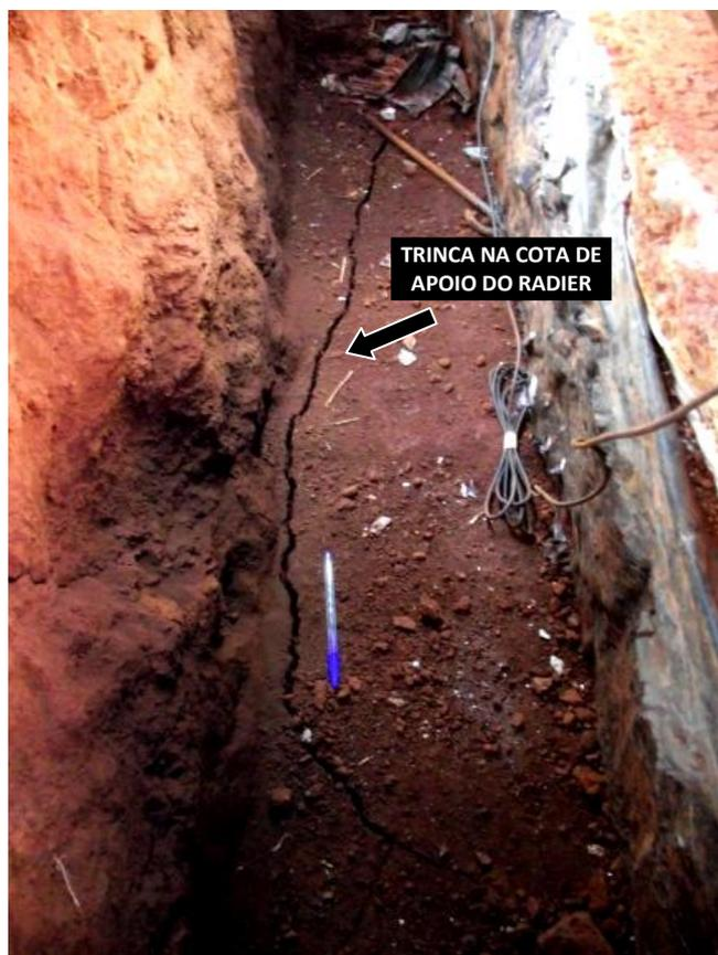
Figura 4.50 – Trinca na cota de apoio do radier após a ruptura geotécnica da fundação.
