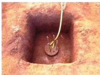
Figura 3.50 – Escavação até a cota de arrasamento da estaca do radier CD<sub>1</sub>(EXP).
