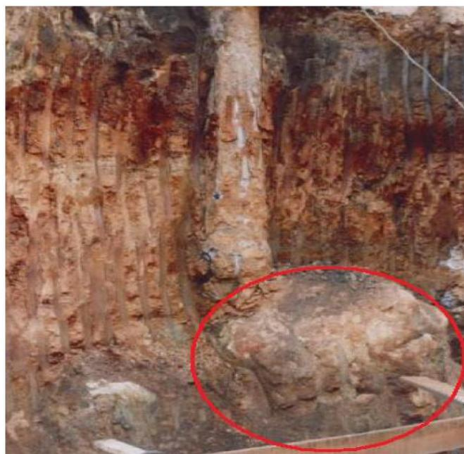
Figura 2.102 – Blocos de rocha encontrado isolado que interrompeu a execução da estaca (Milititsky *et al.*, 2008).
