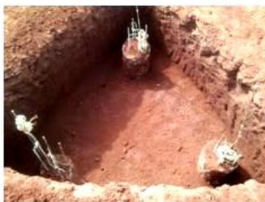
Figura 3.51 – Escavação até a cota de arrasamento da estaca do radier CD<sub>3</sub>(EXP).
