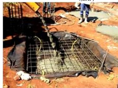
Figura 3.58 – Concretagem do radier CD<sub>4</sub>(EXP).
