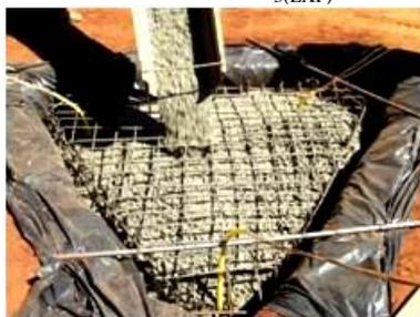
Figura 3.57 – Concretagem do radier CD<sub>3</sub>(EXP).
