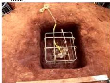
Figura 3.53 – Posicionamento da armadura do radier CD<sub>1</sub>(EXP).
