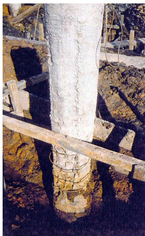
Figura 2.106 – Estaca com dano severo (ruptura) no fuste.
