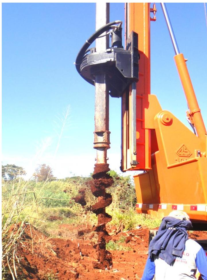
Figura 3.38 – Trado helicoidal em detalhe.
