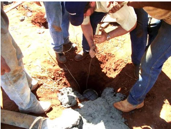
Figura 3.48 – Instalação do defeito das estaca em campo.
