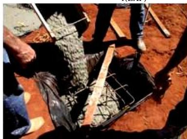
Figura 3.56 – Concretagem do radier CD<sub>1</sub>(EXP).
