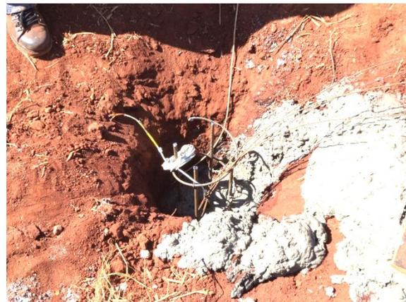
Figura 3.49 – Trecho superior da estaca defeituosa concretado.
