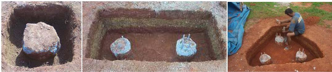
Figura 2.69 – Estacas executadas e radiers escavados a espera da armadura e concretagem. (Anjos, 2006).
