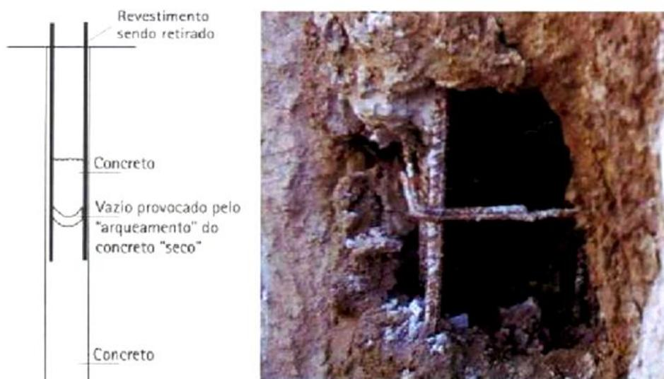
Figura 2.100 – Descontinuidade provocada por uso de concreto de baixa trabalhabilidade (Milititsky *et al.*, 2008).
