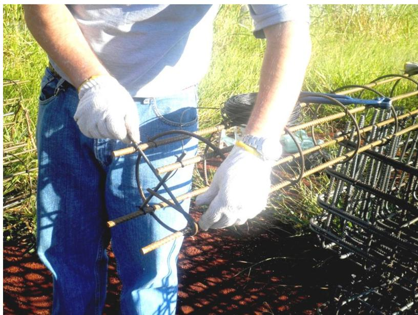
Figura 3.39 – Instalação das barras transversais nas armaduras para colocação das barras instrumentadas.
