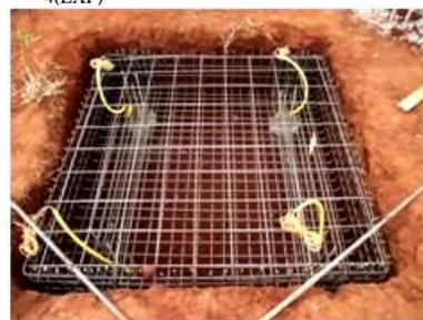
Figura 3.55 – Posicionamento da armadura do radier CD<sub>4</sub>(EXP).
