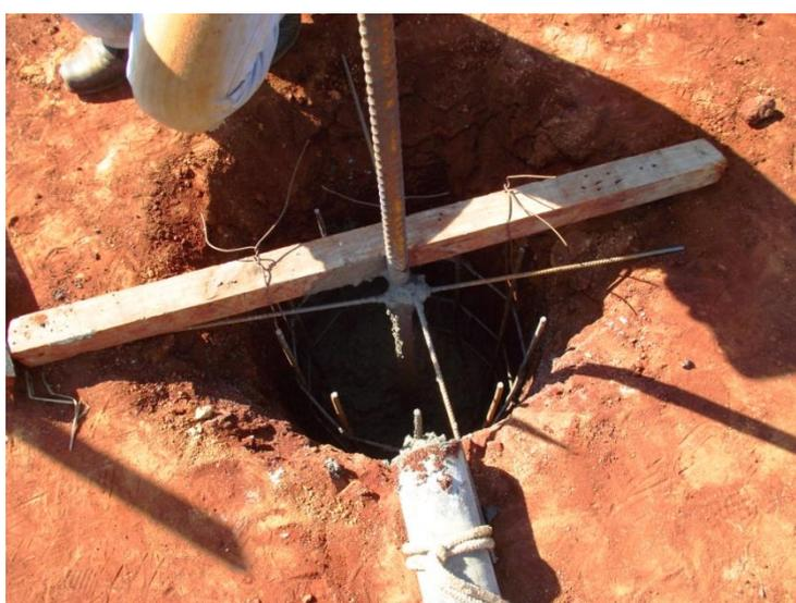
Figura 3.42 – Armadura e tirante da estacas de reação posicionados durante a concretagem.
