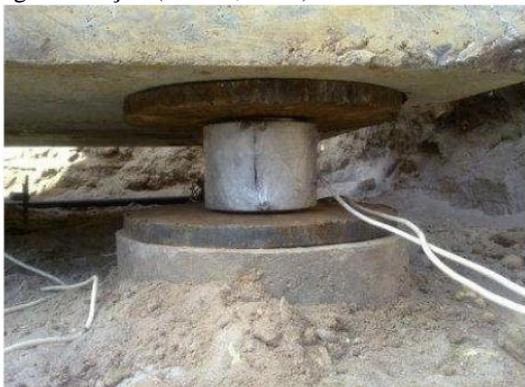
Figura 2.76 – Detalhe do contato do bloco com as estacas (Soares, 2011)
