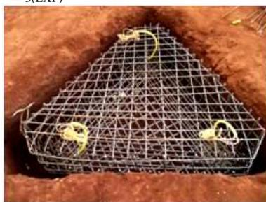
Figura 3.54 – Posicionamento da armadura do radier CD<sub>3</sub>(EXP).
