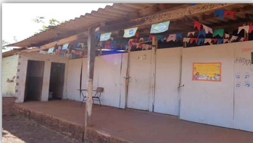
Fotografia 4.3 – Frente do prédio da escola do PA Santa Tereza I
