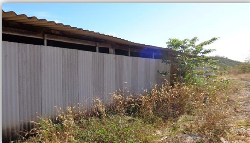
Fotografia 4.4 - Fundos do prédio da escola do PA Santa Tereza I
