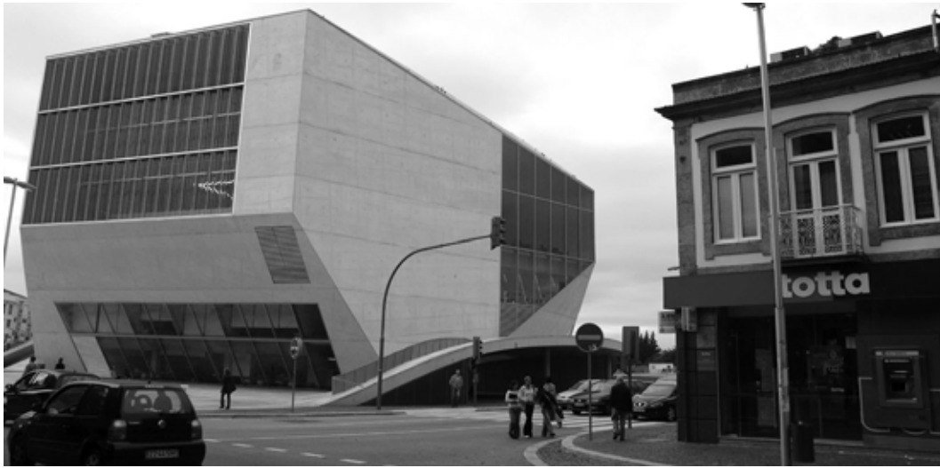
Vista da Casa da Música e edificação do entorno.
