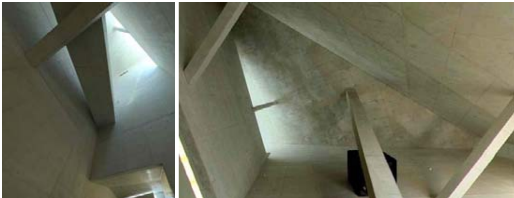
Vistas do teto com elementos estruturais.
