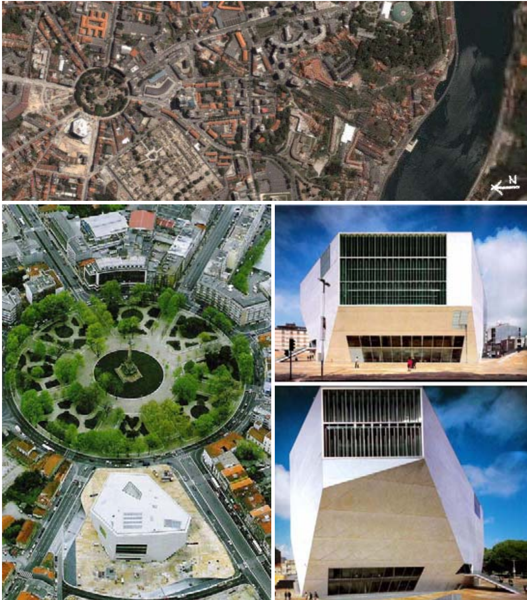
Vistas aéreas da Rotunda da Boavista junto a Casa da Música, e ao lado, vista da elevação frontal e posterior do edifício.
