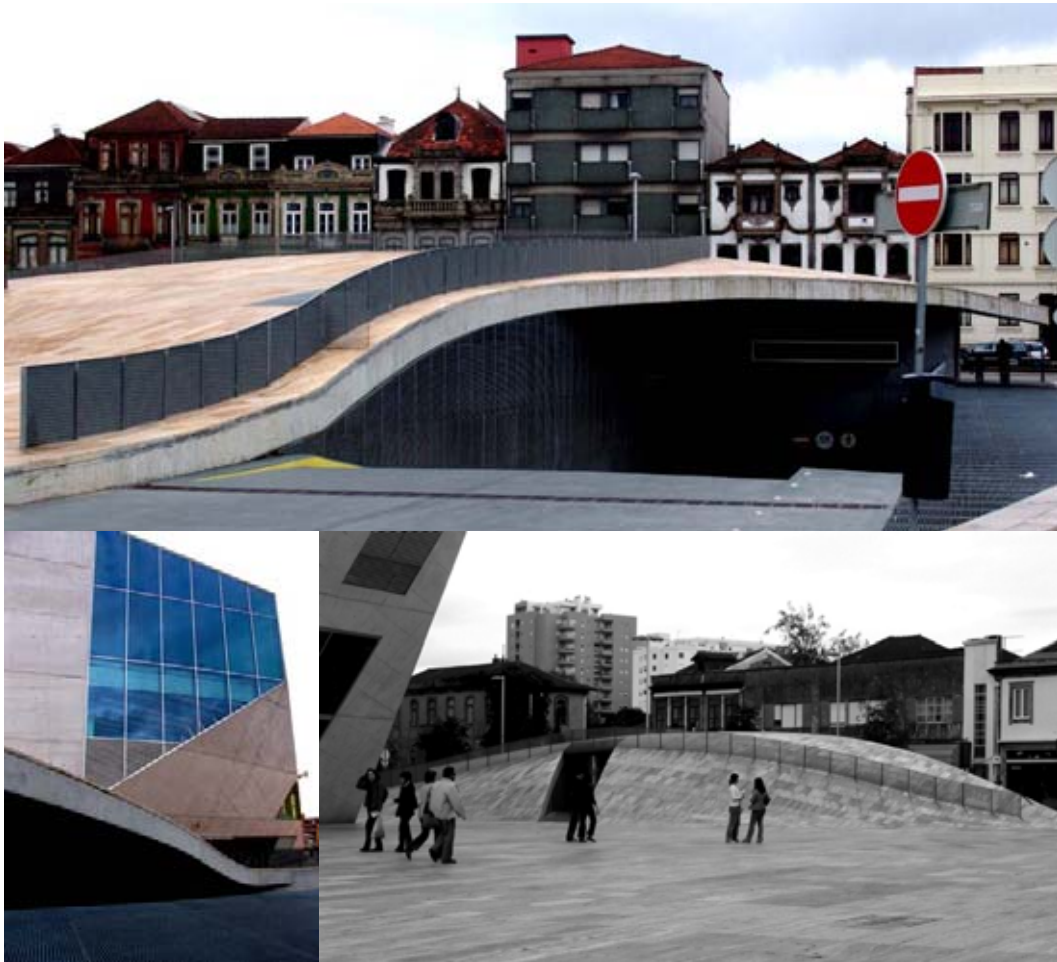
Vistas da base curva onde a casa da Música está implantada.
