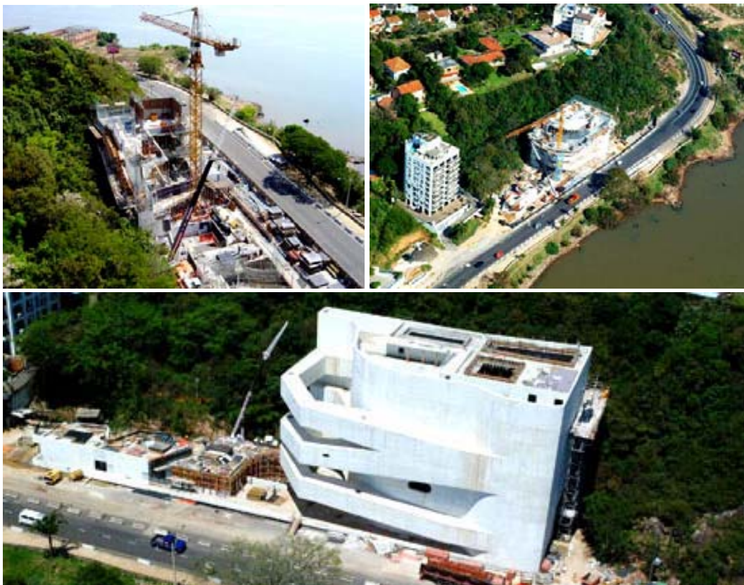
Vistas aéreas da construção do museu da Fundação Iberê Camargo.
