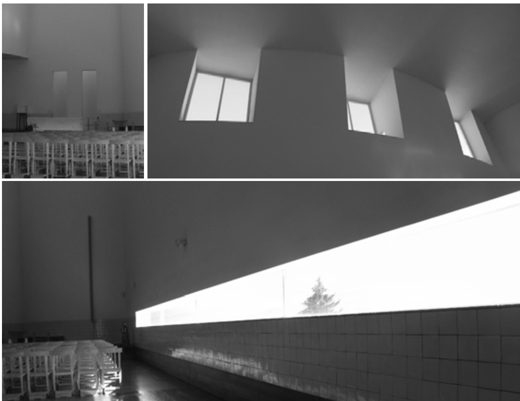
Rasgos verticais da parede atrás do altar, aberturas zenitais da parede abaulada e janela horizontal.
