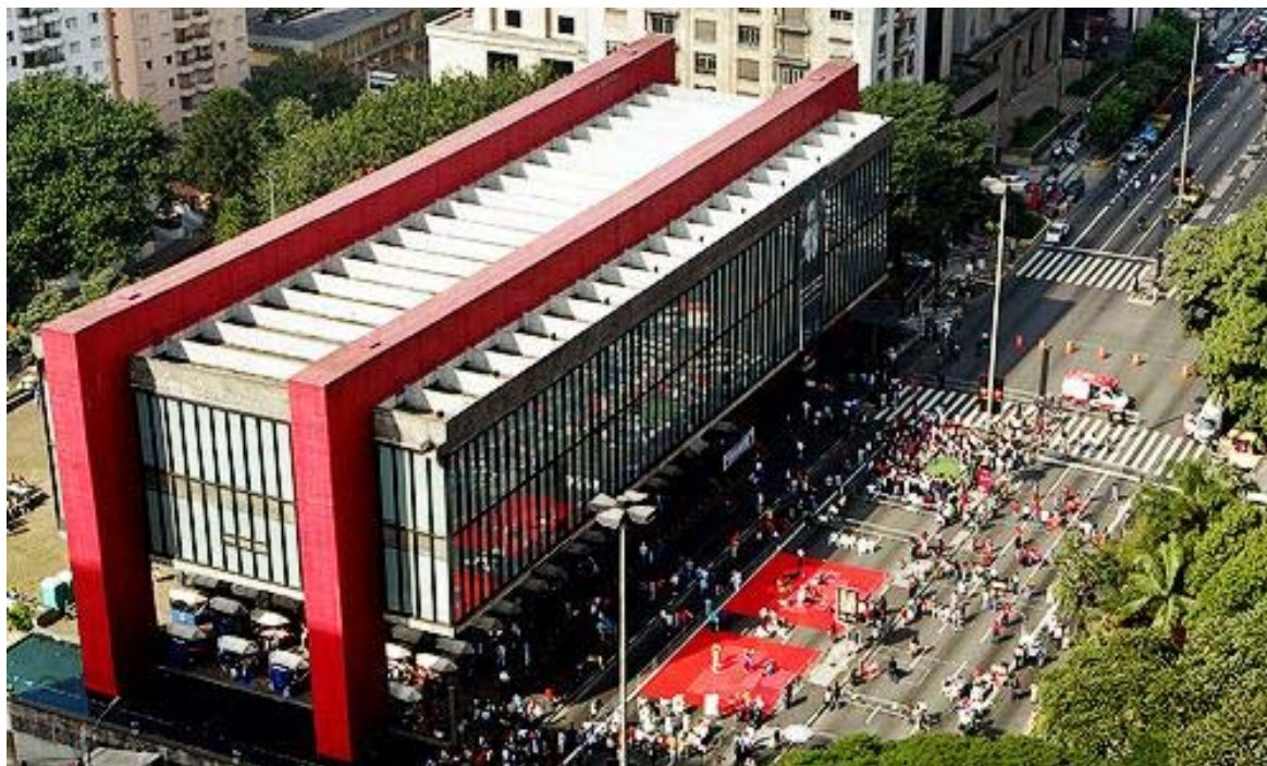
Figura 76: Vigas do Masp, São Paulo.
