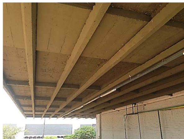
Figura 108: Detalhe da base das Vigas Transversais. Fonte: Imagem do Autor.
