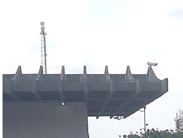
Figura 110: Detalhe da altura da Viga Mestra aparente no conjunto. Fonte: Imagem do Autor.
