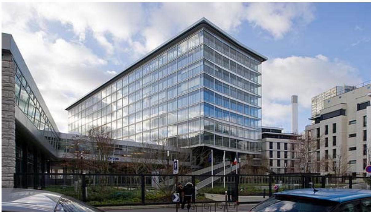
Figura 82: Edifício Principal da Sede da Caixa Central de Alocações Familiares após reforma, Paris, 1955-1959. Raymond Lopez e Marcel Réby. Fonte: Internet domínio público.
