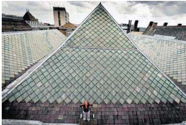
Figura 28: Detalhe da cobertura em ferro e vidro. Fonte: Internet domínio público.
