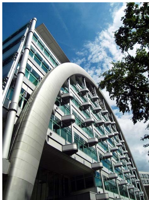
Figura 66: Detalhe dos tirantes sob o arco e da barra que sustenta os pavimentos avançados. Fonte: Internet domínio público.
