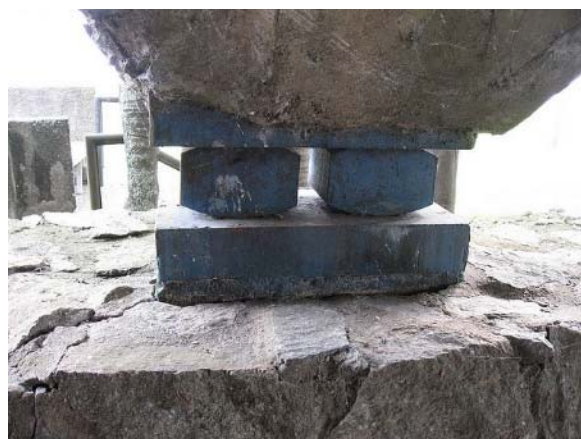
Figura 51: Detalhe das rótulas.
