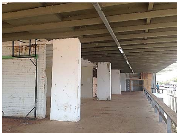
Figura 107: Detalhe Pilares, Viga Mestra e Vigas Transversais. Fonte: Imagem do Autor.
