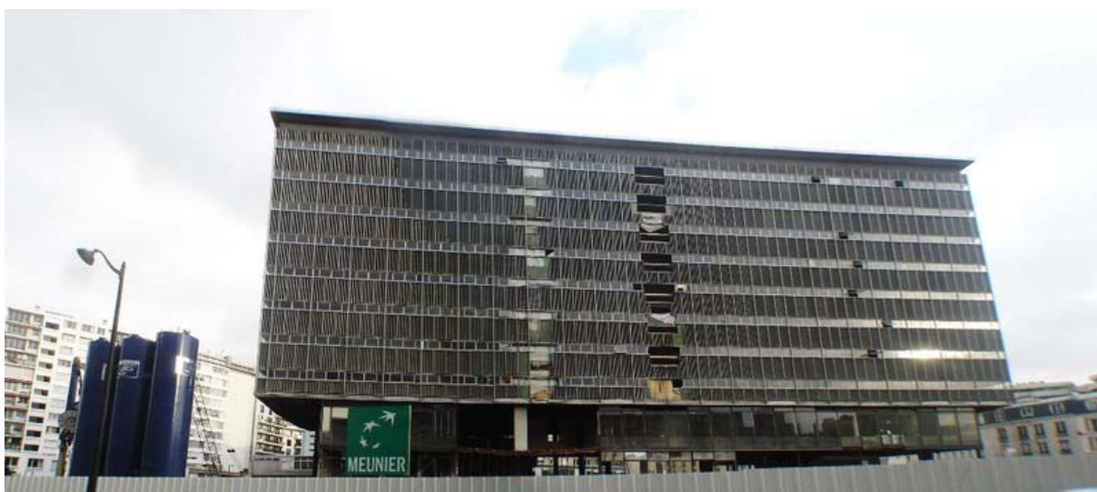
Figura 83: Edifício Principal da Sede da Caixa Central de Alocações Familiares, Paris, 1955-1959. Raymond Lopez e Marcel Réby. Fonte: Internet domínio público.
