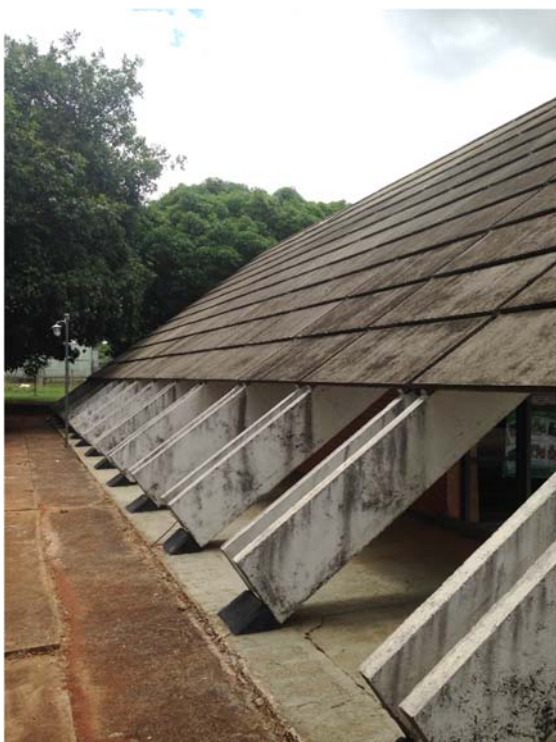
Figura 37: Detalhe da viga formato 'U' e das placas de concreto pré-moldadas. Fonte: Imagem do Autor.
