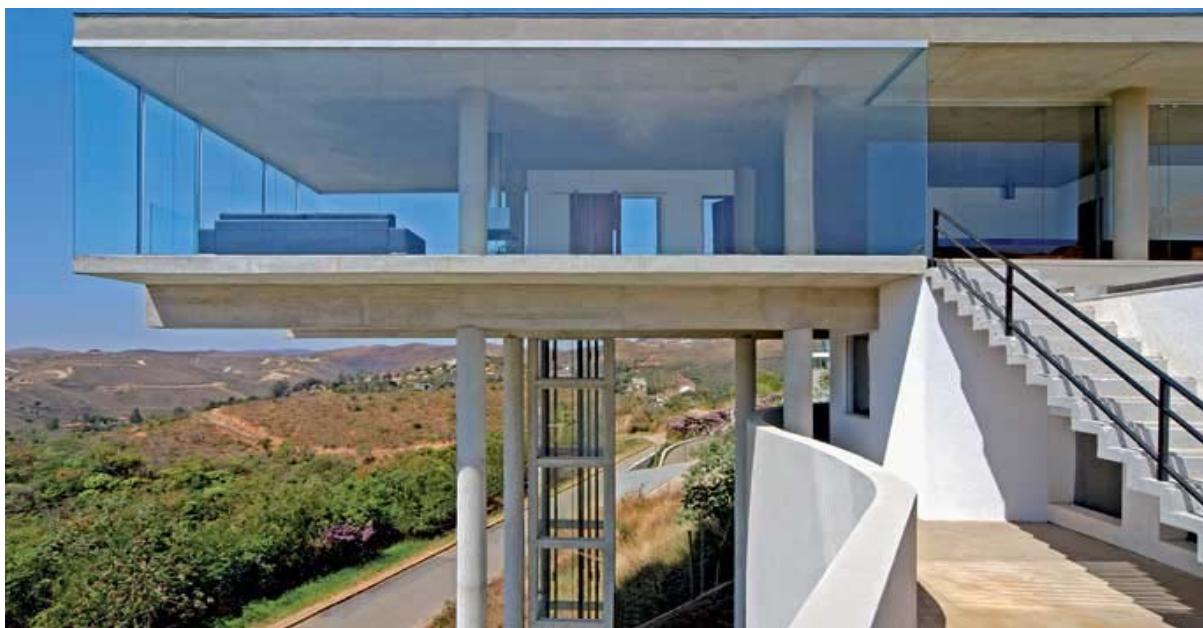
Figura 79: As barras vigas e pilares.
