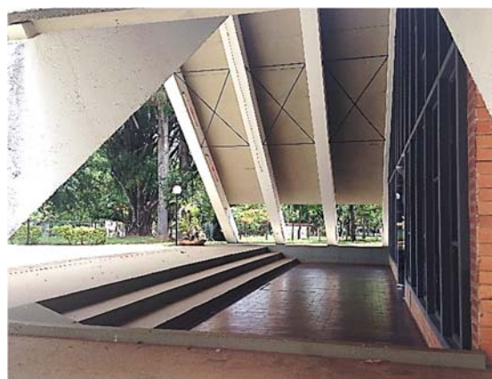
Figura 39: Detalhe do rebaixamento da nave. Fonte: Imagem do Autor.
