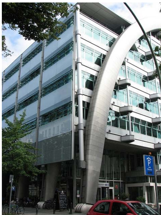
Figura 65: Detalhe da barra apoiada sobre o arco. Fonte: Internet domínio público.
