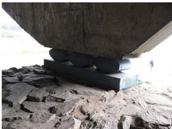
Figura 50: Detalhe das rótulas.
