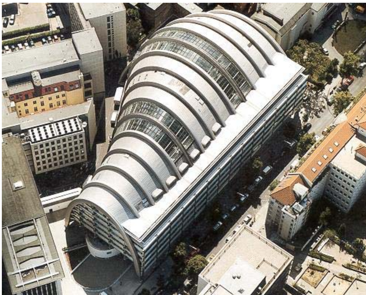
Figura 57: Vista aérea da Casa Ludwig Erhard. Fonte: Internet domínio público.
