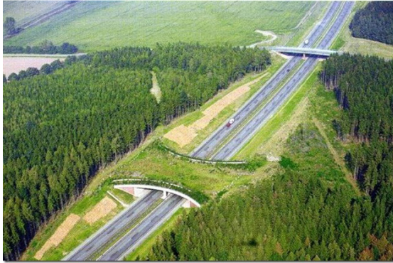
Ecoponte da Highway A20 (Alemanha)
