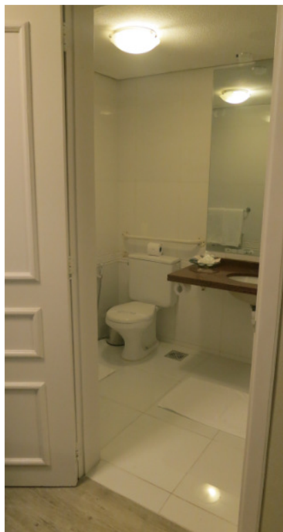
Porta do banheiro é mais larga. Próximo ao vaso sanitário existe barra de segurança
