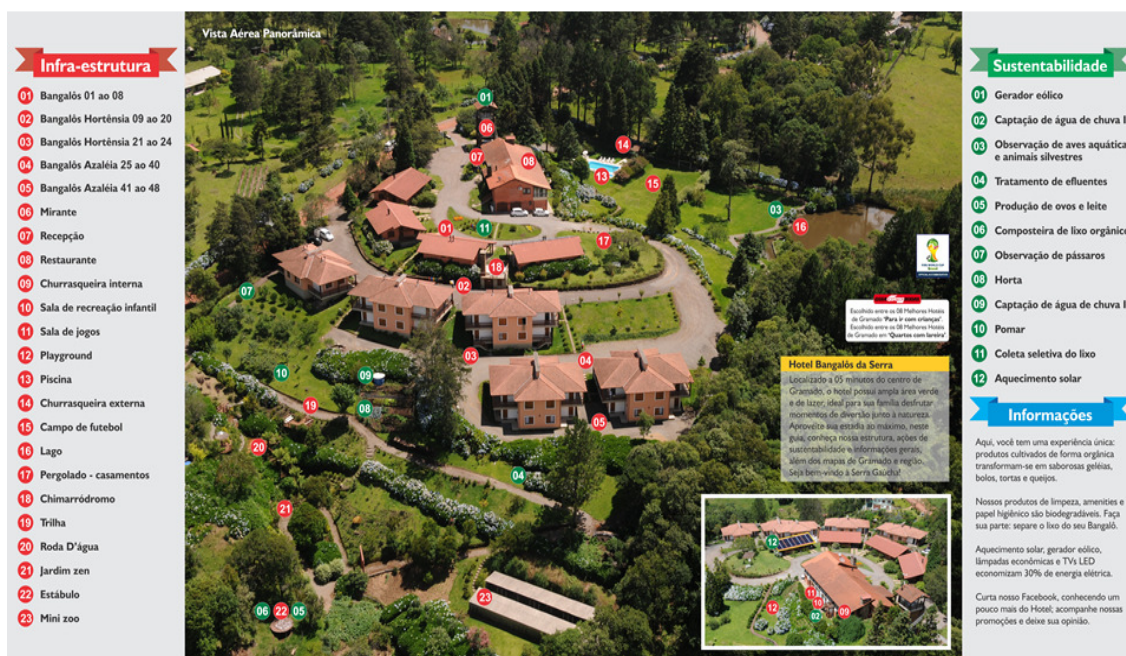
Figura 54 – Vista aérea do Hotel Bangalôs da Serra Fonte: Bangalôs da Serra (2014)
