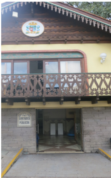
Banheiro público no mesmo prédio do Centro de Apoio ao Turista (centro da cidade) e com acessibilidade
