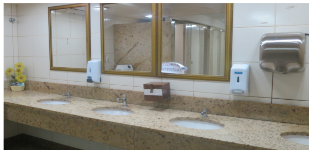
Torneira com controle automático de água, sabonete líquido e secadora elétrica de mãos
