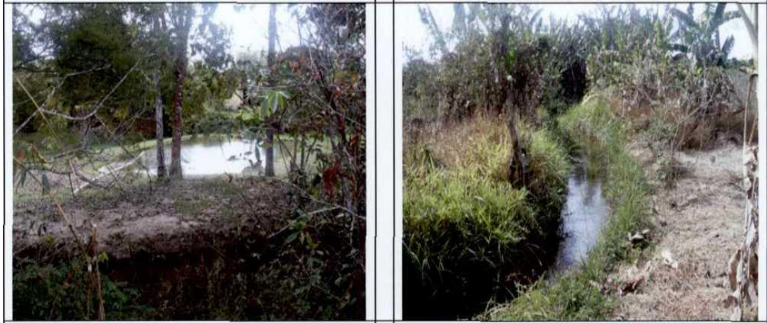
Figura 39 DEsvio do Córrego Mesquita feito por não quilombola, prejudicando os moradores a jusante-Fonte RTDI 2011
