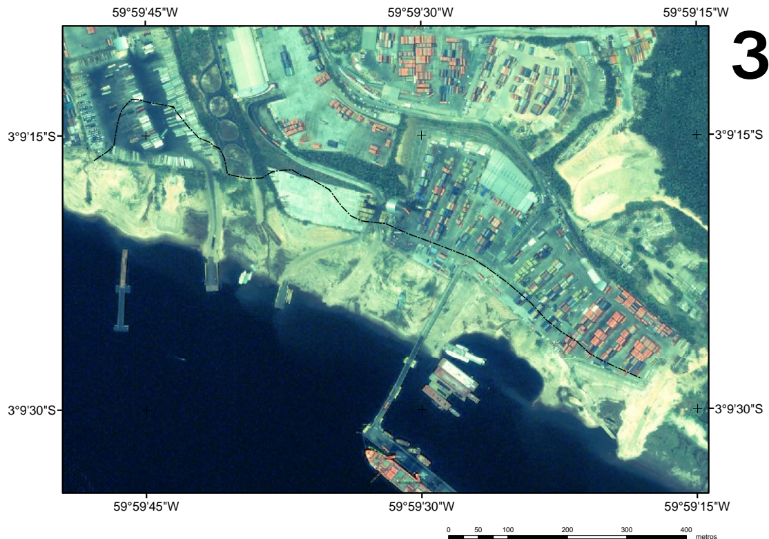
Figura 9: Vista superior do TUP com linha delimitando a ruptura. (Cavero et al., 2010)
