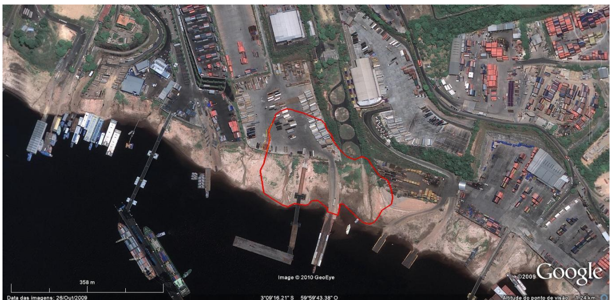
Figura 4: Foto do TUP Chibatão, em 2010 antes da ocorrência, com indicação da área diretamente afetada pelo deslizamento. (CPRM, 2010).
