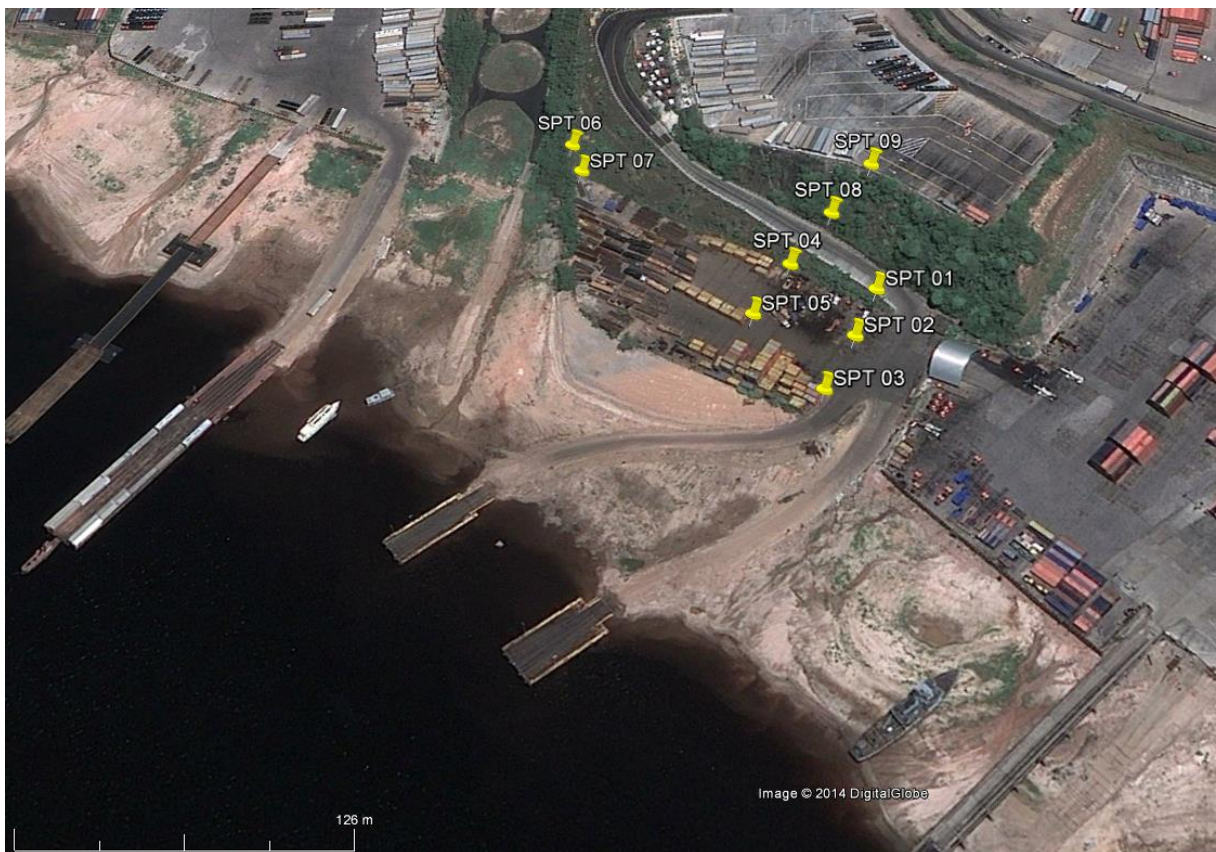
Figura 6: Localização dos pontos de sondagens SPT do terminal de Chibatão e vista superior da área anterior ao deslizamento.
