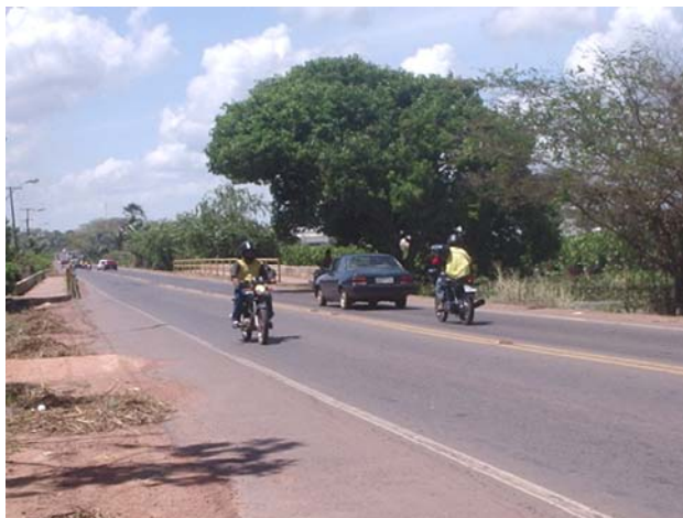
Figura 14: Ponte de concreto sobre a Lagoa dos Índios, na rodovia Duque de Caxias.
