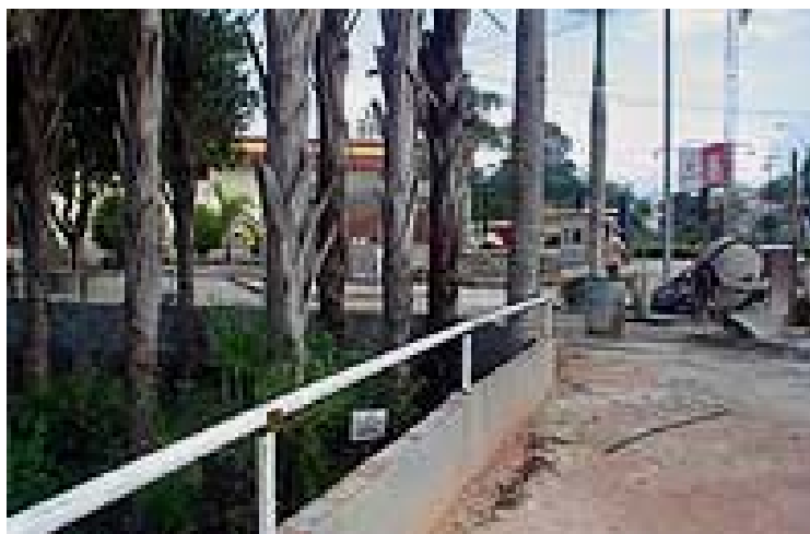
Figura 21: Obras de ampliação do terreno do senhor Odilon Filho na borda da Lagoa dos Índios.
