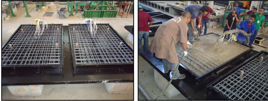
Figura 3.24 – Lançamento do concreto bombeado
