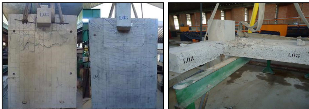
Figura 4.20 – Visão geral de fissuração nas faces superior, inferior e no corte da laje L08
