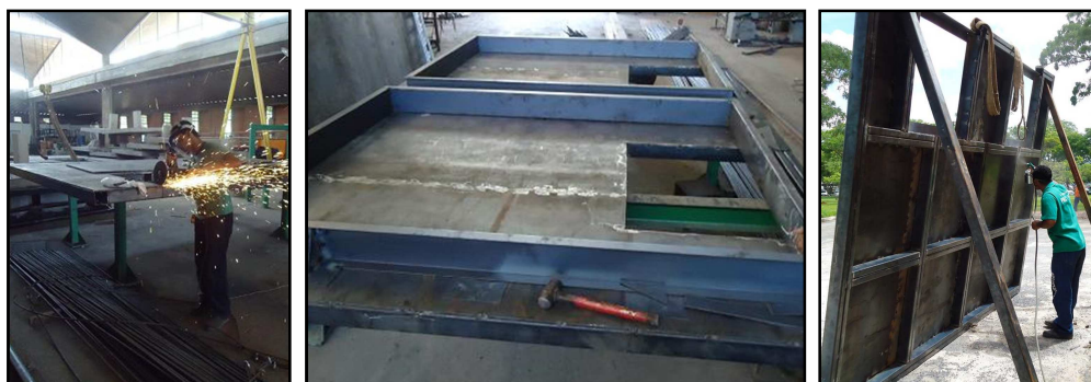
Figura 3.18 – Confeção das formas de aço
