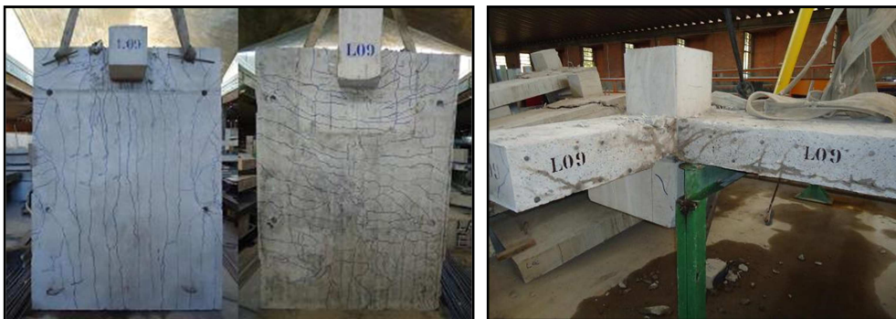
Figura 4.22 – Visão geral de fissuração nas faces superior, inferior e no corte da laje L09
