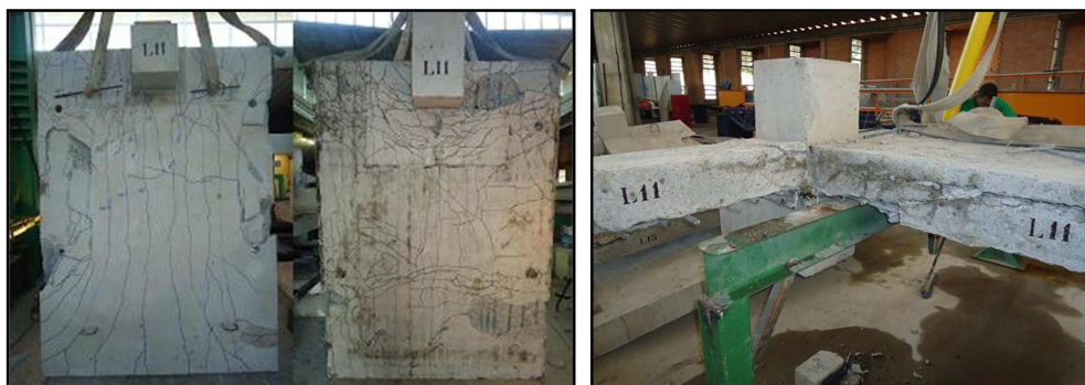
Figura 4.26 – Visão geral de fissuração nas faces superior, inferior e no corte da laje L11
