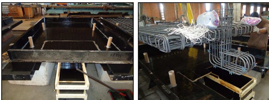
Figura 3.22 – Aplicação de desmoldante e movimentação da armadura
