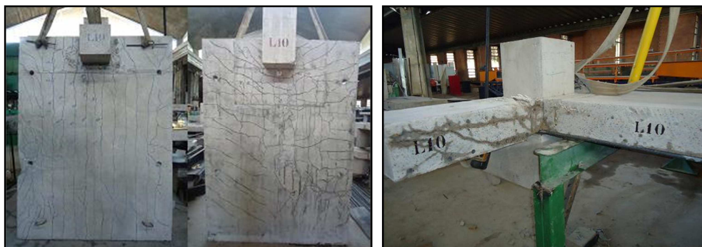
Figura 4.24 – Visão geral de fissuração nas faces superior, inferior e no corte da laje L10
