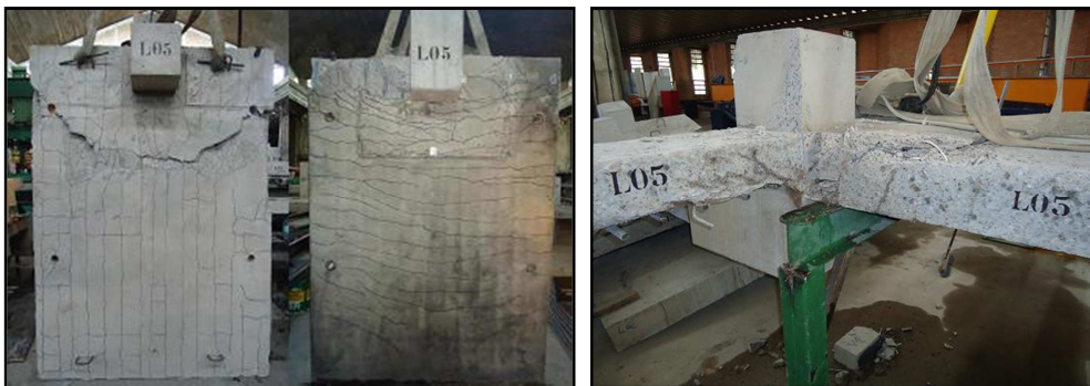
Figura 4.14 – Visão geral de fissuração nas faces superior, inferior e no corte da laje L05
