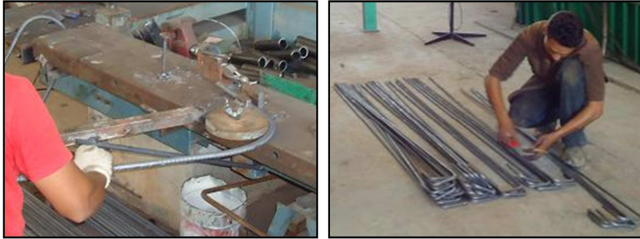
Figura 3.20 – Corte e dobra das armaduras
