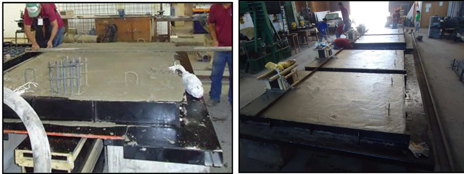
Figura 3.25 – Regularização da superfície da laje
