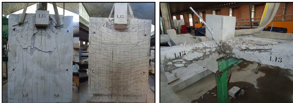
Figura 4.30 – Visão geral de fissuração nas faces superior, inferior e no corte da laje L13
