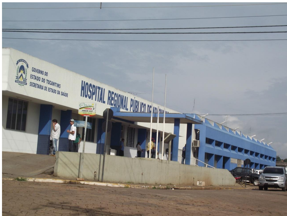
FIGURA 12 - Fachada do Hospital Regional de Araguaína
