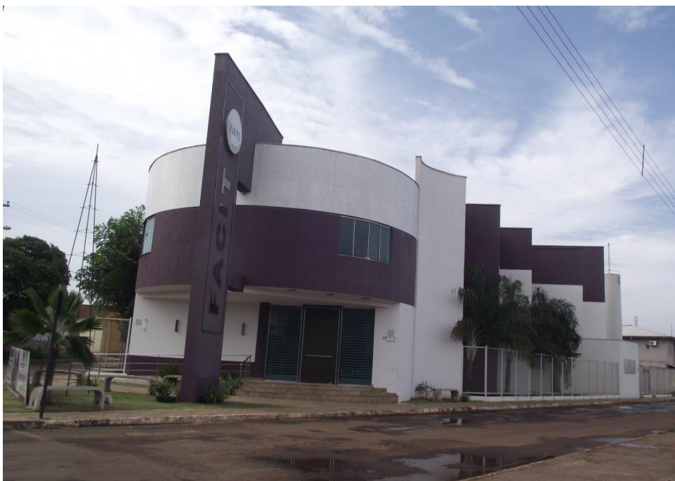
FIGURA 15 - Fachada da Faculdade FACIT, em Araguaína
