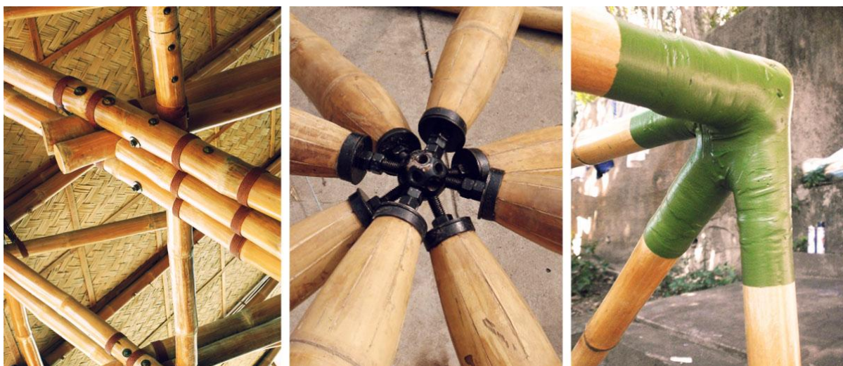
Figura 13 - Encaixes utilizados na construção com bambu Fonte: Icheng (2011)
