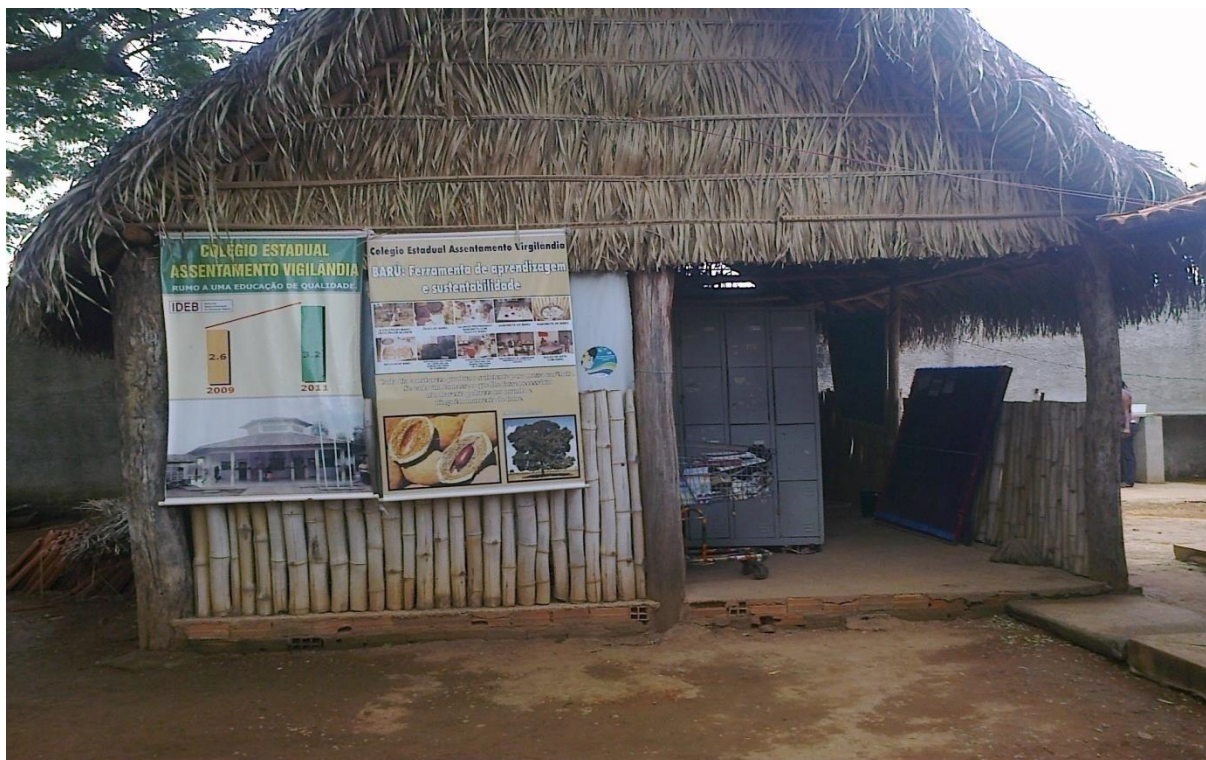
Foto 4 – Biblioteca da Escola Estadual do Assentamento Virgilândia
