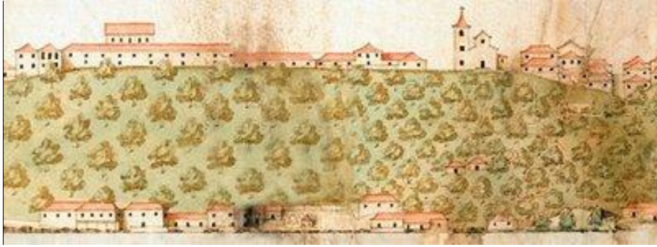
Figura 7: Vista geral da praça da Sé e Misericórdia em detalhe da figura 6.
