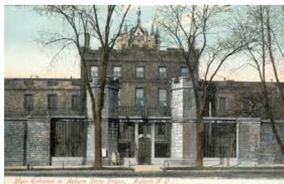
Figura 11: Fachada da Prisão de Auburn, Nova Iorque
