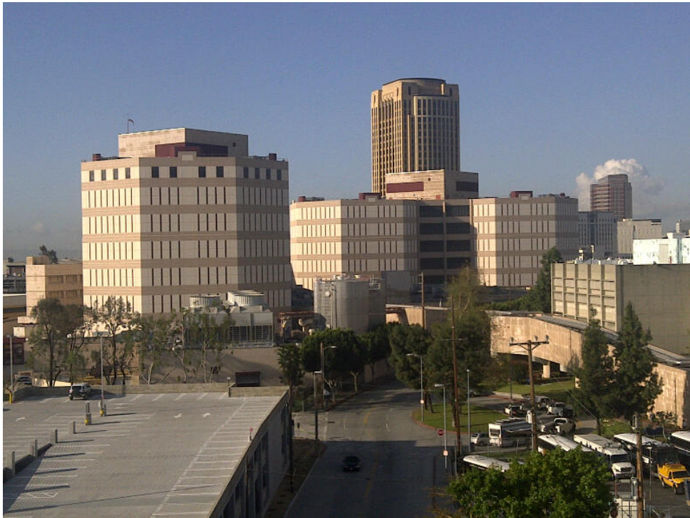
Figura 80: Torres gêmeas, cada uma composta de 2 edifícios interconectados entre si.
