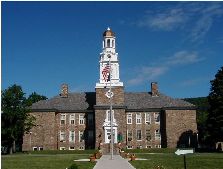
Figura 88: Edificação no complexo penitenciário feminino de Muncy, PA, Estados Unidos Foto/Divulgação do Sistema Correcional da Pensilvânia
