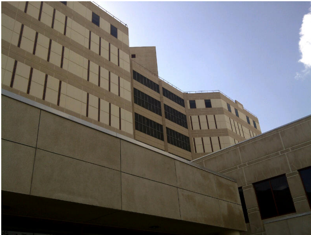
Figura 81: Aberturas somente para a entrada de luz, sendo as janelas integralmente fechadas com vidro
