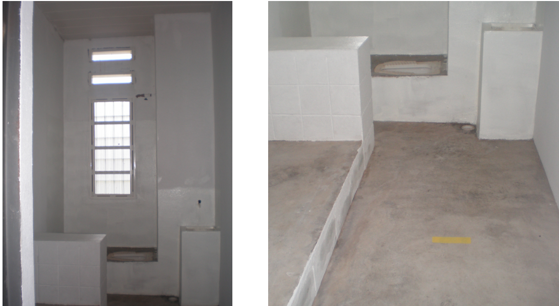
Figuras 69 e 70: Interior das celas, com cama e instalações sanitárias. Janela com vidro jateado e grade e abertura para ventilação.
