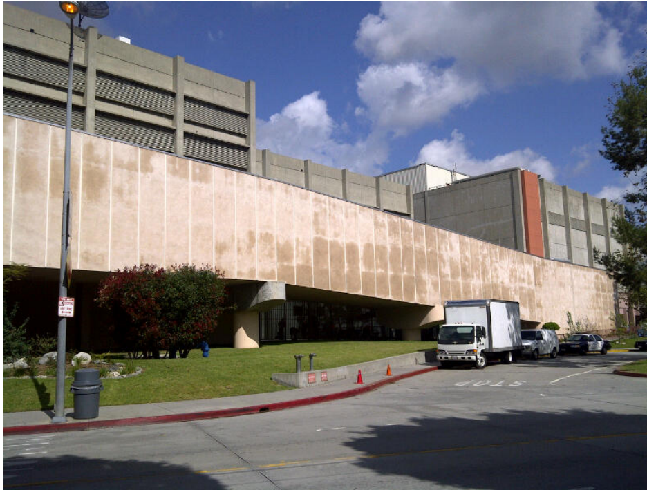
Figura 83: Passarela de ligação entre o prédio antigo e as torres gêmeas.
