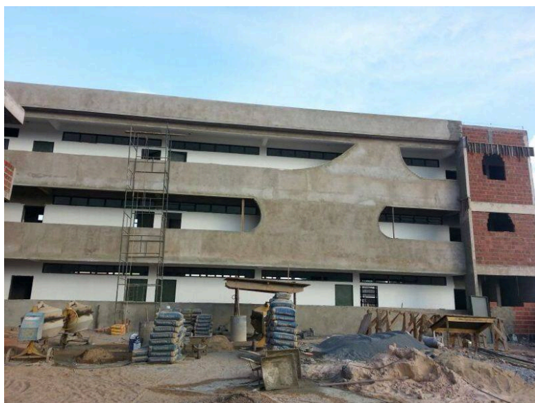
Figura 18 – Reconstrução da Sede do CILT
