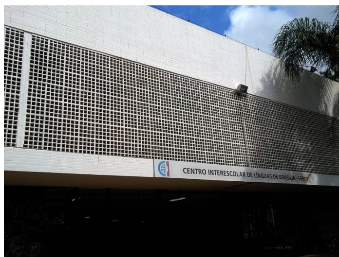
Figura 9 – Fachada do CIL – Brasília
