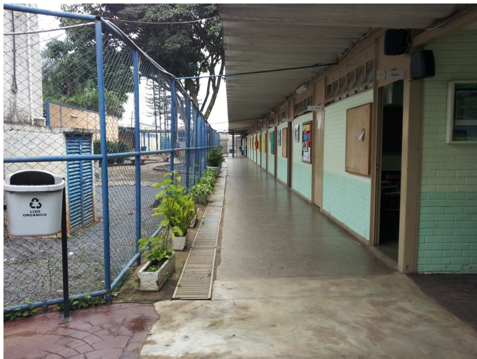
Figura 25 – Corredor das salas de aula do CILG
