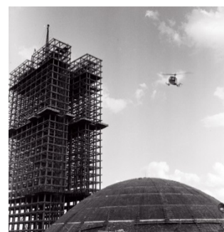
Figura 2 – Construção do Congresso
