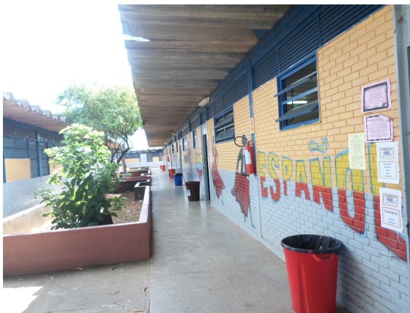
Foto 31 – Salas de Espanhol – CIL Gama
