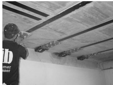
(a) Ancoragem da protensão
