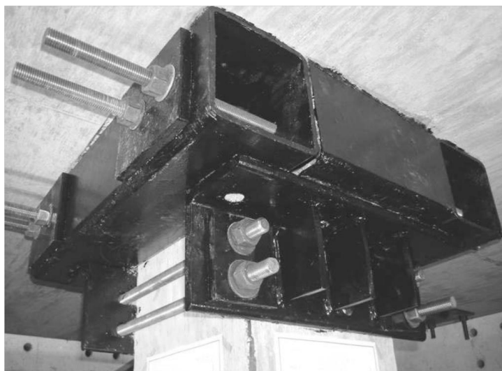
Figura 2.7 - Colar metálico na ligação laje-pilar (WIDIANTO, 2006)
