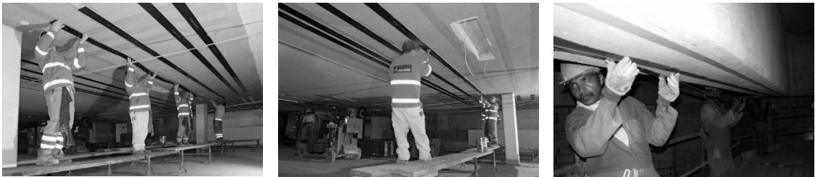
Figura 2.18 - Aplicação de PRF - Reforço à flexão
