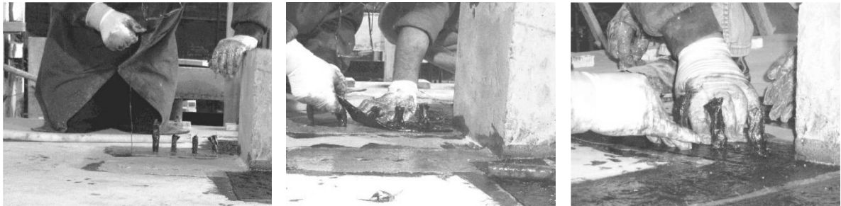
Figura 2.36 - Instalação do sistema dowel (ERDOGAN, 2010)
