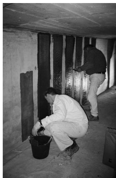
(c) Talbrücke Götzenhof - Alemanha
