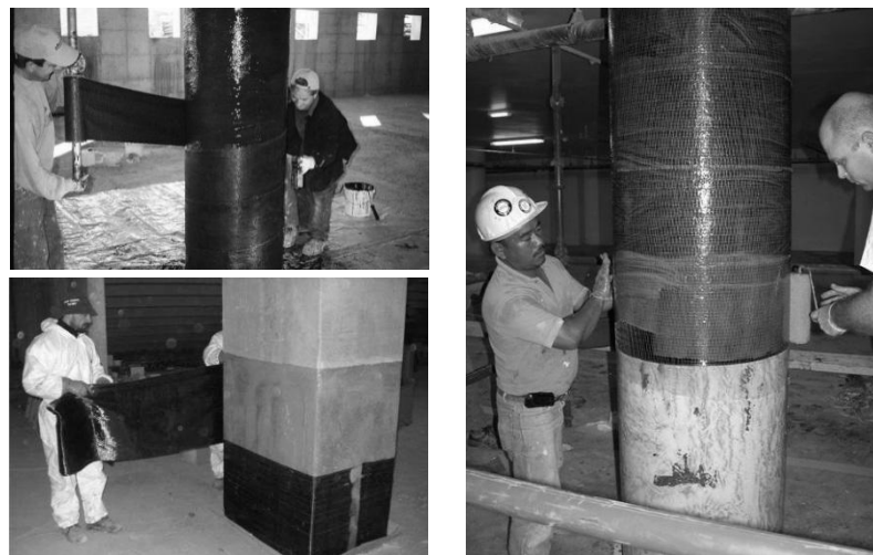
Figura 2.27 - Aplicação de PRF - Reforço de pilares
