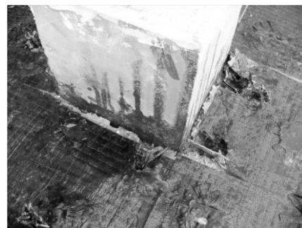
(b) Detalhe do reforço Dowel
