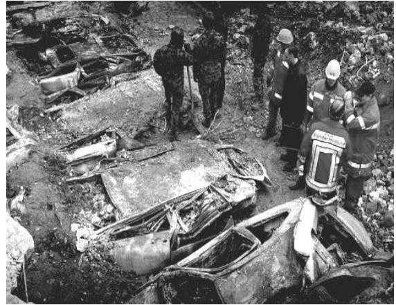
(b) Remoção dos escombros
