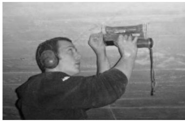
1 - Detecção e marcação da armadura inferior existente
