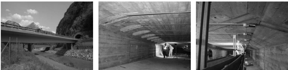
Figura 2.23 - Instalação do reforço protendido de PRF - Ponte Escherkanal, Suíça (2002) (HADDAD, 2012)
