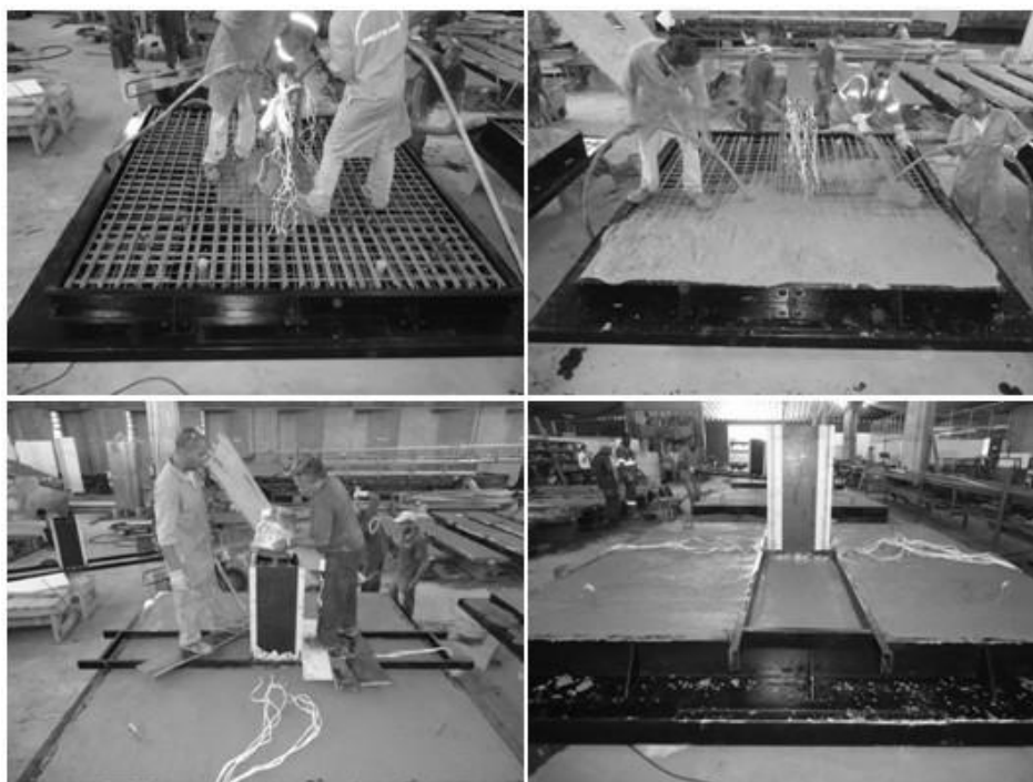
Figura 3.27 - Sequencia de concretagem das peças
