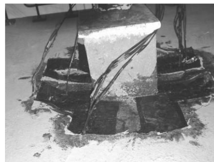
(b) Laje após o ensaio
