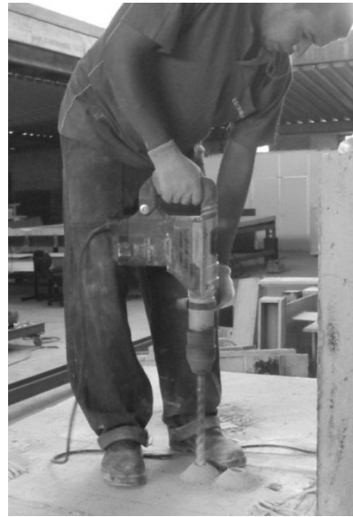
(b) Funcionário executando o furo
