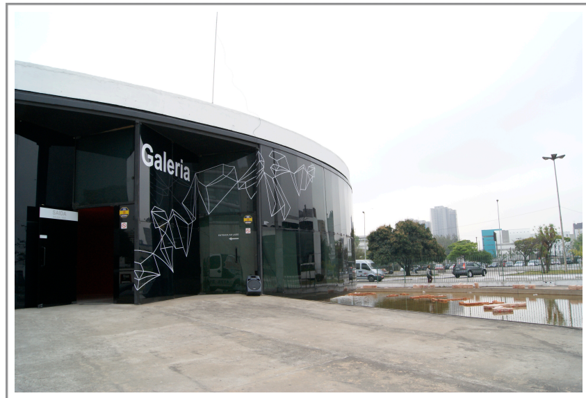
Figura 39: Alto da rampa de entrada da Galeria Marta Traba
