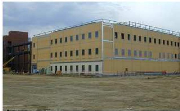
Figura 2.7 - Fotos de (a) Hospital Santa Clara Medical Center em construção; (b) vista close-up dos buckling-restrained braces (BRBs) instalados
