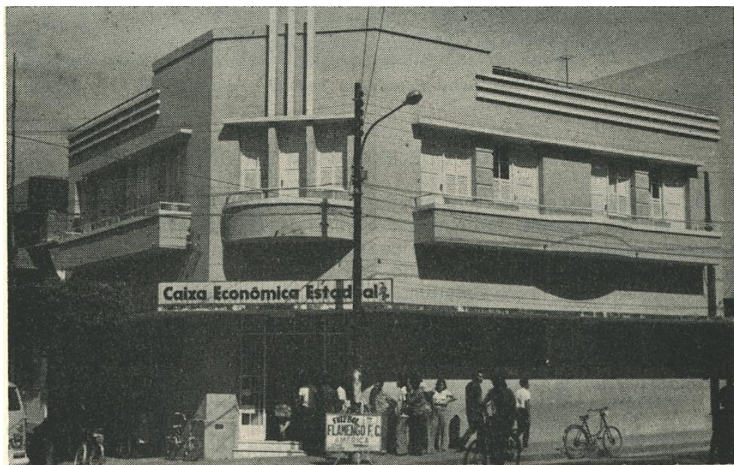
98. Agência da Caixa Econômica do Estado de Minas Gerais. (Costa, 1977, p. 453)
