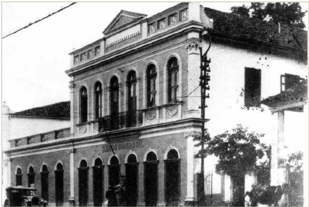
19. A edificação reformada já abrigando o Banco do Brasil (1921-1947). DEMPHAC.
