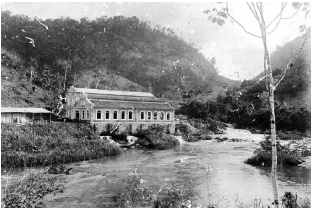
86. A Usina Maurício DEMPHAC.
