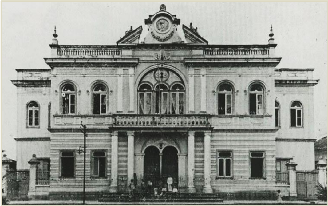
39. Fachada do Teatro Recreio. DEMPHAC.
