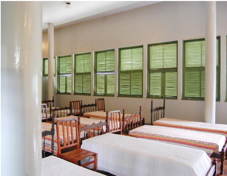
118. As janelas em veneziana pintadas de verde e os delgados pilares de seção circular independentes da vedação. (ALONSO, 2012, p. 47)
