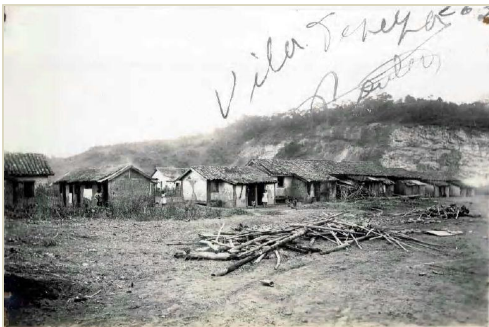
35. Casebres demolidos na Vila Tereza. DEMPHAC.
