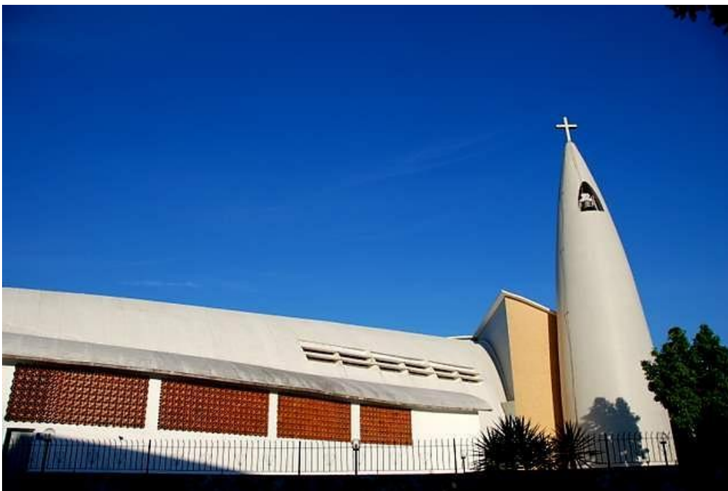
109. A nave modelada pela casca de concreto e torre sineira como marco vertical. Foto: Gualter Floresta.
