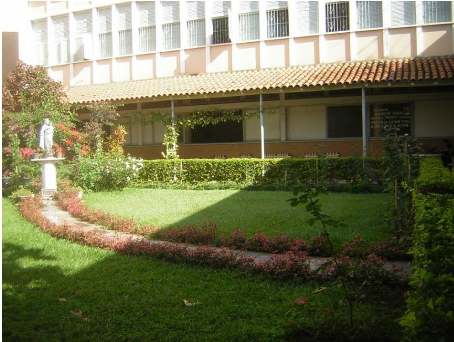
117. Vista do pátio e, ao fundo, o bloco com dois pavimentos. A modulação das janelas revela o rigor na composição do projeto. Acervo do autor.
