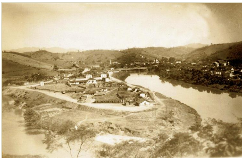
36. Vila Tereza, 1932: início das obras de Pedro Dutra. DEMPHAC.
