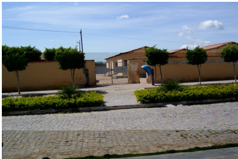
Figura 2 Colégio municipal Wilson Lins- Distrito Espraiado
