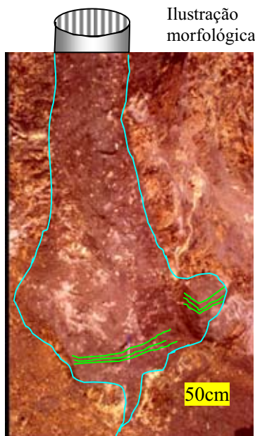
Figura II.112. Pipe do tipo III. Dividido em três partes: na base material fino na forma de um veio que parece alimentar o pipe. Na parte intermediária material particulado formando estratificações planas-paralelas e às vezes cruzadas. E na parte superior material brechado sustentado por matriz argilosa preta. A rocha hospedeira é a camada C2b composta de monazita e fosfatos secundários.
