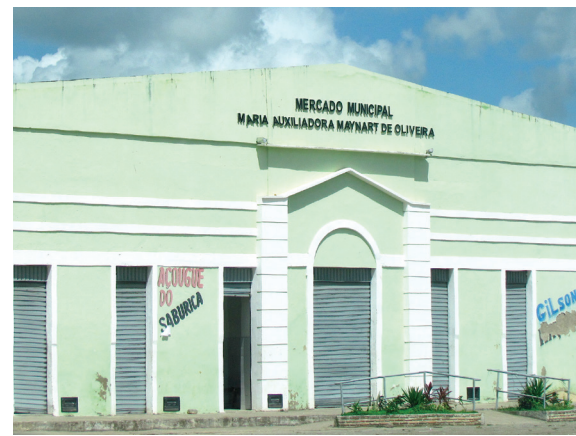
Atual Mercado Municipal, bem próximo ao complexo fabril. Foto: Suzete Bomfim, 2013.
