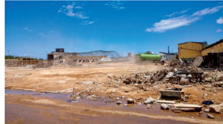
Demolição dos Galpões em outubro de 2013. Fonte: < www.infonet.com.br >
