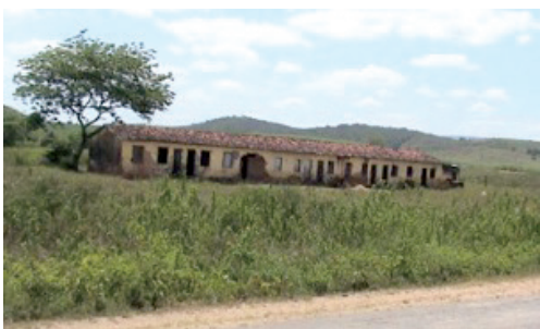
Foto: Antiga Senzala do Engenho da Penha, usado posteriormente para moradia de funcionários da usina. Foto: < http://www.hpip.org/Default/pt/Homepage/Obra/Imagens/Fotografia?a=1103 >
