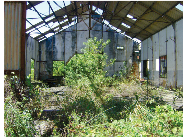
Galpão 01 – Vista interior. Foto: Suzete Bomfim, 2012.
