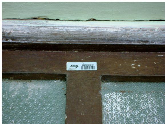
Detalhe da janela de uma das antigas casas de agente da Nova Estação. Foto: Suzete Bomfim, 2013.
