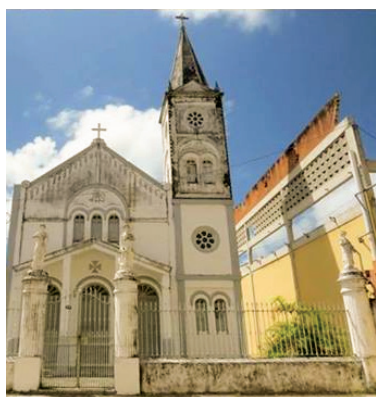
Capela e galpão em processo de demolição ao lado. Novembro de 2013.
