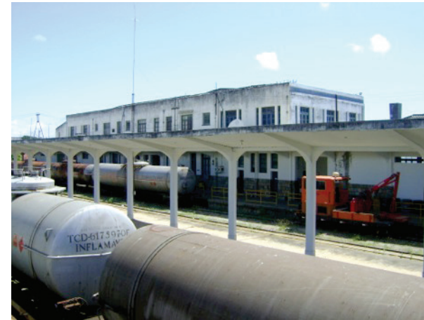
Ao fundo, fachada posterior da Estação. Platibanda discreta sem detalhes recortes geométricos como fachada frontal. Foto: Suzete Bomfim, 2012.
