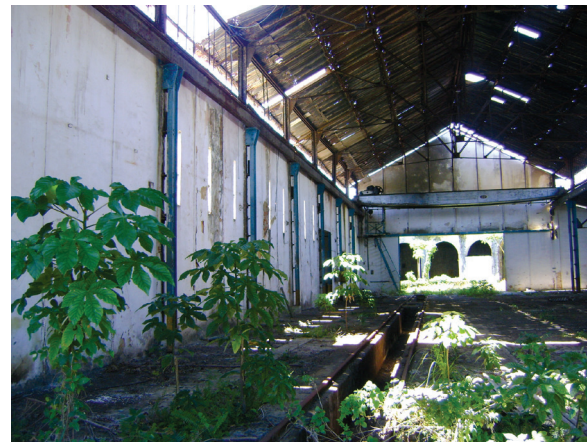
Galpão 02 – Vista interior. Foto: Suzete Bomfim, 2012.
