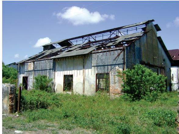
Galpão 01 – Vista exterior. Foto: Suzete Bomfim, 2012.
