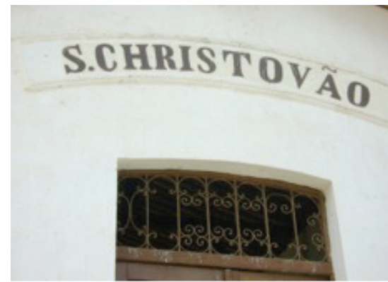
Detalhe da fachada Sudoeste com o nome da Estação. Foto: Suzete Bomfim, 2013.
