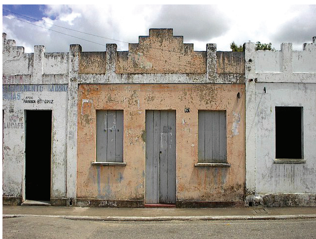
Fachadas da Rua Santa Luzia - tipo 01. Com alteração, surgimento da platibanda recortada, década de 1930. Foto: Suzete Bomfim, 2006.
