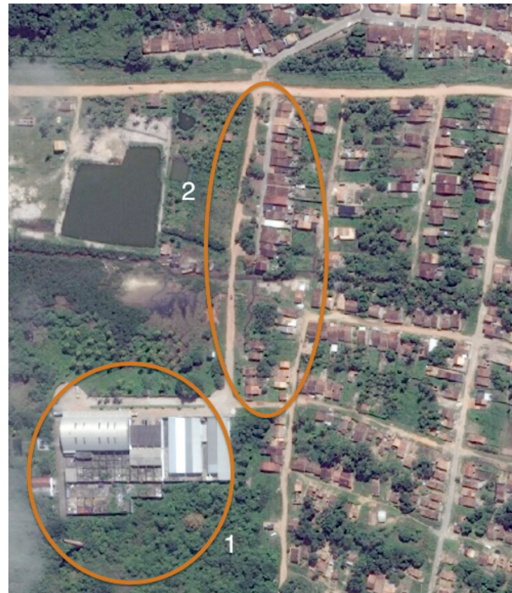
1. Galpões da Fábrica São Gonçalo. 2. Área da antiga Vila Operaria. Foto: google maps, com edição do autor.
