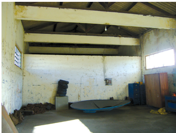
Vista do interior do armazém. Foto: Suzete Bomfim, 2012.
