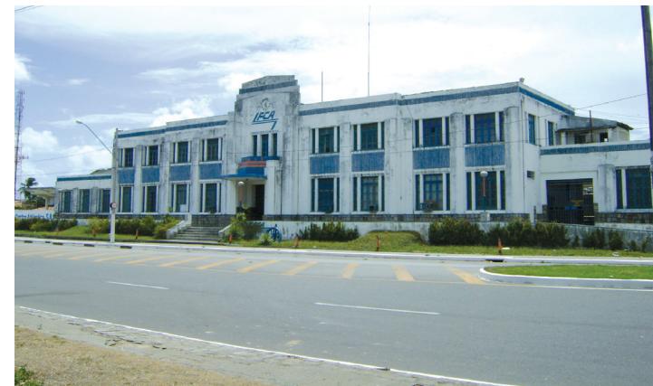
Detalhe do acesso, afastado do alinhamento da rua, com pequeno jardim frontal. Suzete Bomfim, 2012.
