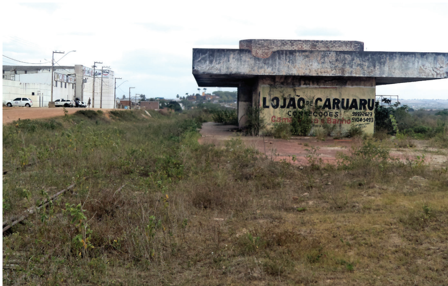
Fachada lateral da "Nova" Estação Ferroviária de Propriá. Trilhos paralelos à plataforma da Estação. Foto: Suzete Bomfim, 2013.
