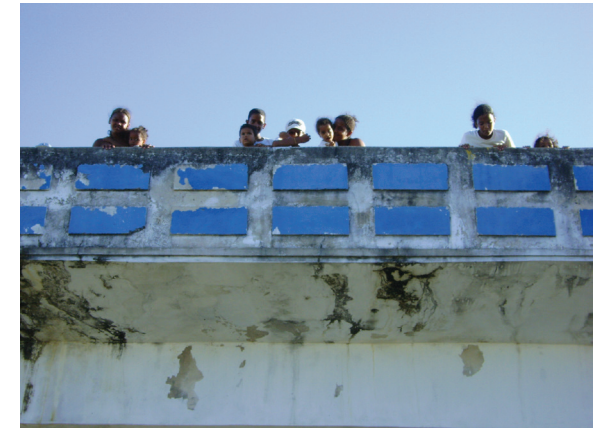
Vista parcial da passarela. Detalhes decorativos de caixas retangulares em alto relevo. Foto: Tamyres Fontenele, 2013.
