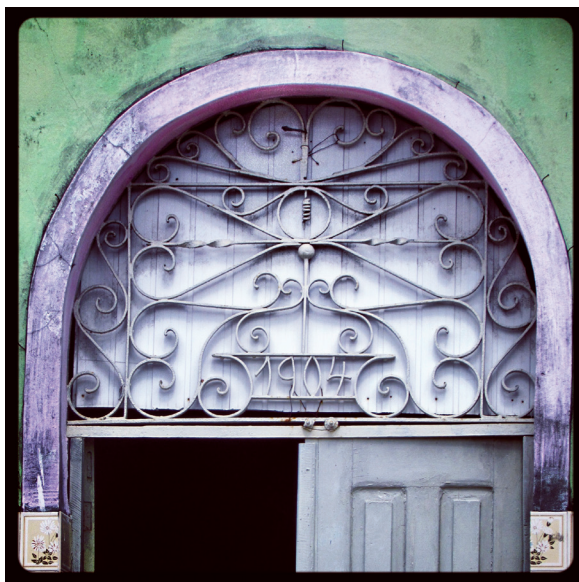
Detalhe do Casario da "Rua das Pedras". Foto: Suzete Bomfim, 2013.
