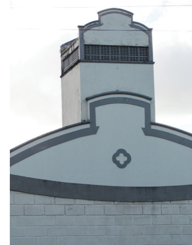
Detalhe da fachada – Galpões da Fábrica São Cristóvão. Foto: Suzete Bomfim, 2013.
