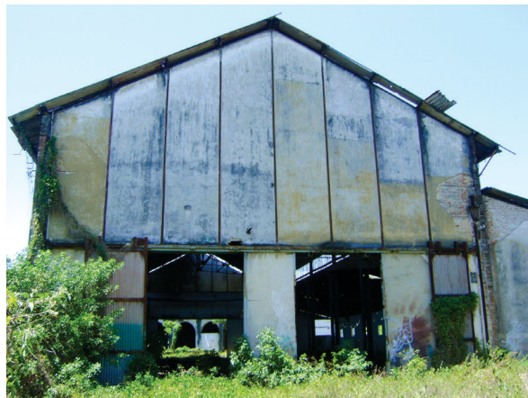
Galpão 02 – Vista exterior. Foto: Suzete Bomfim, 2012.
