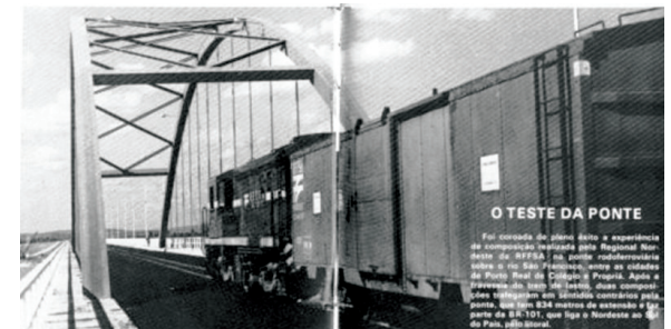
Travessia de trem sobre a ponte Sergipe/Alagoas. Fonte: < http://www.infonet.com.br/cidade/Antigas/interior/img-15.jpg >
