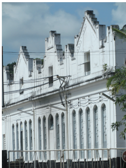
Vista Geral dos Galpões. Foto: Suzete Bomfim, 2013.
