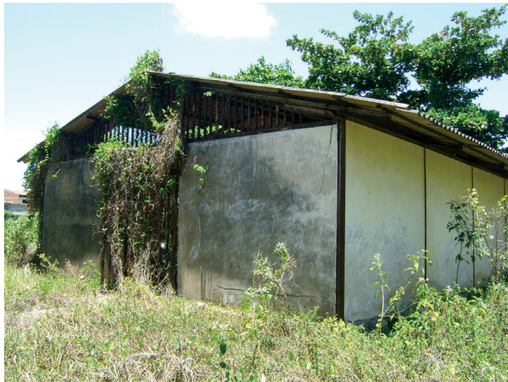
Galpão 05 – vista exterior. Foto: Suzete Bomfim, 2012.
