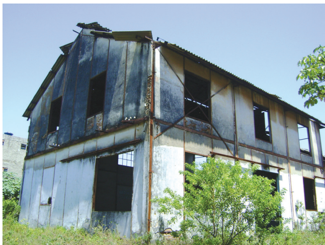
Galpão 03 – Vista exterior. Foto: Suzete Bomfim, 2012.
