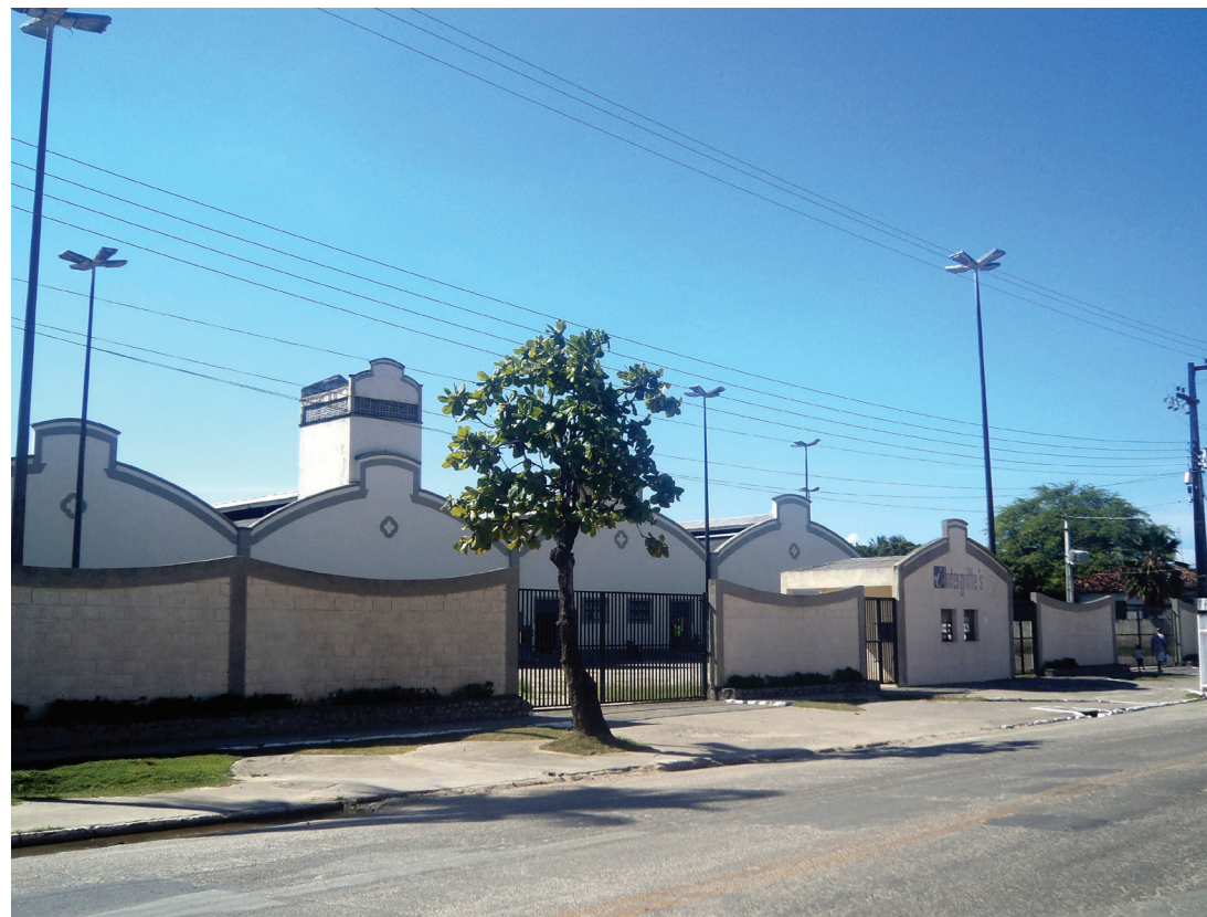
Vista Geral dos Galpões. Foto: Suzete Bomfim, 2013.
