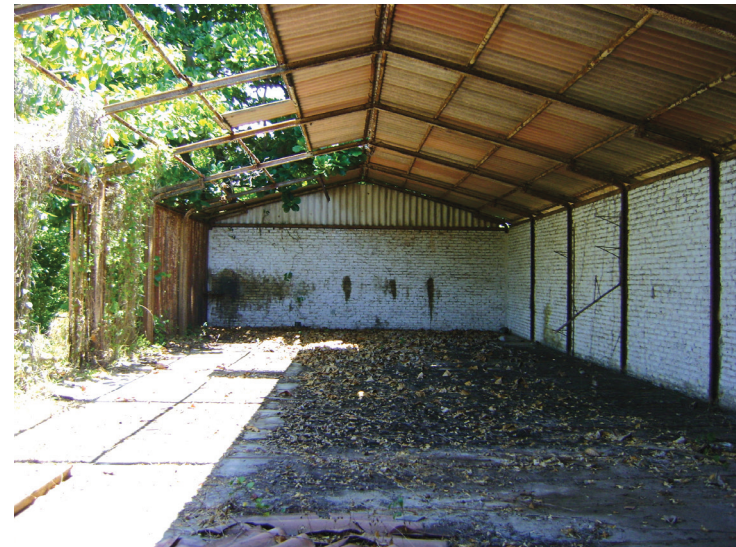
Galpão 05 – vista interior. Foto: Suzete Bomfim, 2012.
