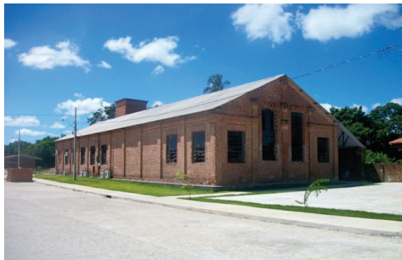
Edifício do complexo fabril de Rio Tinto utilizado pela Universidade Federal da Paraíba. Foto: < http://www.skyscrapercity.com/showthread.php?t=1346077 >
