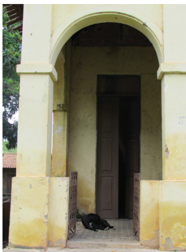
Detalhe da entrada, porta de acesso à sala de madeira, com duas folhas. Portico da entrada em arco pleno. Piso de ladrilho hidráulico. Foto: Suzete Bomfim, 2013.
