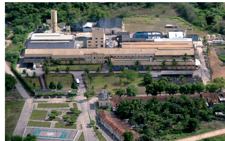
Vista aérea do Bairro Operário da Fábrica Sergipe Industrial. 2012. Fonte: < www.infonet.com.br >
