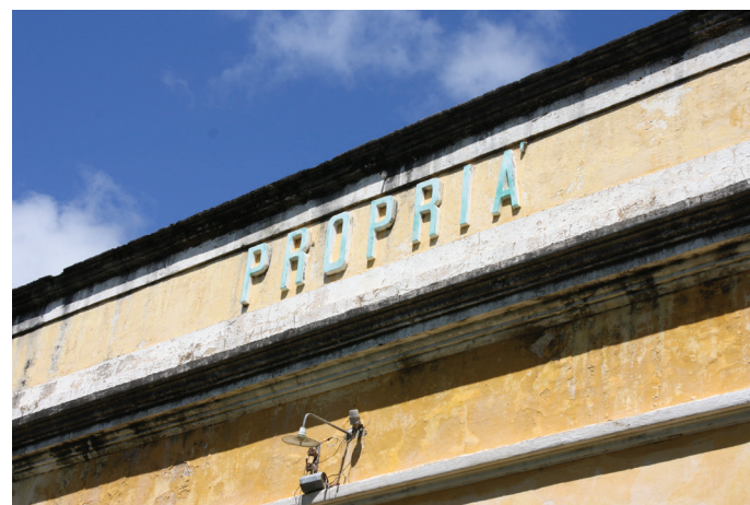
Detalhe da fachada – Nome da Estação. Foto: Suzete Bomfim, 2013.
