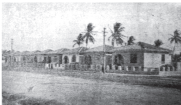
Casas da vila operária da Fábrica Confiança. Meados de 1920. Telhados de quatro águas, varanda e recuo lateral entre elas. Fonte: http://sergipeemfotos.blogspot.com.br
