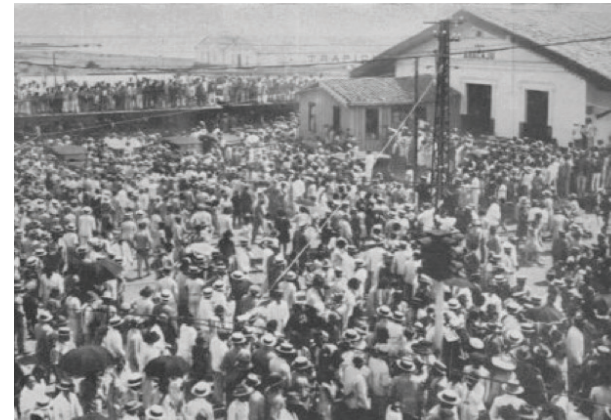
Estação Ferroviária de Aracaju na época da revolução de 1930. Fonte: Sessão do Patrimônio da extinta RFFSA.
