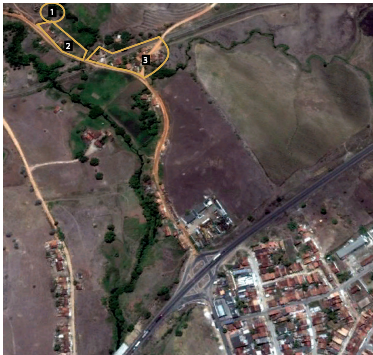
1. Reservatório de água de apoio à antiga Estação; 2. Antiga vila operária e demais casas de ocupação irregular; 3. Área da antiga Estação e Garagem (demolidos) e Casa do Agente. Foto: Google Maps com edição do autor.
