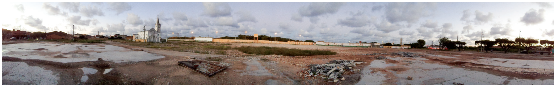
Área do complexo fabril totalmente demolido em março 2014. A capela foi mantida. Foto: Suzete Bomfim, 2014.
