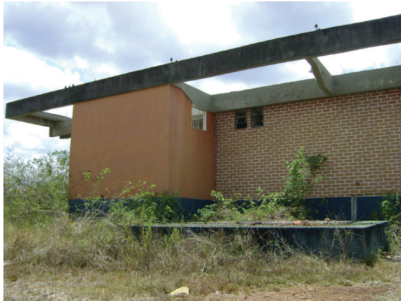
Estação Ferroviária – detalhe da fachada posterior. Pela volumetria, provavelmente era o banheiro de apoio. Foto: Suzete Bomfim, 2013.
