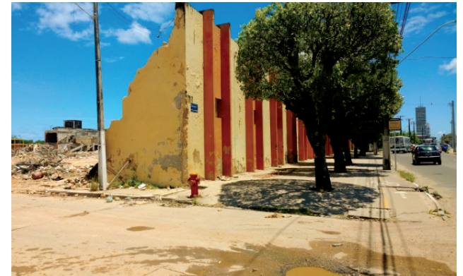
Início da demolição da Fábrica Sergipe Industrial em novembro de 2013. Fonte: Infonet, 2013.
