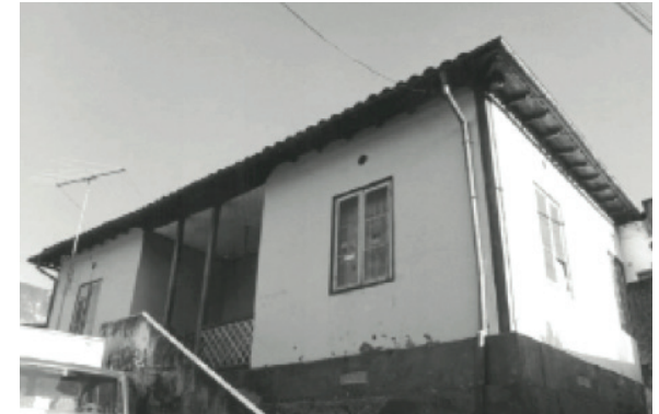
Nova Lima, Minas Gerais. Casas para gerentes da Mina de Morro Velho. Foto: 1998, Philip Gunn.
