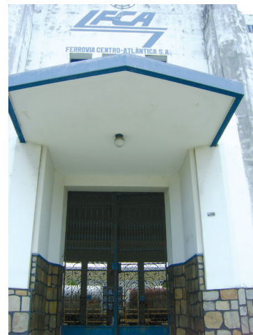
Detalhe da Fachada – Marquise que enfatiza a entrada. Foto: Suzete Bomfim, 2012.
