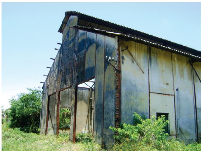
Galpão 04 – vista exterior. Foto: Suzete Bomfim, 2012.
