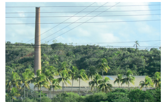
Vista do grande vão com cobertura semicircular, alteração nos antigos galpões da Fábrica São Gonçalo. Foto: Suzete Bomfim, 2013.
