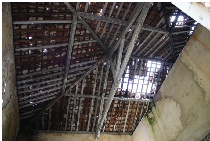
Detalhe da cobertura – Estrutura de madeira, com tesouras e telha cerâmica tipo colonial. Foto: Suzete Bomfim, 2013
