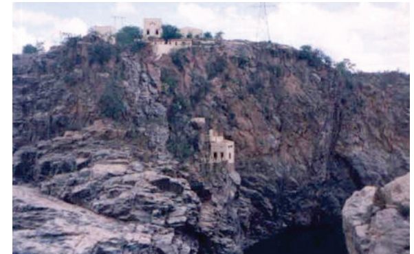
Angiquinho, primeira hidrelétrica da região, aproveitando a cachoeira de Paulo Afonso, no Baixo São Francisco. Foto: Suzete Bomfim, 2008.
