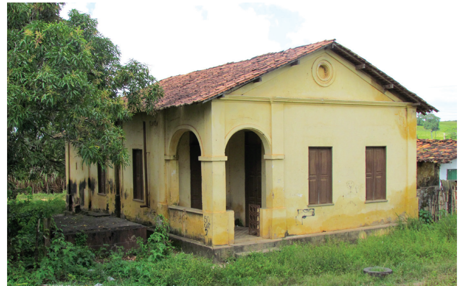
Casa de Agente próxima à Estação em Maruim, Sergipe. Foto: Suzete Bomfim, 2013.
