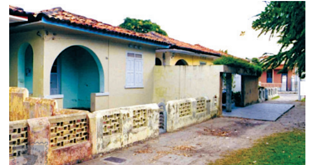
Estado atual das casas da antiga vila operária da Fábrica Confiança. Muitas casas foram demolidas, e algumas que restaram sofreram alterações, pois são propriedade particular. Foto: Suzete Bomfim, 2012.
