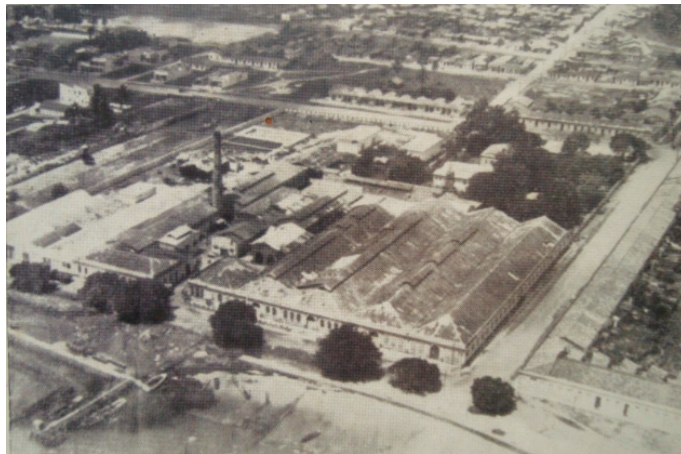
Vista aérea dos galpões e vila operária da Fábrica Confiança
