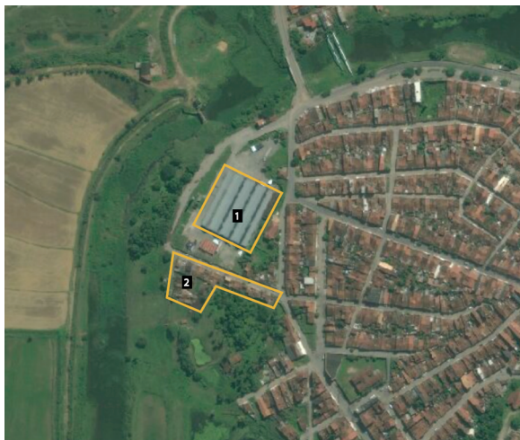
1. Galpões da Fábrica na ampliação para área mais afastada das margens do Rio São Francisco, na década de 1940; 2. Área da antiga Vila operária. Fonte: Google Maps com edição do autor.
