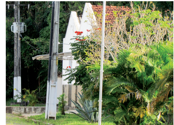
Edifício com Fachada e telhado original da Fábrica São Gonçalo.
