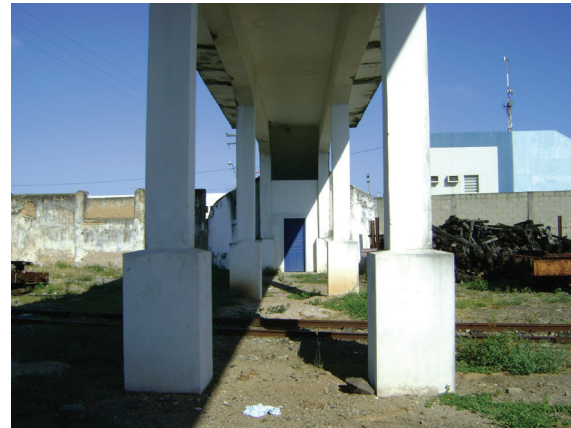
Vista parcial da passarela – porta de acesso pela área dos trilhos. Foto: Tamyres Fontenele, 2013.
