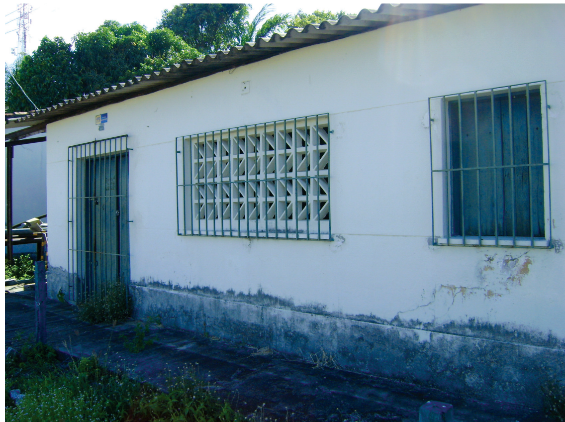
Detalhe da fachada frontal, porta de acesso com abertura em duas folhas, uma abertura em cobogó e outra janela de madeira com duas folhas. Suzete Bomfim, 2012.
