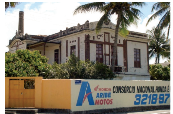
Sobrado do início do século XX no Complexo da Fábrica Confiança, chaminés ao fundo. Fotos: Kleber Rocha Queiroz, 2010.
