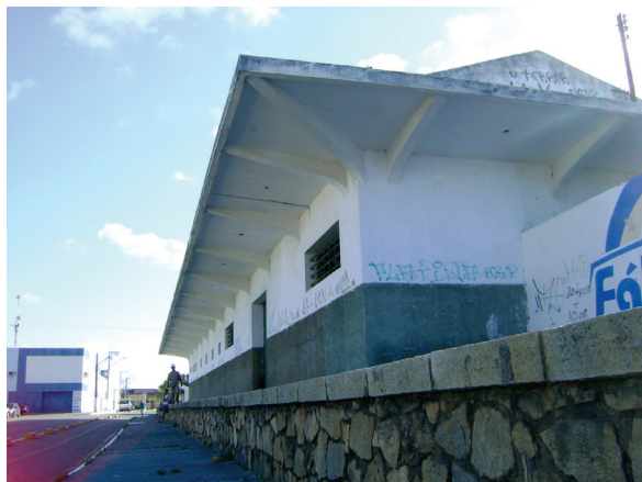
Fachada Posterior, com platibanda acompanhando o telhado em duas águas, percebemos a base cantaria de pedras, deixando o edifício acima no nível da rua. Foto: Suzete Bomfim, 2012.
