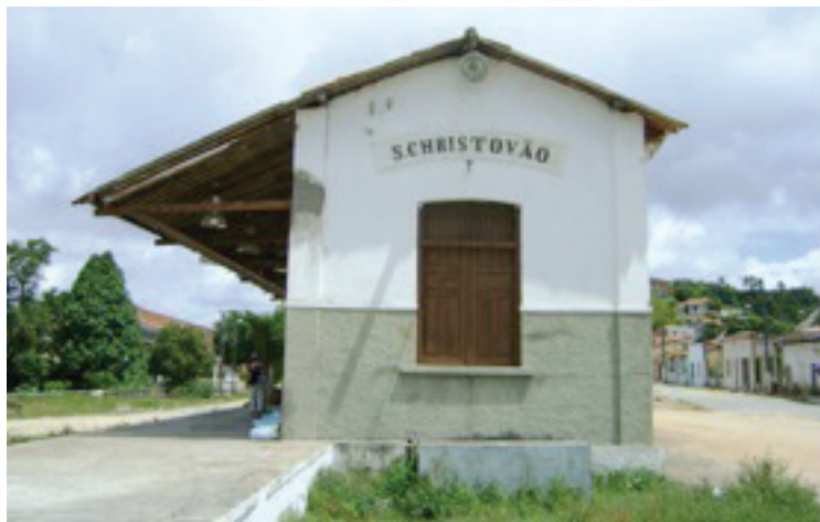
Fachada Nordeste, grande janela de madeira inserida simetricamente, abaixo do nome da Estação. Foto: Suzete Bomfim, 2013.
