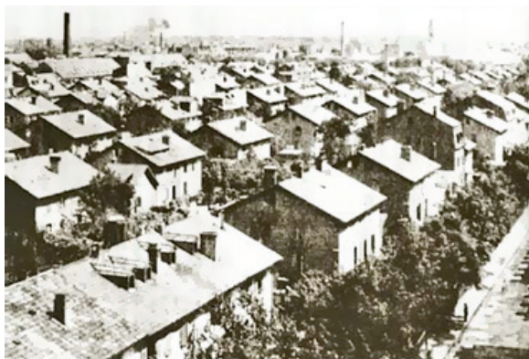
Vista das Cites Ouvrières.
