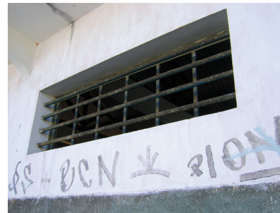
Detalhes das janelas, apenas o vão com peitoril de h= 1.70m, com fechamento em gradil de ferro. Foto: Suzete Bomfim, 2012.
