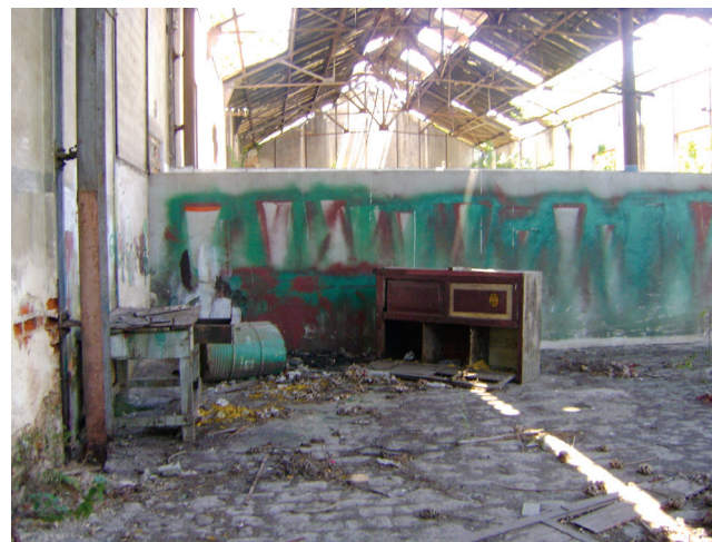
Galpão 03 – Vista interior. Foto: Suzete Bomfim, 2012.
