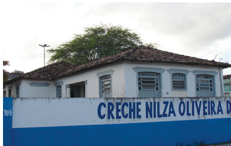
Detalhe da cobertura. Foto: Suzete Bomfim, 2013.
