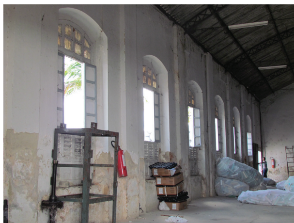
Vista interna de um dos galpões. Estrutura e telhas metálicas em formato semicircular. Foto: Suzete Bomfim, 2013.
