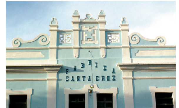
Detalhe da Fachada Principal. Foto: Suzete Bomfim, julho de 2006
