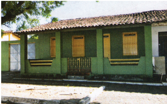
Tipo 1- Casa para operários especializados, com três janelas e alpendre frontal.
