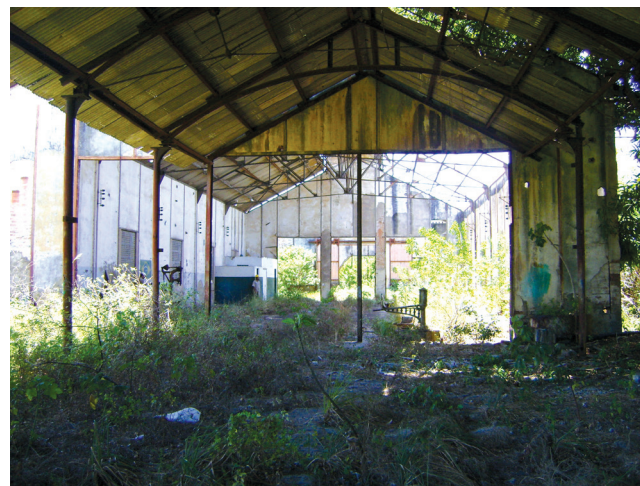
Galpão 04 – vista interior. Foto: Suzete Bomfim, 2012.
