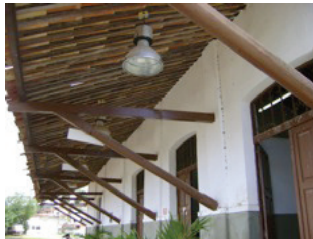
Detalhe da cobertura por beiral de estrutura de madeira e telha cerâmica tipo colonial. Foto: Suzete Bomfim, 2013.
