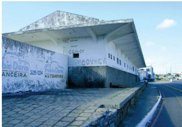
Detalhe da Fachada, com platibanda acompanhando o telhado em duas águas, percebemos a base cantaria de pedras, deixando o edifício acima no nível da rua. Ao fundo, fachada lateral da Estação Ferroviária. Suzete Bomfim, 2012.
