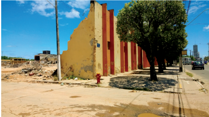
Demolição dos Galpões em outubro de 2013. Fonte: www.infonet.com.br
