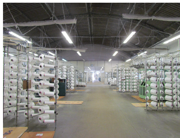
Vista interna de um dos galpões – linha de produção. Estrutura e telhas metálicas em formato semicircular. Foto: Suzete Bomfim, 2013.
