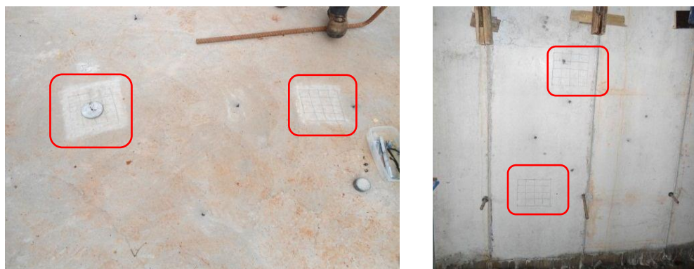
Ensaio de esclerometria em laje maciça e parede de concreto
