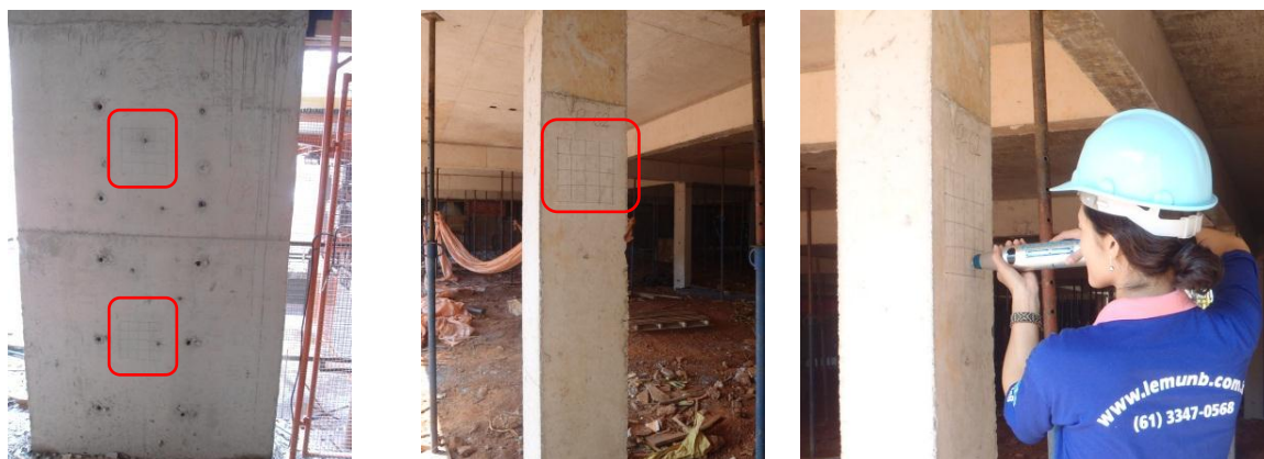
Marcação das malhas e posição do esclerômetro nos pilares
