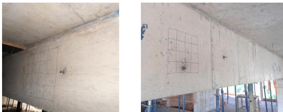
Ensaio de esclerometria em vigas
