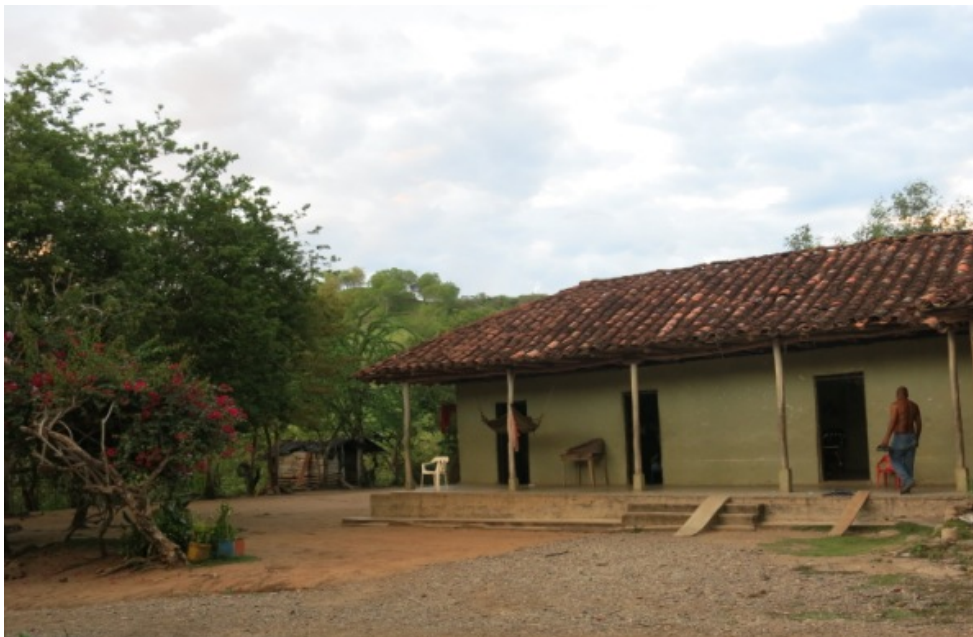
Casa de la vereda El Tuno donde funciona el Hogar Comunitario .
