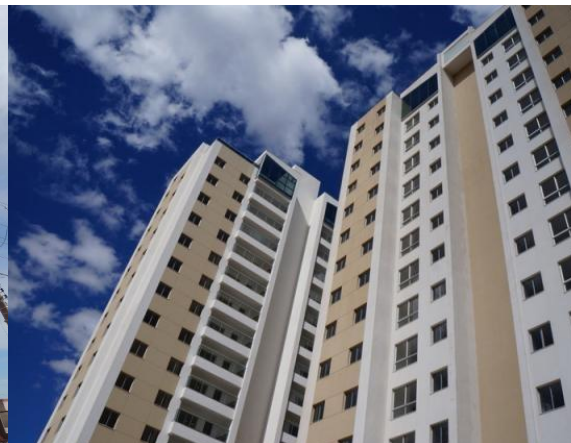
Figura 8: Complexo residencial na Quadra 3 do Setor de Indústrias do Gama
