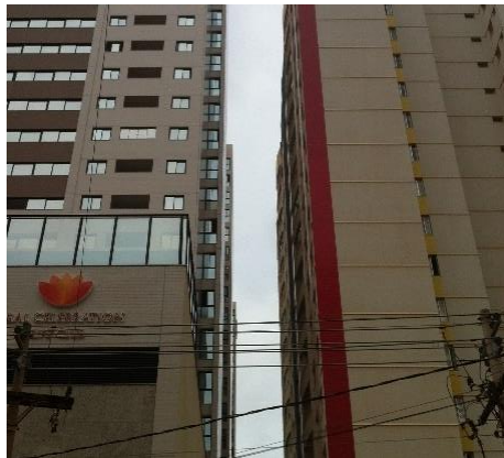
Figura 33: Edifícios em Águas Claras: afastamento de cerca de 5m.
