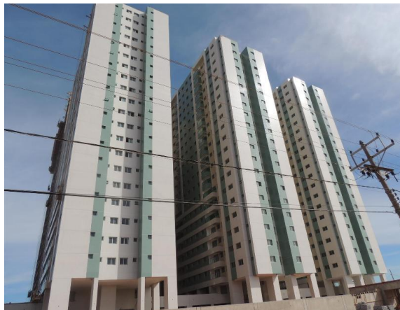
Figura 7: Complexo residencial na Quadra 1 do Setor de Indústrias do Gama
