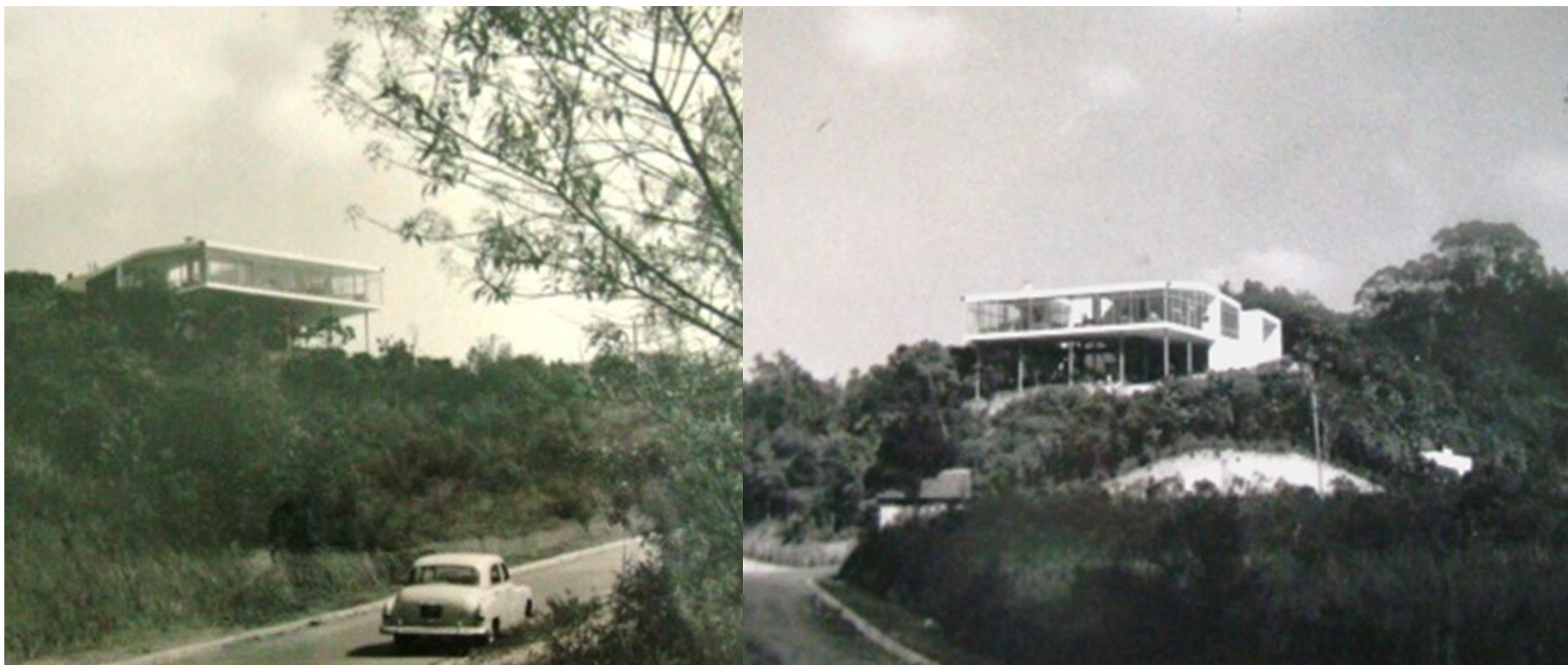
35 A casa do Morumbi em 1951, logo após a conclusão da construção. ILBPMB, 2010.
