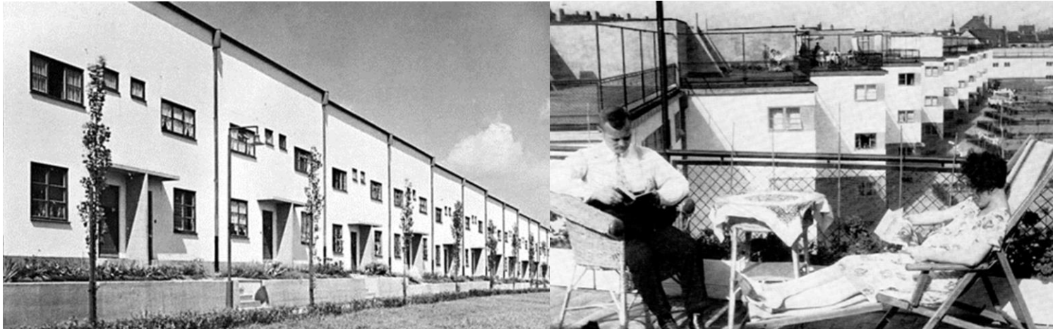
62 Ernst May, Siedlungen Praunheim, Frankfurt, 1926-1929. Na outra imagem Ernst May em uma das coberturas do Siedlungen Bruchfeldstrasse, onde passou a residir.
