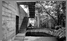
Paulo M. da Rocha. Casa de Fernando Millan. SP, 1970
