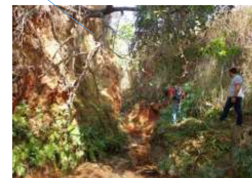
Processo erosivo na cabeceira do córrego Olhos d’Água. Arquivo do autor, 27/09/13.
