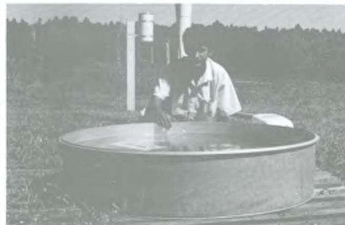
*FOTO 1 - TANQUE CLASSE A PARA CÁLCULO DE IRRIGAÇÃO*
