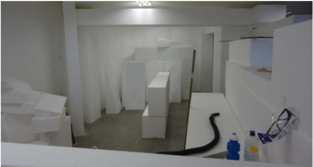
FIGURA 5-16. Estrutura principal, em isopor de alta densidade, da “caverna” do MGeo-UnB. (Foto: Renato Moraes)
