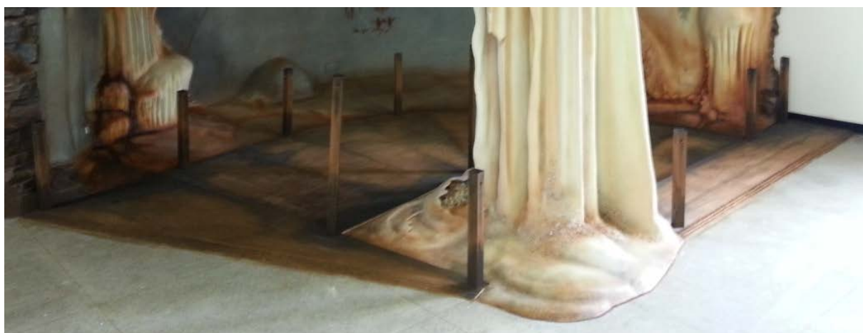
FIGURA 5-24. Detalhe do forma e pintura do piso e suportes de barreira física, em madeira (Foto: Renato Moraes).
