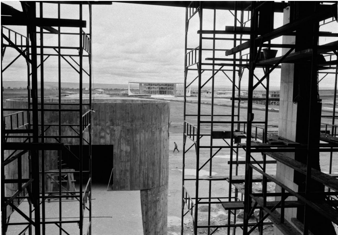
FIGURA 53 - Thomaz Farkas - Canteiro de obras - Brasília - 1958. Fotografia.
