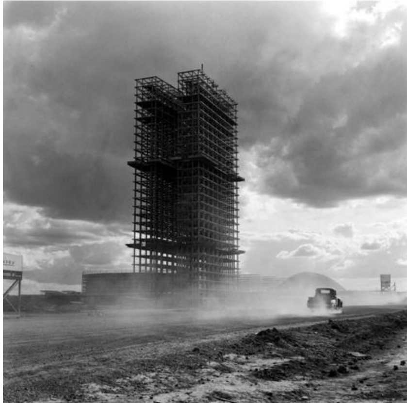
FIGURA 69 - Marcel Gautherot - Congresso Nacional em construção - 1958. Fotografia.
