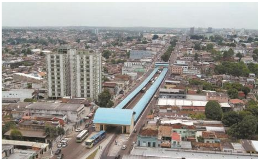
Figura 301. Av. Constantino Nery, em panorama a partir do sul da mancha, na altura do terminal de integração de transporte coletivo (instalado em parte de seu segmento mais largo, aproveitando parte do antigo bulevar). Fonte: < www.skyscrapercity.com > (acesso em 10/03/2013).
