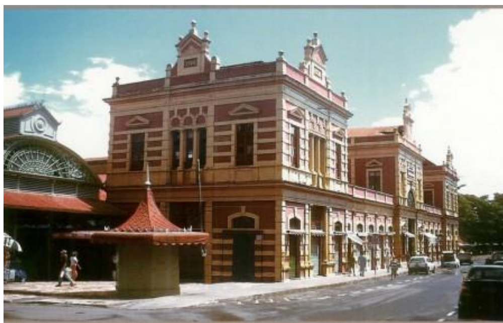
Figura 89. Fachada norte do Mercado Adolpho Lisboa atualmente. Fonte: < www.skyscrapercity.com > (acesso em 03/02/2013).
