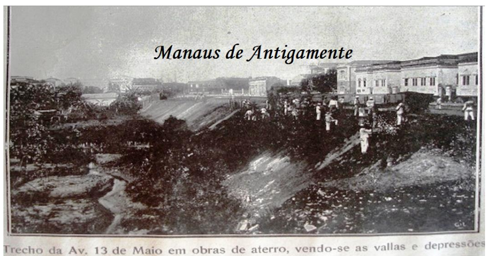
Figura 148. Denominação anterior, Av. 13 de Maio. A recorrência em Manaus, o aterro de igarapés para criação de avenidas. Fonte: < www.skyscrapercity.com > (acesso em 03/02/2013).
