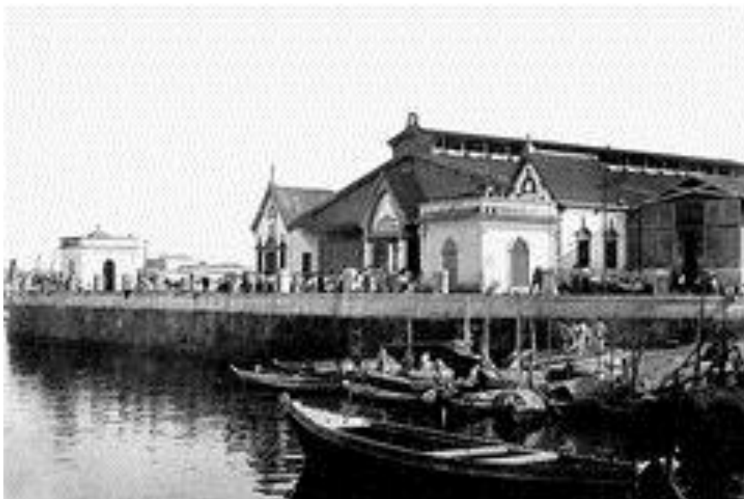
Figura 88. Fachada sul do Mercado Adolpho Lisboa, em fins do século XIX. Fonte: < www.skyscrapercity.com > (acesso em 03/02/2013).
