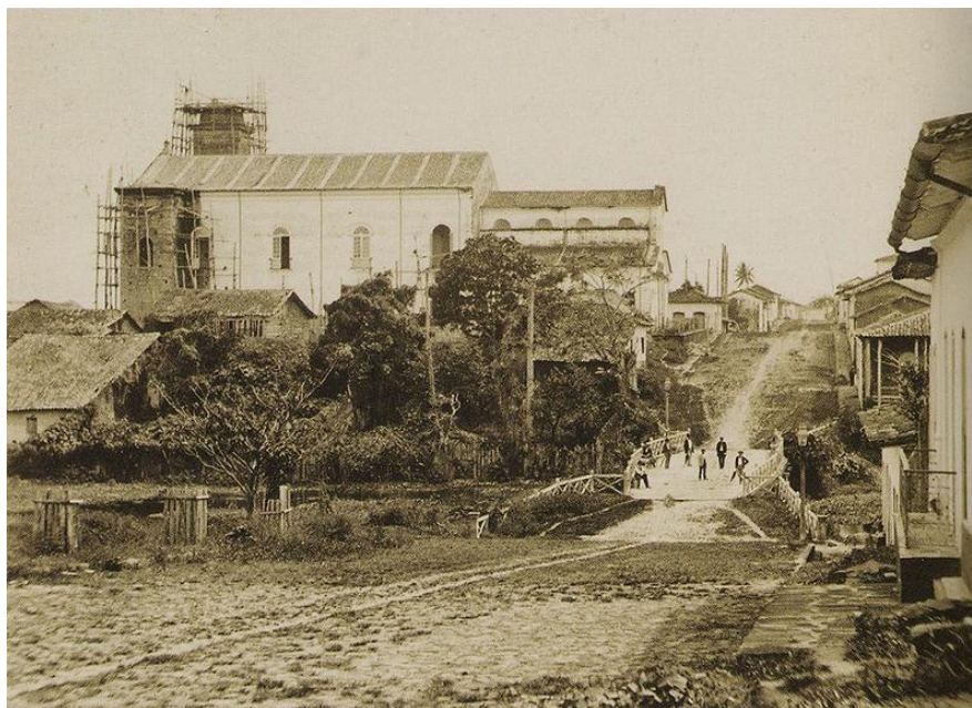
Figura 34. Imagem emblemática contemplando panorama da Av. Sete de Setembro, à época denominada Caminho da Cachoeirinha, a partir de ponto de onde se percebem os Platôs 01e02. Nota-se a ponte de ligação entre os platôs e a Igreja Matriz ainda em construção, o que permite afirmar que a imagem foi registrada anteriormente ao ano de 1878, data de sua conclusão. Fonte: < www.skyscrapercity.com > (acesso em 01/01/2012).
