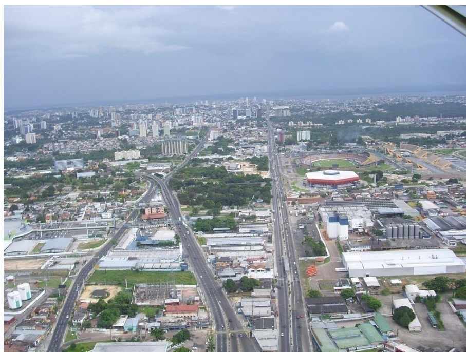
Figura 304. Panorama, a partir do norte; conjunto dos três troncos formadores do eixo viário: Av. Djalma Batista, à esquerda, Av. Constantino Nery, à direita e Av. Recife em diagonal. Destaca-se o caráter retilíneo das duas primeiras, curvilíneo da última e o arranjo (elevado) existente entre a primeira e a terceira. Fonte: < www.skyscrapercity.com > (acesso em 10/03/2013).
