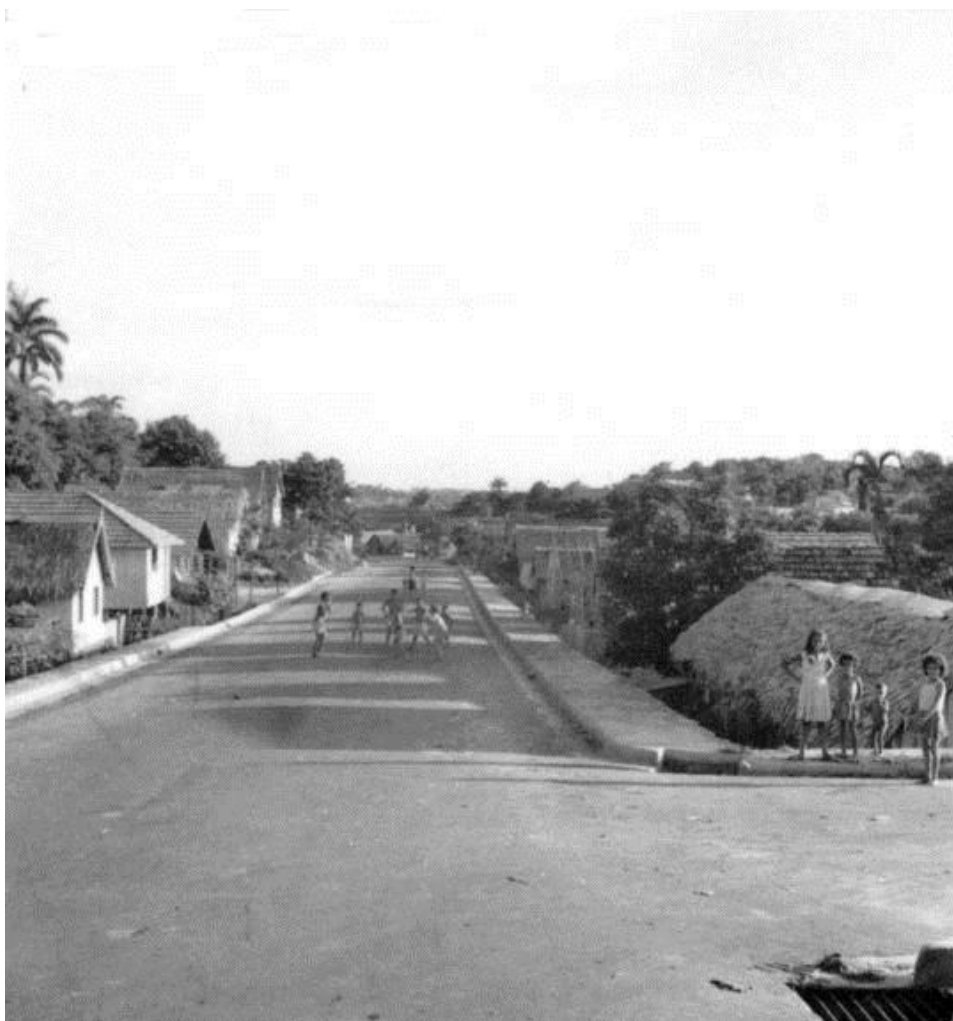
Figura 229. Bairro de São Jorge: destaque para o desnivelamento entre a via e a quadra. Fonte: < www.biblioteca.ibge.gov.br.com > (acesso em 10/03/2013).
