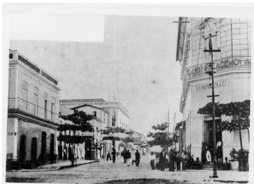
Figura 36. Rua da Instalação, parte do perímetro de quadras apontadas como “gênese” do Quadrilátero Idílico construído no Ciclo da Borracha. Fonte: <www.skyscrapercity.com> (acesso em 01/01/2013).
