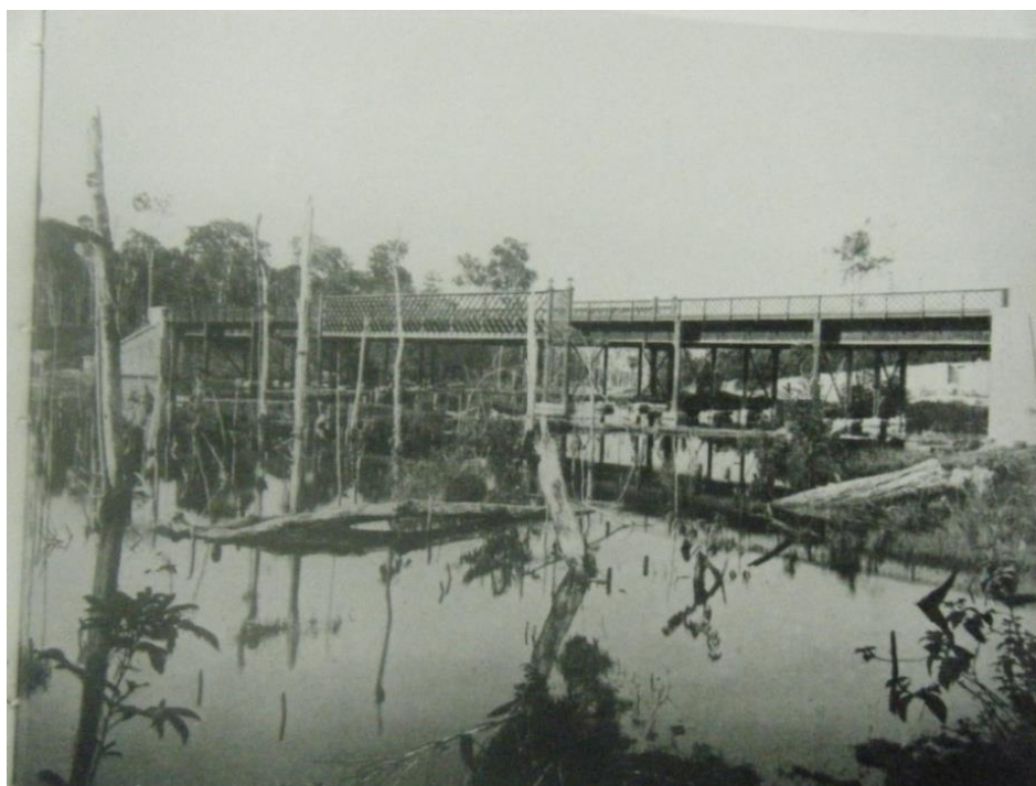
Figura 130. Perspectiva da ponte metálica conhecida como Ponte do Igarapé da Cachoeira Grande. Fonte: < www.skyscrapercity.com > (acesso em 03/02/2013).
