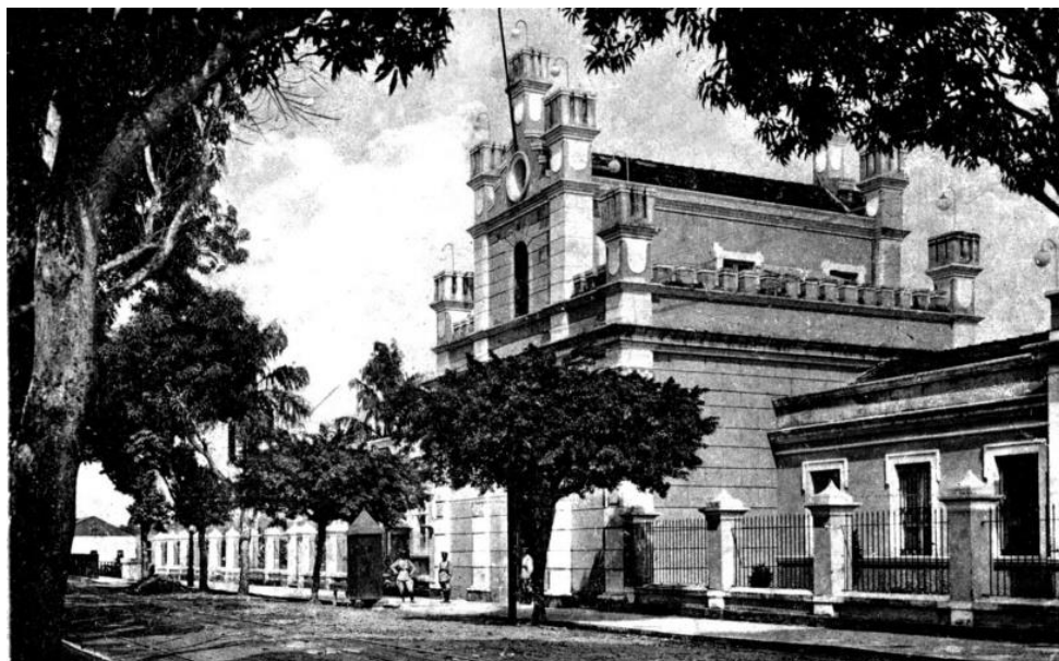
Figura 124. Fachada principal do prédio da Penitenciária de Manaus na Av. Sete de Setembro, inaugurada por Constantino Nery em 1907. Fonte: < www.skyscrapercity.com > (acesso em 03/02/2013).
