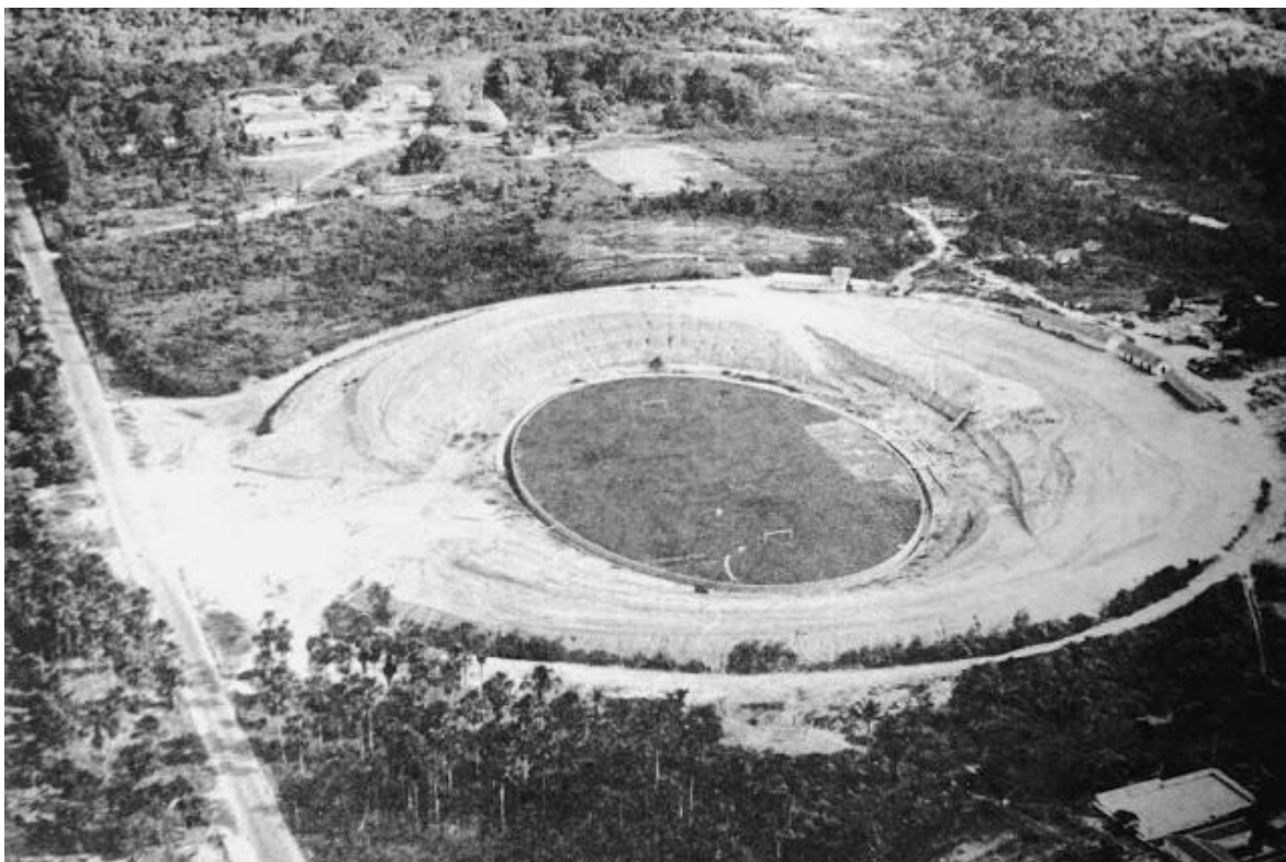
Figura 232. Construção do Estádio Vivaldo Lima; Av. Constantino Nery, à esquerda. Fonte:< www.biblioteca.ibge.gov.br.com > (acesso em 10/03/2013).
