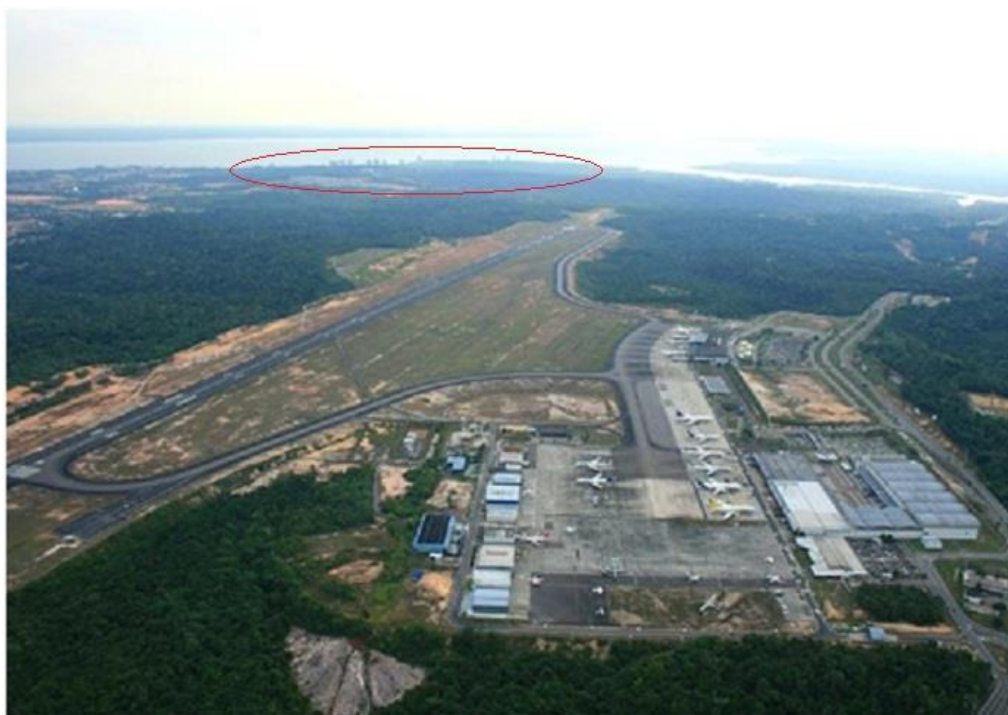
Figura 255. Aeroporto Internacional Eduardo Gomes, construído na década de 1970, à época, um dos mais modernos do país. Fonte: < www.skyscrapercity.com > (acesso em 10/03/2013).
