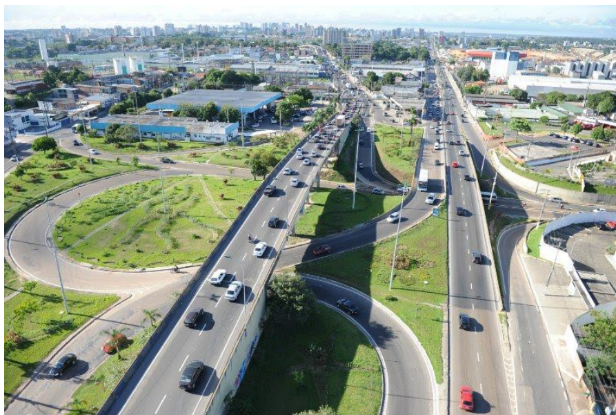
Figura 305. Perspectiva, a partir do norte, do “Complexo Viário de Flores”, solução de entroncamento adotada para o eixo viário norte. Destaca-se a localização do conjunto edificado em azul; à esquerda, o terminal rodoviário interestadual. Fonte: < www.skyscrapercity.com > (acesso em 10/03/2013).
