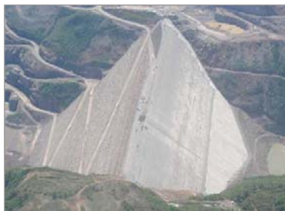
(b) 2ª Etapa da Barragem – El. 660 Lajes até El. 568
