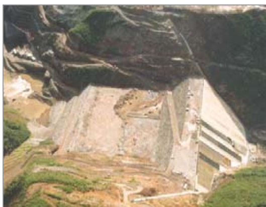
(a) 1ª Etapa da Barragem – El. 570 Lajes até El. 568
