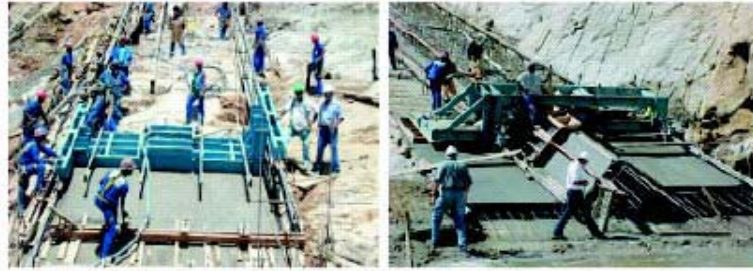
Figura 2.5 – Execução do plinto (Resende et al., 2001).
