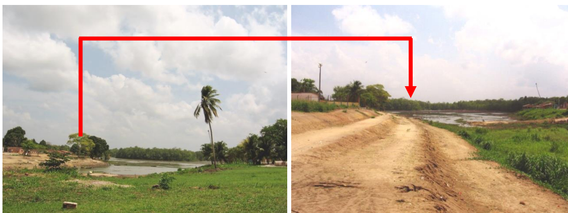
Figura 4.20 - Orla iniciada com a terraplanagem; vista do centro histórico de Curuçá.
