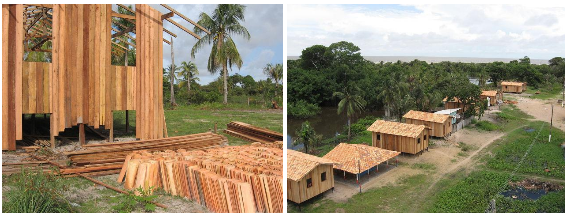
Figura 3.29 - Material de construção cedido pelo programa “Minha Casa Minha Vida” através do INCRA.
