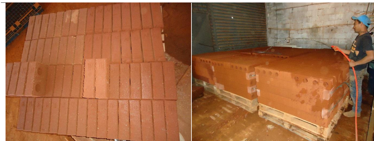
Fig. 3.11 - Blocos moldados (esq.); Cura dos blocos (dir.)
