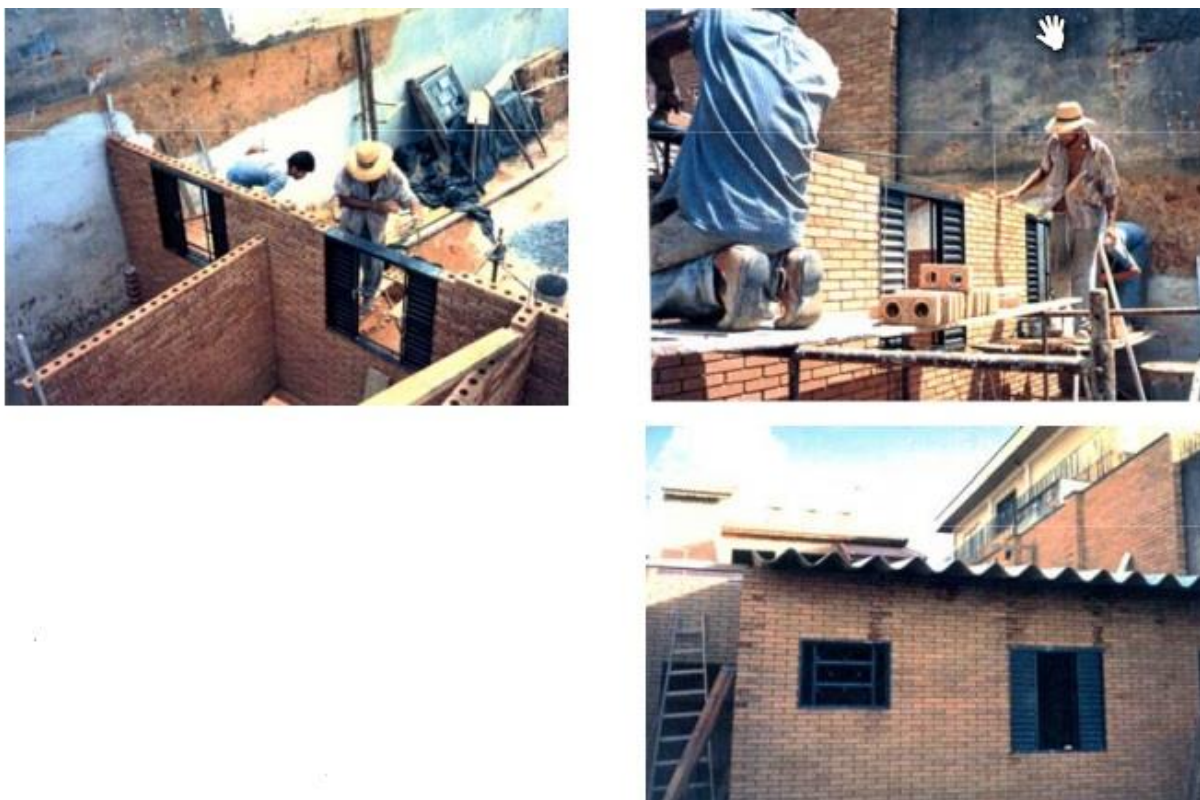
Figura 12 – Exemplos de construção empregando o sistema construtivo modular Fonte: Grupo Aguilar – SAHARA.
