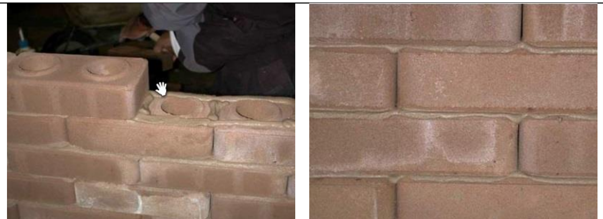
Fig. 2.4 - Justaposição dos blocos (esq.); Detalhe da espessura das juntas (dir.)
