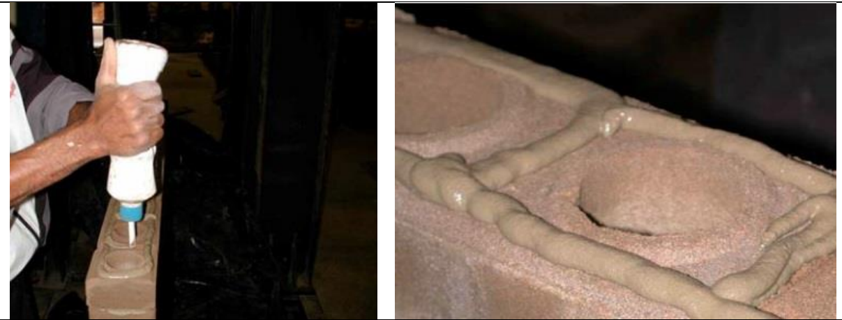
Fig. 2.3 - Aplicação de argamassa com utilização de bisnaga (esq.); Detalhe filete de argamassa na superfície do bloco (dir.)
