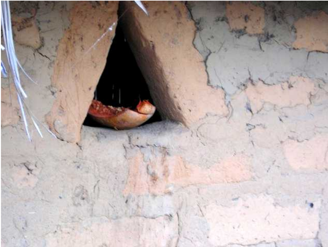
Foto 6 – Detalhe ventilação do fogão a lenha da cozinha – Crédito: Jônatas Barreto
