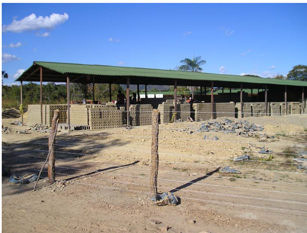
Foto 24 – Canteiro de obras de solo-cimento do Ação Kalunga em vão do moleque Crédito: Jônatas Barreto
