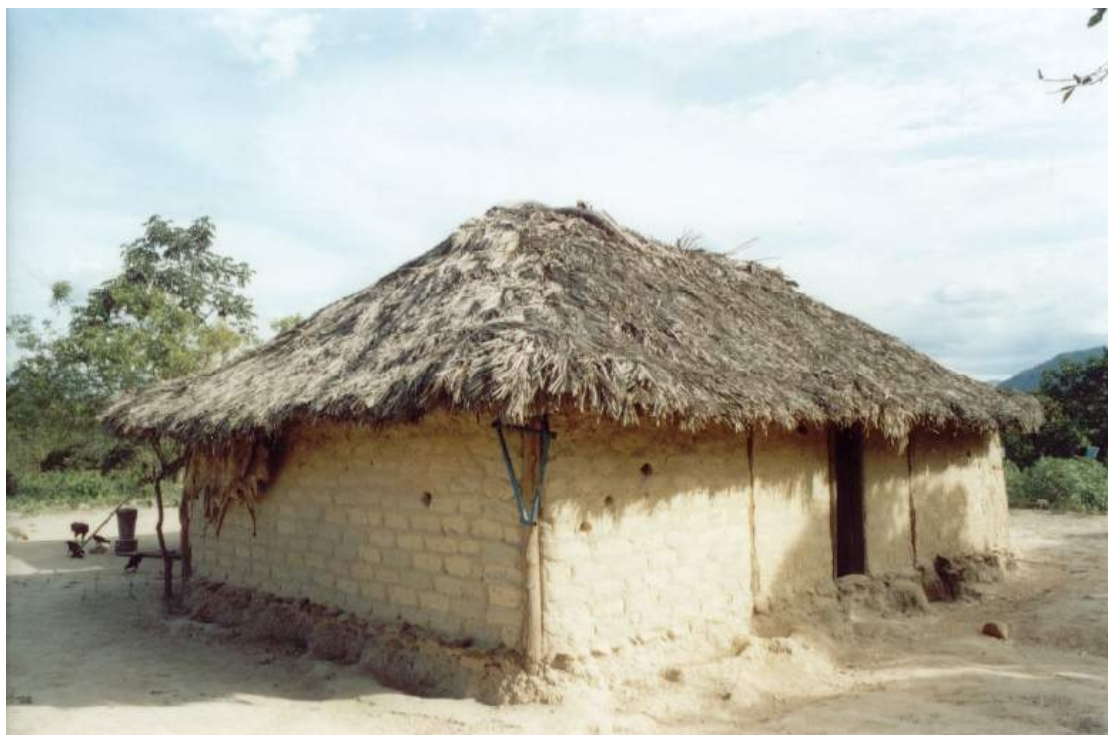
Foto 5 – Casa de adobe com estrutura em madeira
