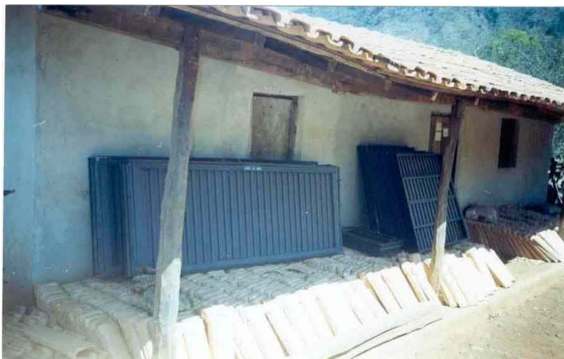
Foto 8 – Casa em reforma para substituir esquadrias e telhado. Crédito:Jônatas Barreto
