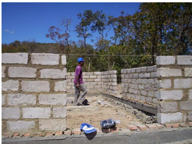
Foto 19 – Baldrame e paredes da casa de adobe do Ação Kalunga em limoeiro Crédito: Jônatas Barreto
