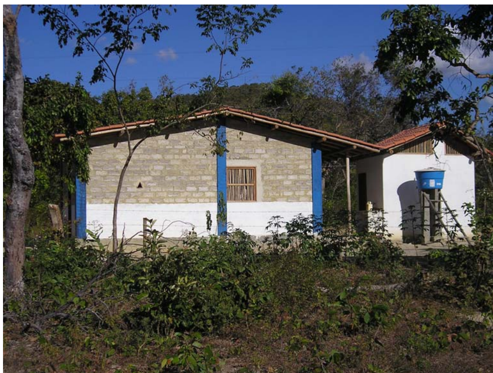
Foto 22 – Vista lateral de casa de adobe do Ação Kalunga em Limoeiro Crédito: Jônatas Barreto
