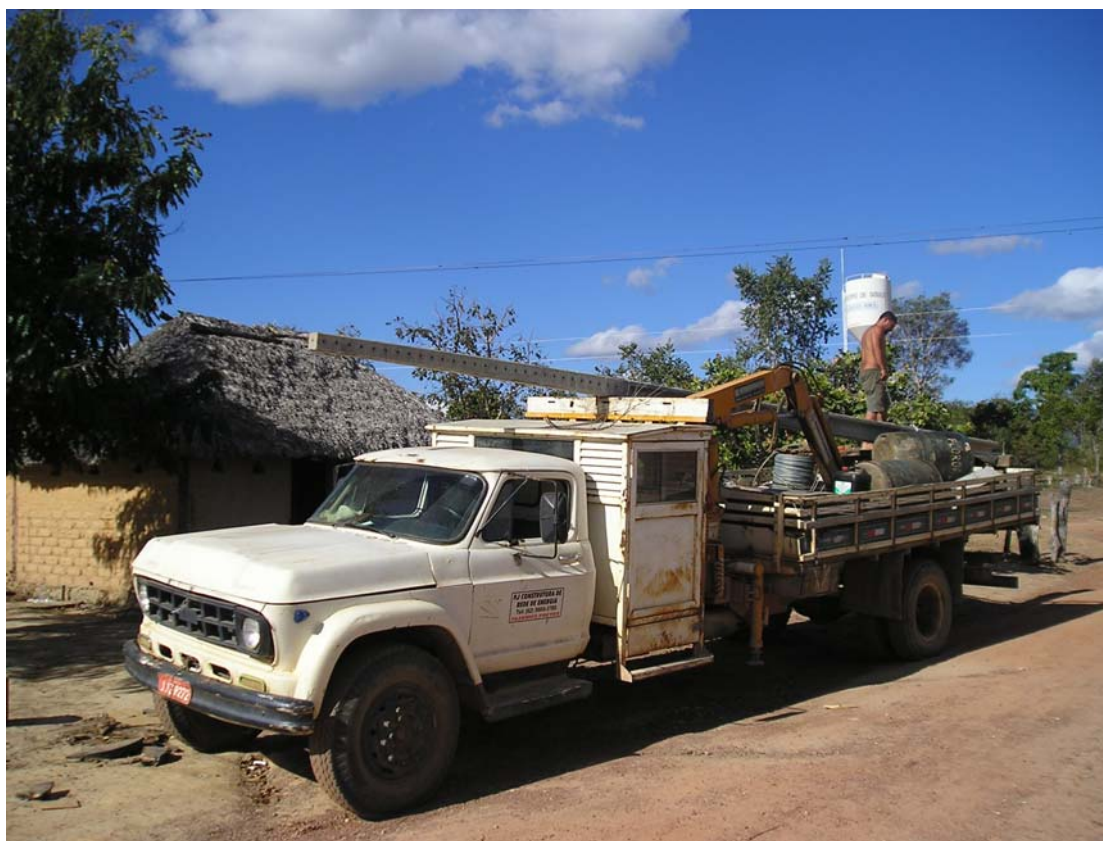
Foto 27 – Caminhão usado na instalação dos postes Crédito: Jônatas Barreto
