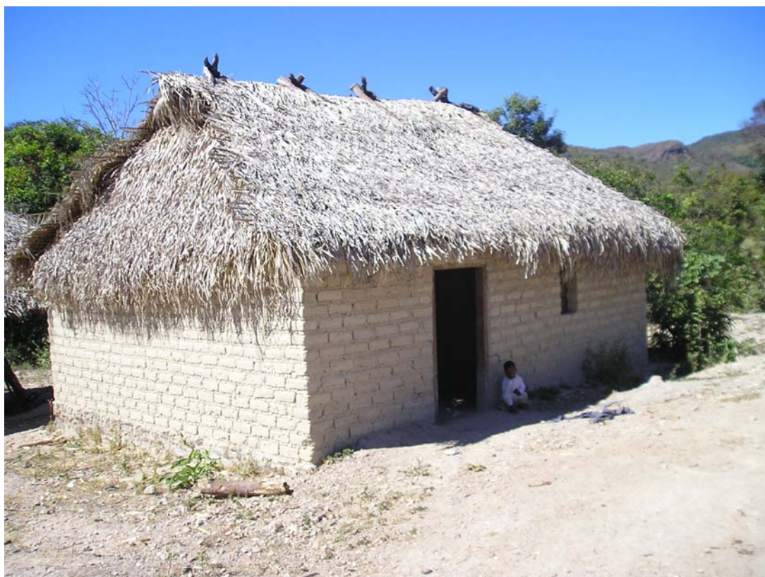
Foto 4 – Casa de adobe estrutural. Crédito Jônatas Barreto
