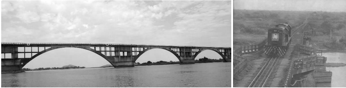
Figura 256: Vista da Ponte Eurico Gaspar Dutra (1947). Disponível em: < http://timblindim.wordpress.com/2010/11/18/2-pontes-sobre-o-rio-paraguai/ >. Acesso em 28/04/2013.
