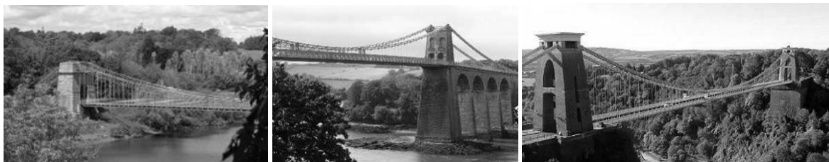
Figura 10: Union Bridge (1813-1820), sobre o Rio Tweed, entre Escócia e Inglaterra, de Samuel Brown. Disponível em: < http://www.bridgemeister.com/pic.php?pid=2312 >. Acesso em: 20/01/2013.
