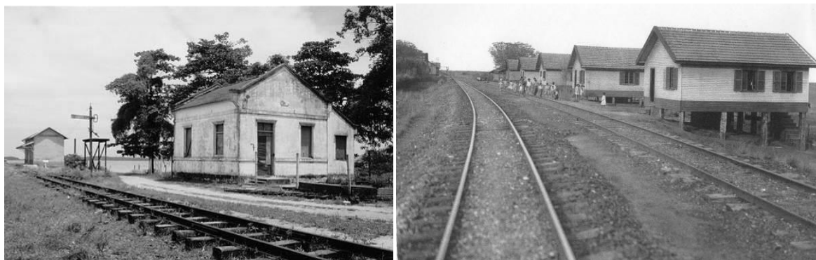
Figura 493: Casa de Agente próxima à Estação Guia de Pacobaíba, no fundo da Baía da Guanabara, Rio de Janeiro. Disponível em: http://flickr.com/photos/65978346@N00/379599118/ . Acesso em 30/11/2008.
