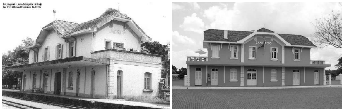
Figura 180: Estação nova de Jaguari (1935). Disponível em: < http://www.estacoesferroviarias.com.br/rs_sborja/jaguari.htm >. Acesso em 04/04/2013.
