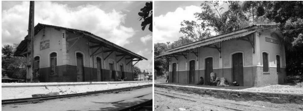
Figura 298: Estação de São José da Laje (1894), já em Alagoas. Fonte: IPHAN. 17ª Superintendência Regional do IPHAN em Alagoas. Inventário do Patrimônio Ferroviário da RFFSA . 2008.
