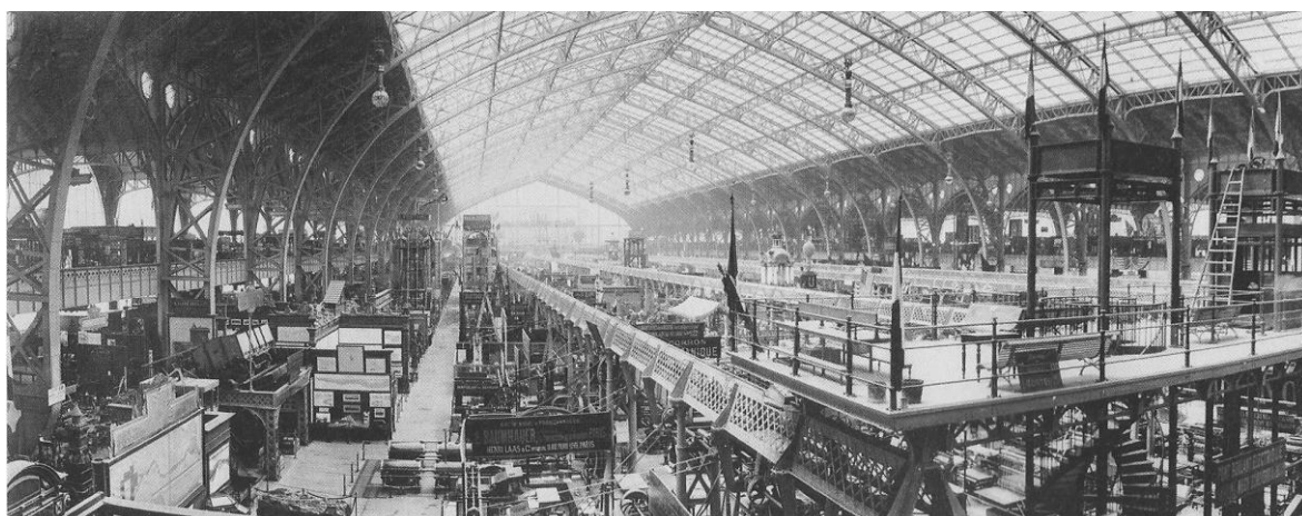
Figura 36: Vista interna da Galerie des Machines durante a exposição de 1889. Fonte: ÉDITIONS DU PATRIMOINE. op. cit. , p. 36
