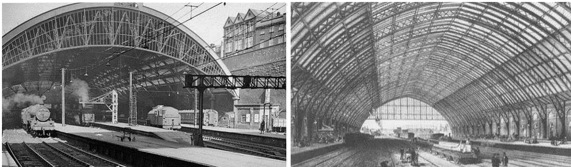
Figura 22: Cobertura da Lime Street Station (1849-1850), em Liverpool, de Turner, Locke e Fairbairn. Fonte: < http://commons.wikimedia.org/wiki/File:Liverpool_3_Lime_Street_Station_2025960.jpg >. Acesso em 20/01/2013.
