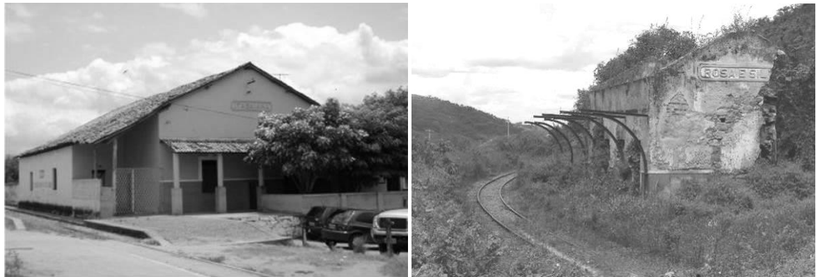
Figura 342: Estação de Itabaiana (1901), na Paraíba. Fonte: IPHAN. Ibid.
