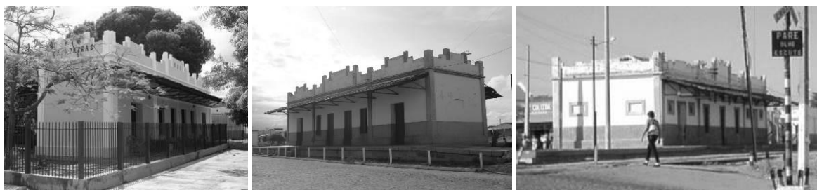
Figura 364: Estação de Cajazeiras (1926), construída pela Rede de Viação Cearense. IPHAN. Superintendência Regional do IPHAN na Paraíba. Inventário de Conhecimento do Patrimônio Ferroviário – Volume I – Paraíba. 2008.
