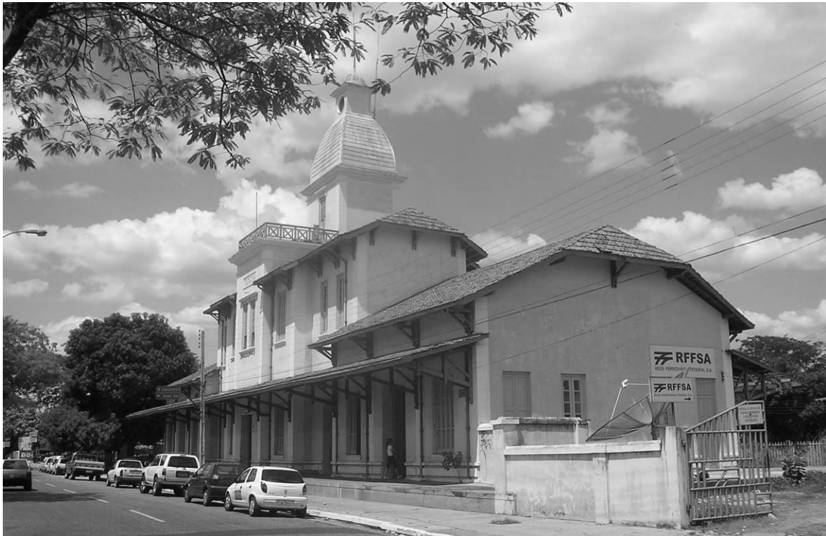
Figura 463: Estação de Teresina (1926). Acervo Superintendência Estadual do IPHAN no Piauí, 2008.
