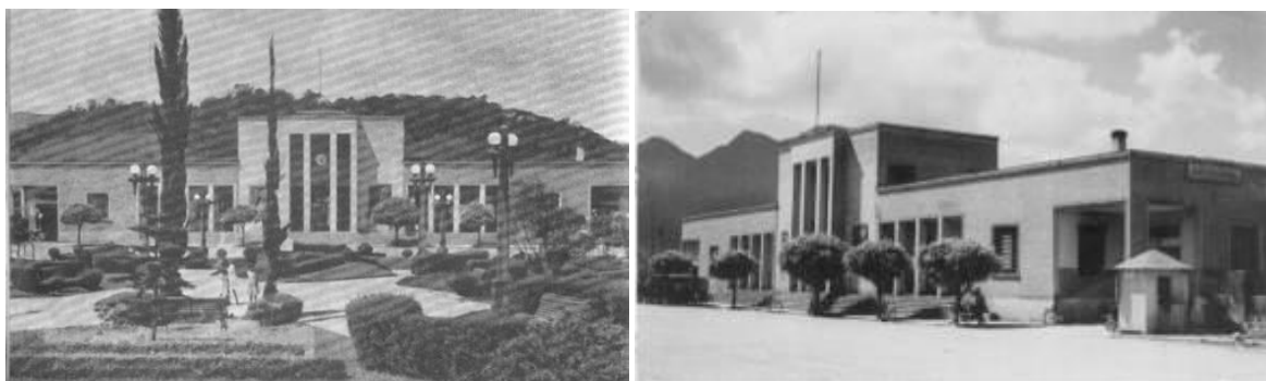
Figura 429: Estação de Jaraguá do Sul (1943). Disponível em: < http://www.estacoesferroviarias.com.br/sc-saofranc/jaragua.htm >. Acesso em: 01/04/2013.
