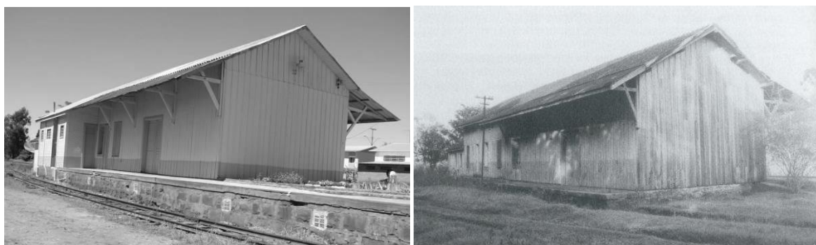
Figura 199: Estação de Erebangó (1910). Disponível em: < http://www.estacoesferroviarias.com.br/rs_marcelino-stamaria/erebango.htm >. Acesso em 03/04/2013.
