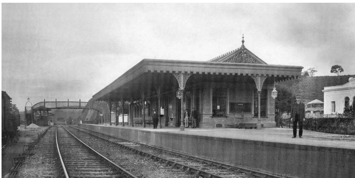
Figura 122: Estação de Caieiras, onde se observa a cobertura metálica de proteção da plataforma e, ao fundo, a passarela metálica. Fonte: MAZZOCO & SANTOS, op. cit.
