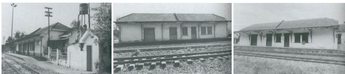
Figura 204: Estação de Caí (depois General Luz, 1938), na variante Barreto – Diretor Pestana.. Ibid.
