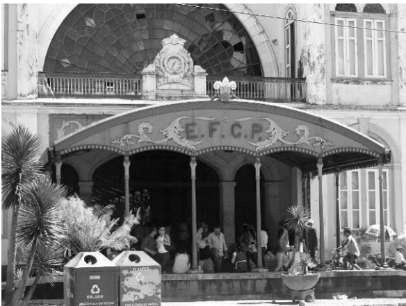
Figura 374: Cobertura metálica sobre a entrada principal. Fonte: IPHAN. Superintendência Estadual do IPHAN em Pernambuco. op. cit.
