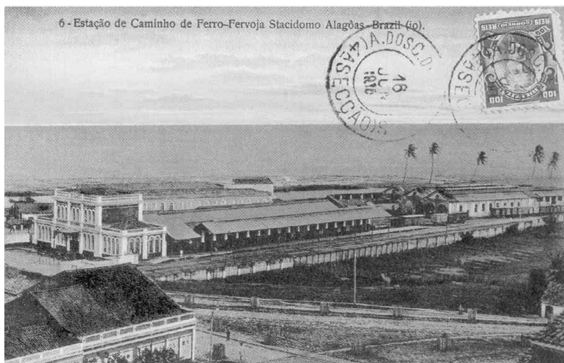
Figura 300: Estação de Maceió (1884). Fonte: IPHAN. 17ª Superintendência Regional do IPHAN em Alagoas. op. cit.
