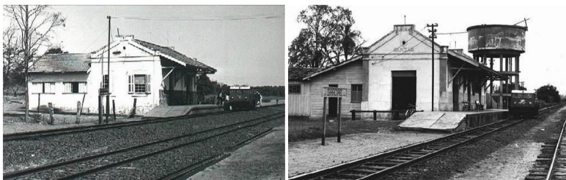
Figura 245: Estação Luiz Gama (1914). Disponível em: < http://www.estacoesferroviarias.com.br/ms_nob/luiz.htm >. Acesso em 26/04/2013.
