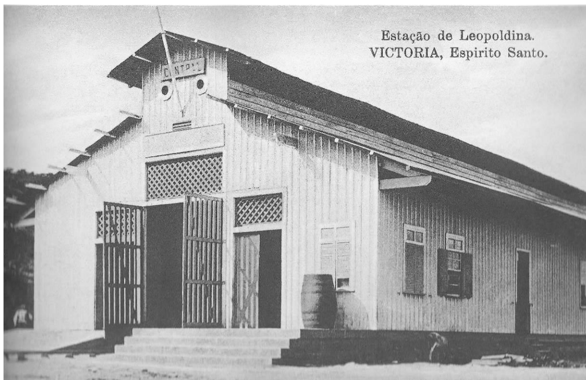
Figura 510: Estação de Vitória (1895), da Estrada de Ferro Sul do Espírito Santo. Fonte: GERODETTI & CORNEJO, op. cit.
