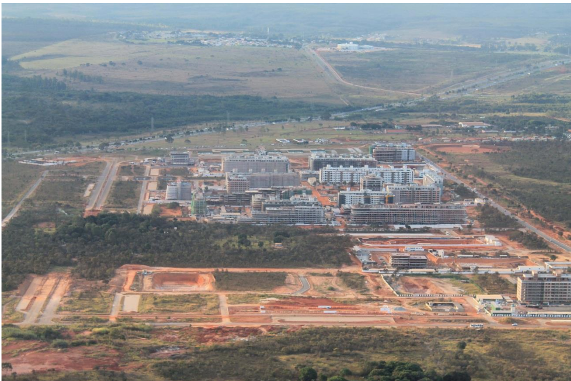
Figura 9 – Vista aérea (sentido sul-norte) do Setor de Habitações Coletivas Noroeste – SHCNW em julho de 2012, DF.
