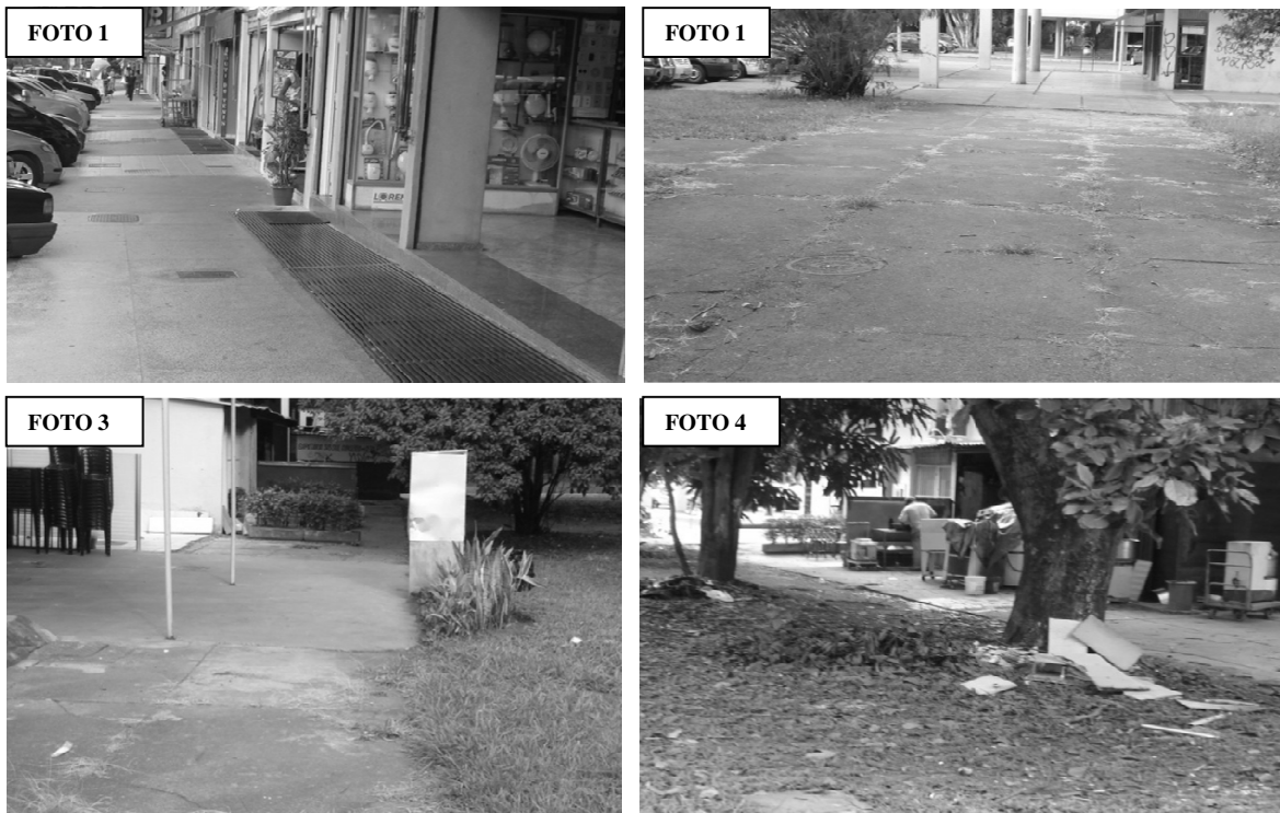
Figura 6.23- Foto 1, vista da calçada frontal do bloco (D); Fotos 2, 3 e 4, acessos
