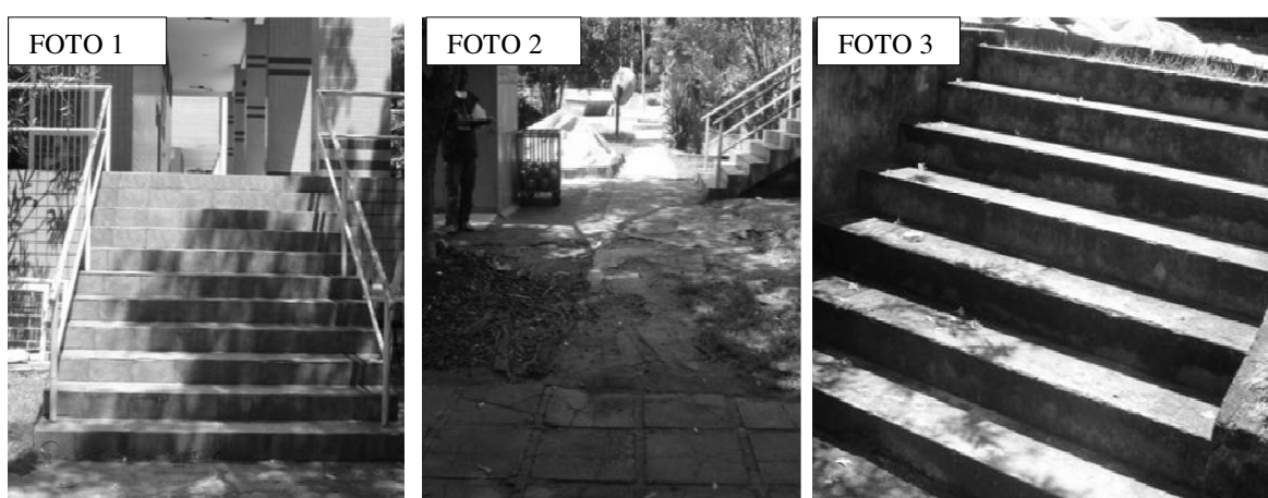
Figura 5.13- Foto 1, Escada 407NCE2; Foto 2, Acesso 1; Escada 407NCE3
