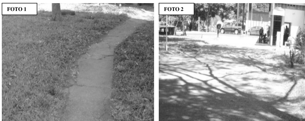
Figura 5.56- Foto 1, acesso (H); Foto 2, acesso (I)
