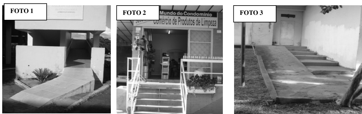
Figura 4.34- Foto 1, Rampa 206NCR1; Foto 2, Escada 206NCE1; Foto 3, Escada 206NCE2 e Rampa 206NCR2
