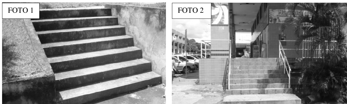
Figura 5.14- Foto 1, Escada 407NCE4; Foto 2, Escada 407NCE5 na parte lateral Leste
