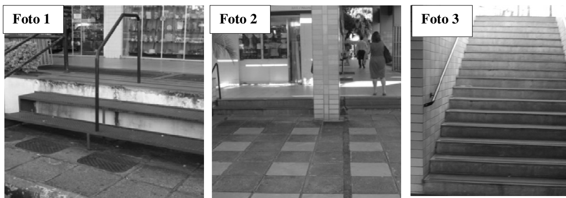
Figura 4.71- Foto 1, Escada 311NCE1; Foto 2, Escada 311NCE2 e E3; Foto 3: Escada 311NCE4
