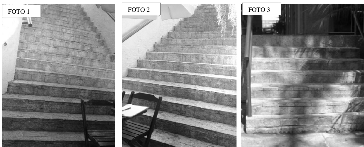
Figura 4.80- Foto 1, Escada 311NEE3; Foto 2: Escada 311NEE4; Foto 3: Escada 311NEE5
