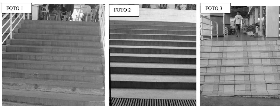
Figura 4.70: Foto 1, Escada 311NBE4; Foto 2, Escada 311NBE5; Foto 3, Escada 311NBE6
