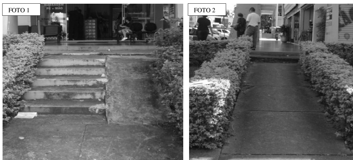
Figura 4.53- Foto 1, Escada 106NCE4 e Rampa 106NCR3; Foto 2, Escada 106NCE5
