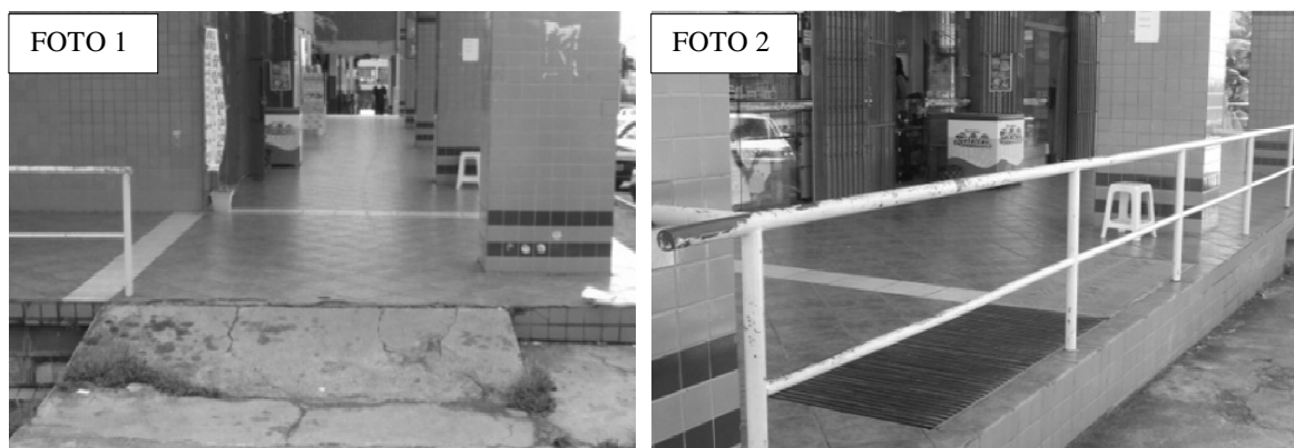
Figura 5.11- Acessos às rampas ao Bloco C pela frente principal parte Sul
