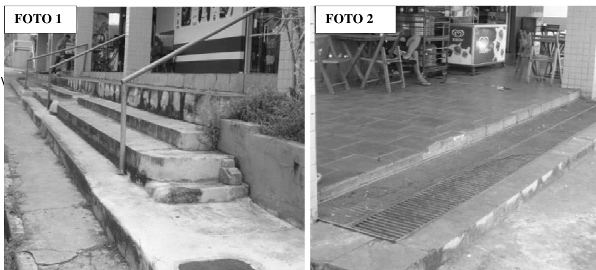
Figura 5.15- Foto 1, Escada 407NDE1; Foto 2, Escada 407NDE2 na parte Sul
