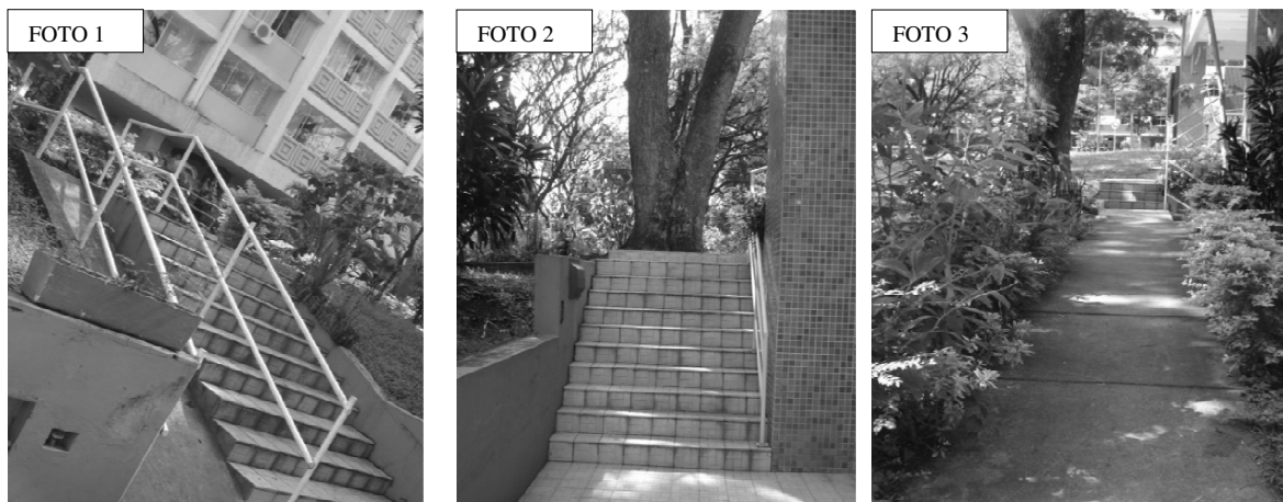
Figura 4.44- Foto 1, Escada 106NAE5 e Rampa; Foto 2, Escada 106NAE6; Foto 3: Acesso R
