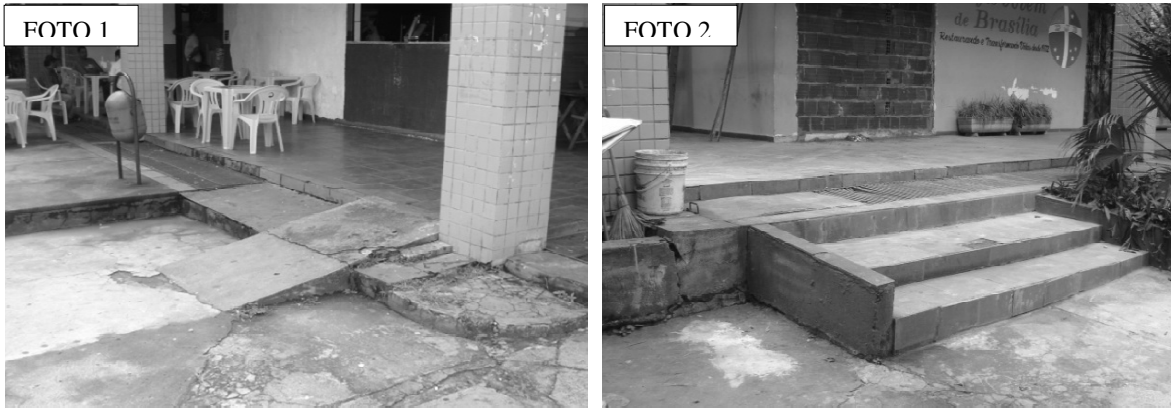
Figura 5.16- Foto 1, Rampa 407NDR1; Foto 2: Escada 407NDE3
