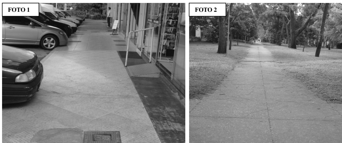
Figura 6.19- Foto 1, Vista da calçada frontal do Bloco A; Foto 2, calçada para pedestres
