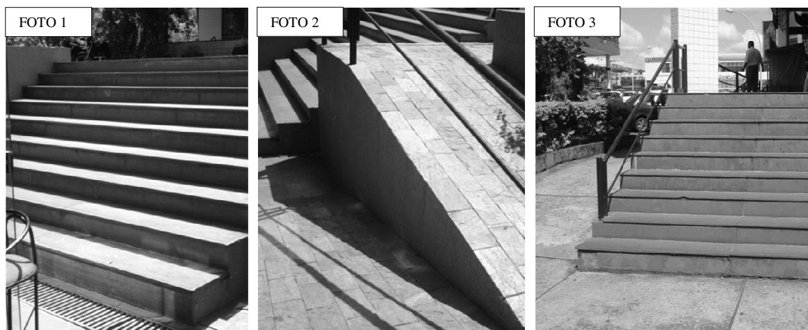
Figura 4.77- Foto 1, Escada 311NDE5; Foto 2: Rampa 311NDR2; Foto 3: Escada 311NDE6
