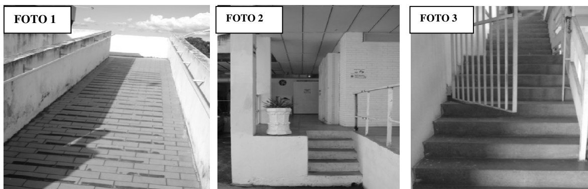
Figura 4.31- Foto 1, Rampa 206NBR1; Foto 2, Escada 206NBE1; Foto 3, Escada 206NBE2
