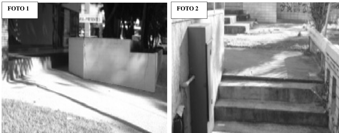
Figura 4.69- Foto 1: Vista panorâmica; Foto 2: Escada 311NBE3
