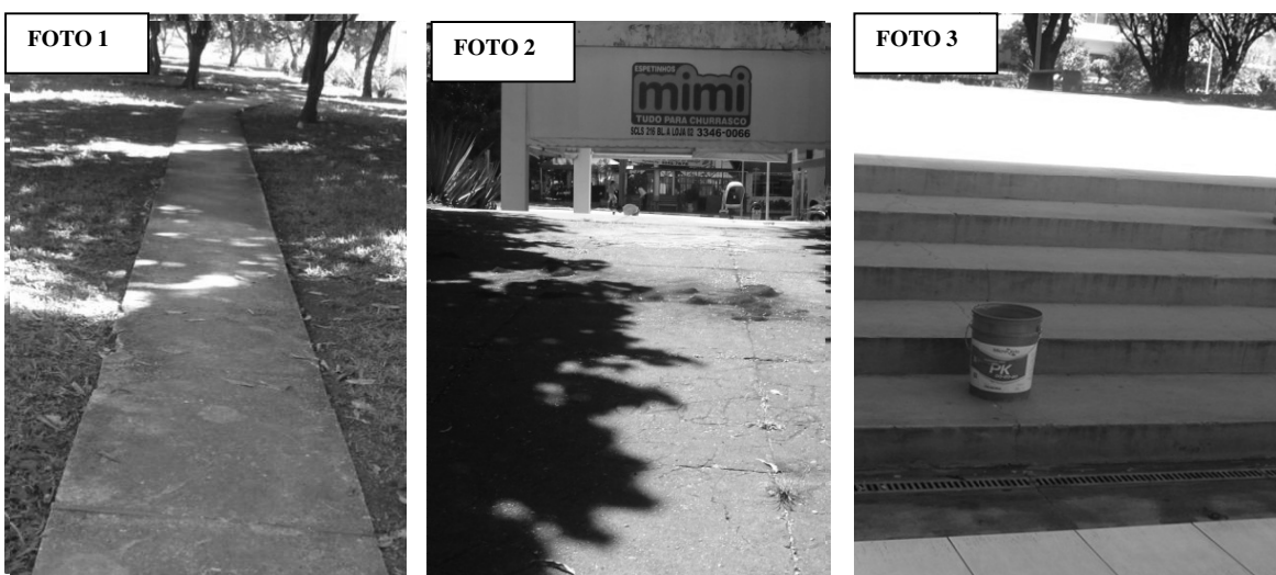
Figura 6.7- Foto 1, acesso (H); Foto 2, acesso ( G), Foto 3, escada 216SAE1
