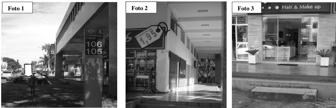
Figura 4.41- Foto 1: lixeira L1 e vista acesso principal sul ao Bloco A; Foto 2: Escada 106N AE1 Foto 3: Escada 106NAE2
