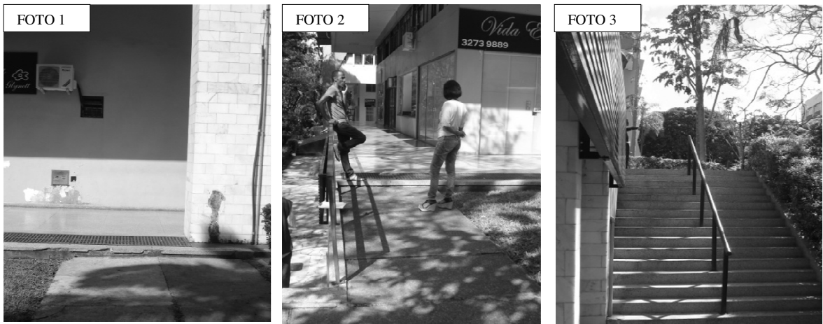
Figura 4.47- Foto 1, Acesso J ; Foto 2, Acesso I; Foto 3, Escada 106NBE3
