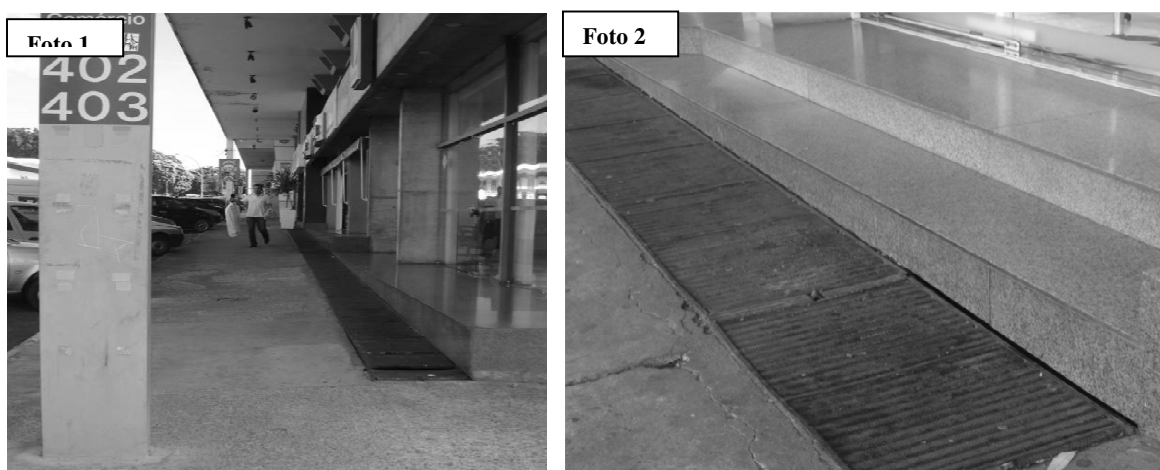
Figura 6.33- Foto 1, vista da calçada frontal; Fotos 2, escada 402SDE1
