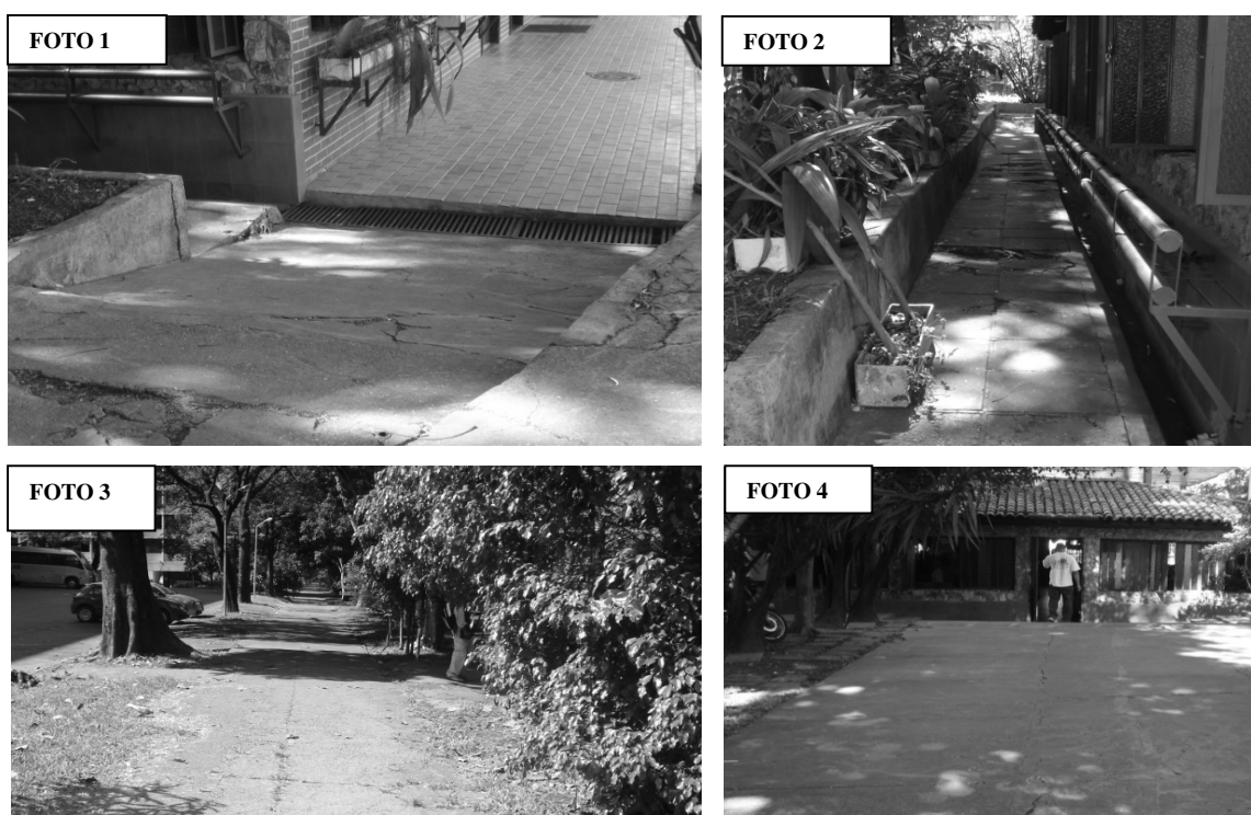
Figura 5.50- Foto 1, rampa 209SAR3; Foto 2, acesso (K); Foto 3, acesso (B); Foto 4, acesso (C)
