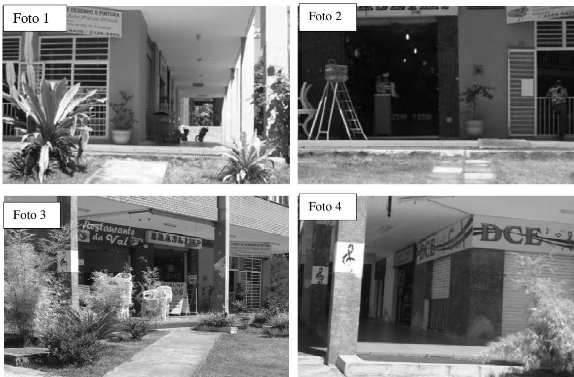
Figura 5.10- Foto 1 Rampa 407NBR1; Foto 2: Rampa 407NBR2; Foto 3: Rampa 407NBR3; Foto 4, escada 407NBE6
