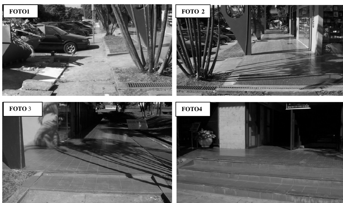
Figura 4.16- Calçada frontal do Bloco B
