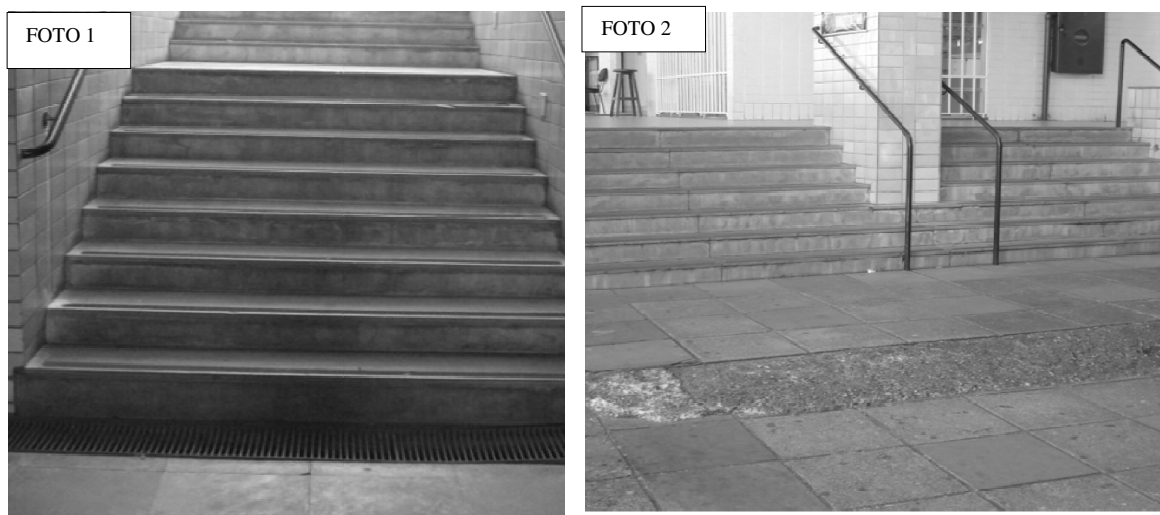
Figura 4.74- Foto 1: Escada 311NCE12 com dois; Foto 2: Escada 311NCE13
