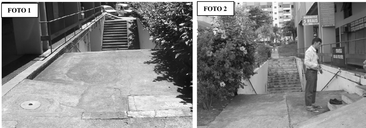
Figura 4.9- Vista da calçada lateral Leste do Bloco A e os dois acessos para o subsolo
