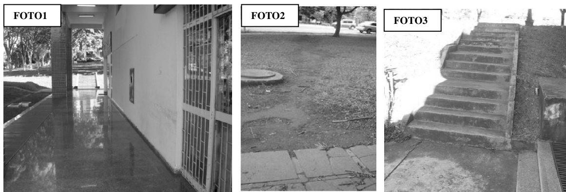
Figura 4.23: Foto 1, 2 e 3, acessos na lateral do bloco D
