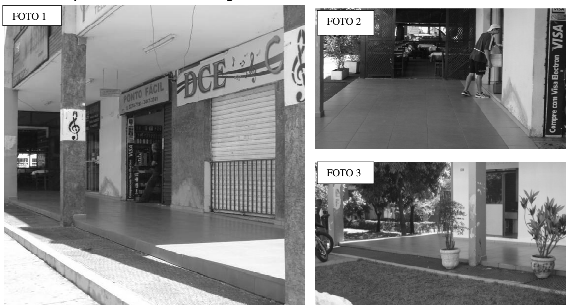
Figura 5.8- Foto 1, Escada 407NBE1; Foto 2, Escada 407NBE2; Foto 3, parte Oeste ao bloco A
