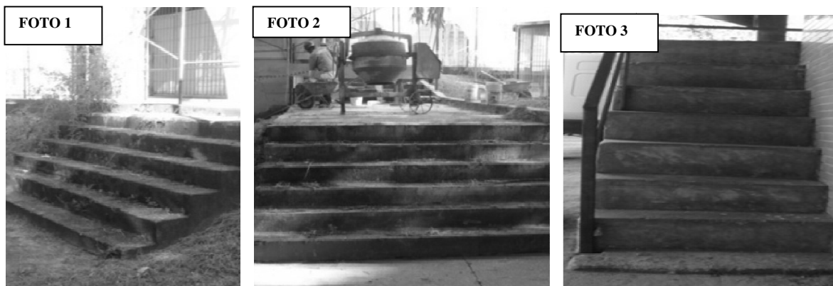
Figura 4.35- Foto 3- Escadas na parte Norte
