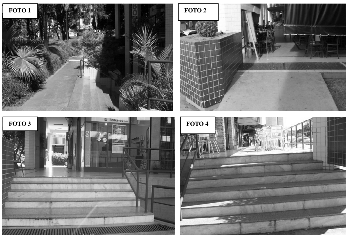
Figura 4.12- Foto 1, vista da calçada lateral Oeste do Bloco B; Fotos 2 e 3, obstáculos no acesso à calçada do Bloco e; Foto 4, caminho de acesso
