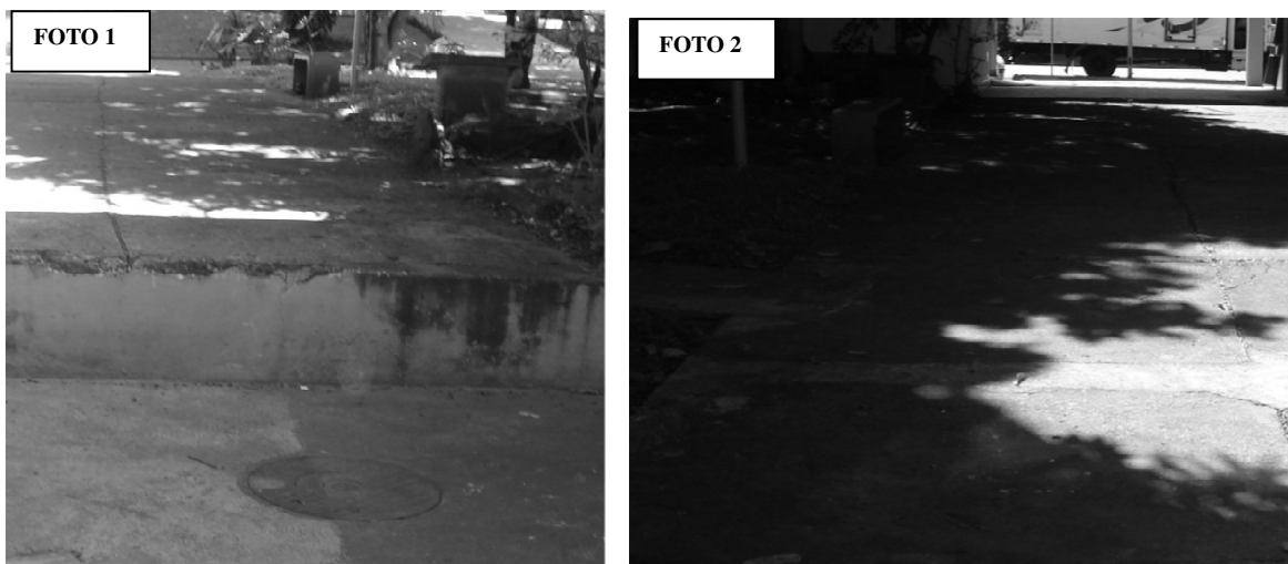
Figura 6.6- Foto 1, acesso (I); Foto 2, acesso ( G)
