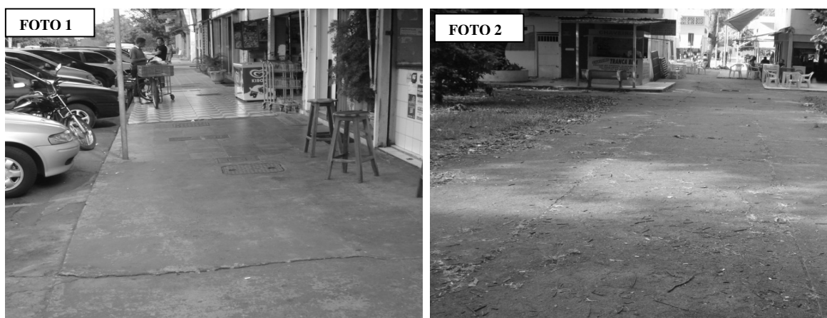
Figura 6.20- Foto 1, Vista da calçada frontal do Bloco A; Foto 2, acesso (H)
