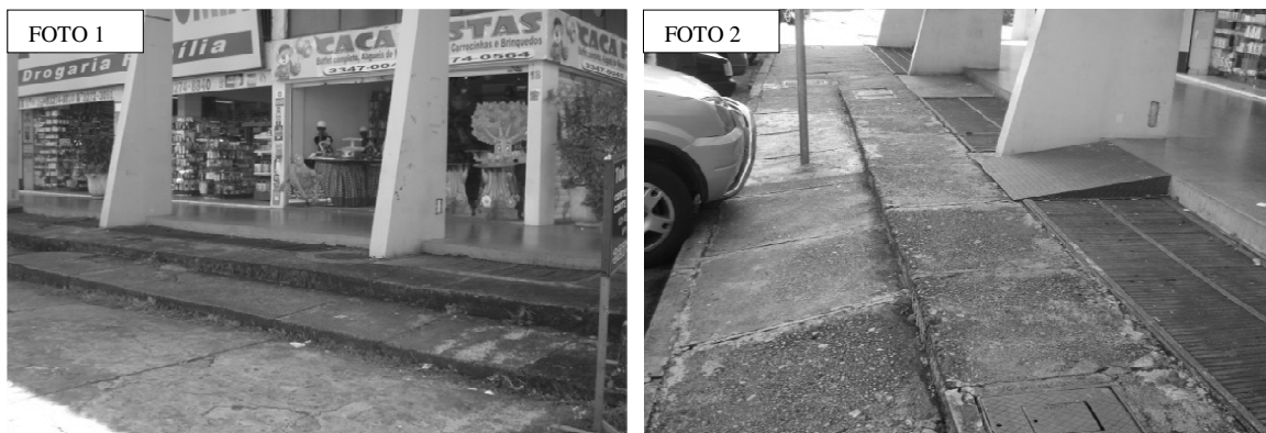
Figura 4.50- Foto 1, Escada 106NCE1 ao Bloco C; Foto 2, Rampa 106NCR1
