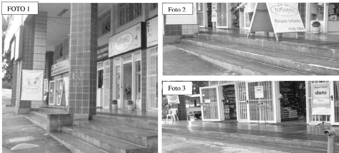
Figura 5.4- Foto 1, Escada 407NAE1; Foto 2: Escada 407NAE2; Foto 3, Escada 407NAE3
