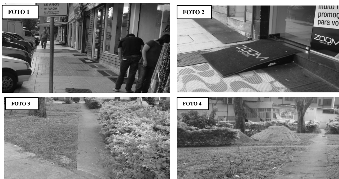
Figura 5.33- Foto 1, Vista panorâmica; Foto 2, rampa 113SCR1; Foto 3, acesso (H) e (I); Foto 4, acesso (J)
