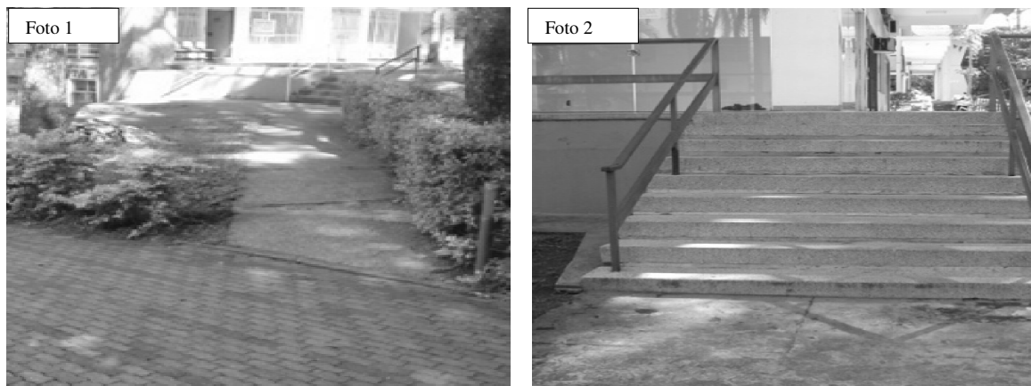
Figura 4.49- Foto 1:acesso L; Foto 2: escada 106NBE6
