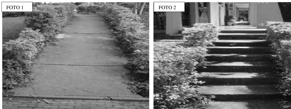
Figura 4.52- Foto 1, Acesso H parte Norte do Bloco C; Foto 2, Escada 106NCE3
