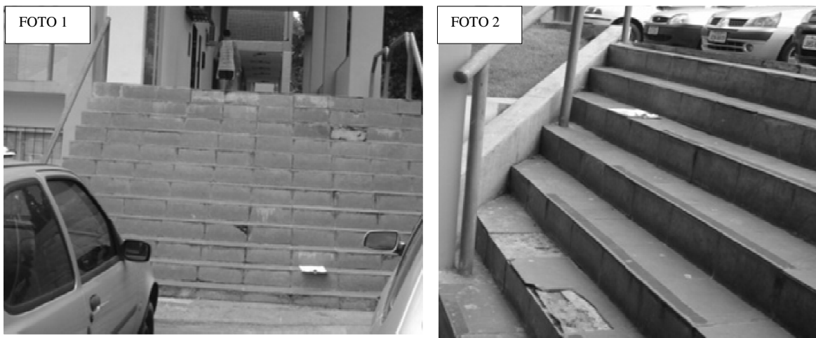
Figura 5.21- Foto 1, Escada 407NEE2 ; Foto 2, Escada 407NEE3
