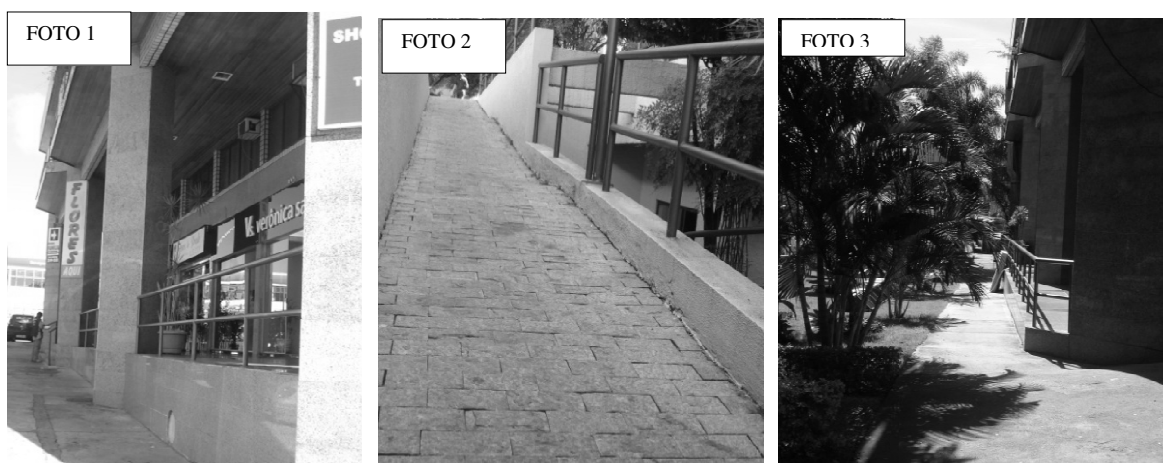
Figura 4.78- Foto 1, Vista frontal Bloco E; Foto 2, Rampa 311NER1; Foto 3, Acesso B
