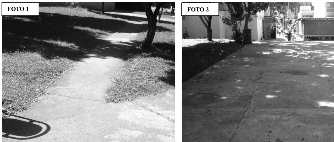
Figura 6.13: Foto 1, acesso ( B ); Foto 2, acesso (D)
