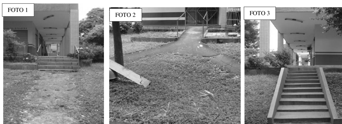
Figura 5.18- Foto 1: Escada 407NDE7; Foto 2: Rampa 407NDR2; Foto 3: Escada 407NDE8
