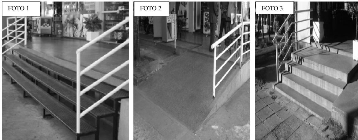
Figura 4.68- Foto 1, Escada 311NBE1; Foto 2, Rampa 311NBR1; Foto 3, Escada 311NBE2
