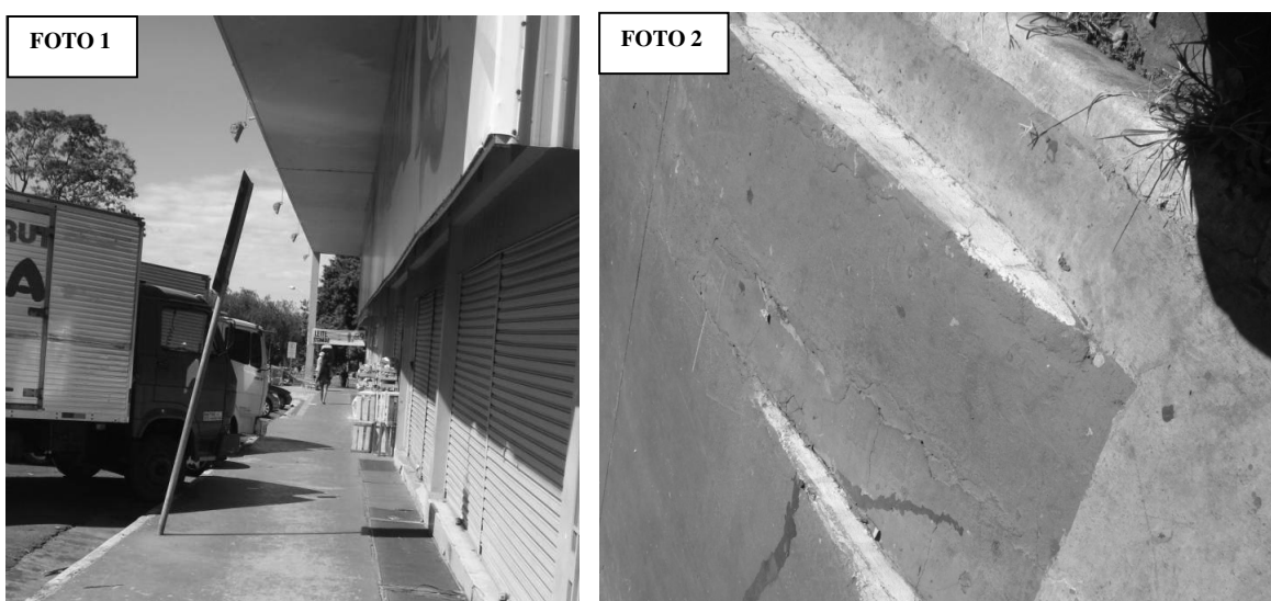
Figura 6.10- Foto 1, vista de calçada frontal; Foto 2, rampa 216SCR1
