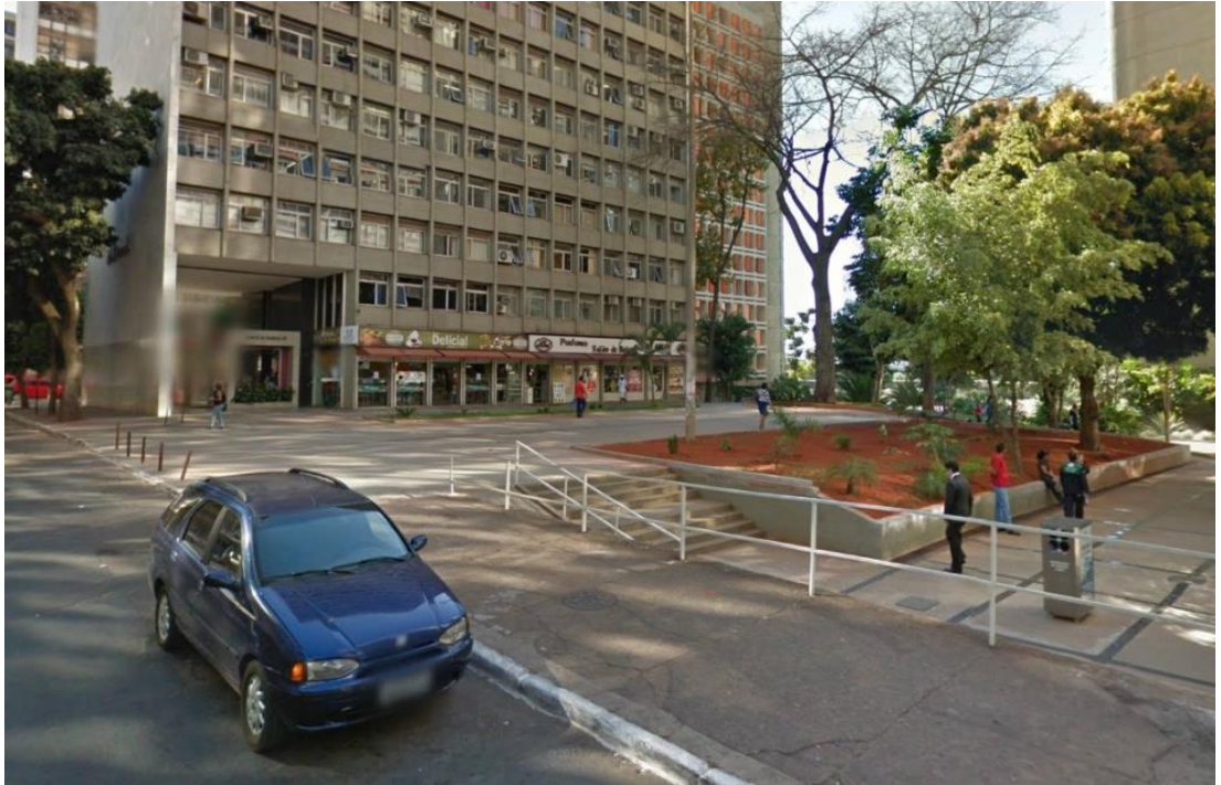
Figura 51. Brasília. SCS: térreo dos edifícios. Fonte: Google Maps (agosto 1997).
