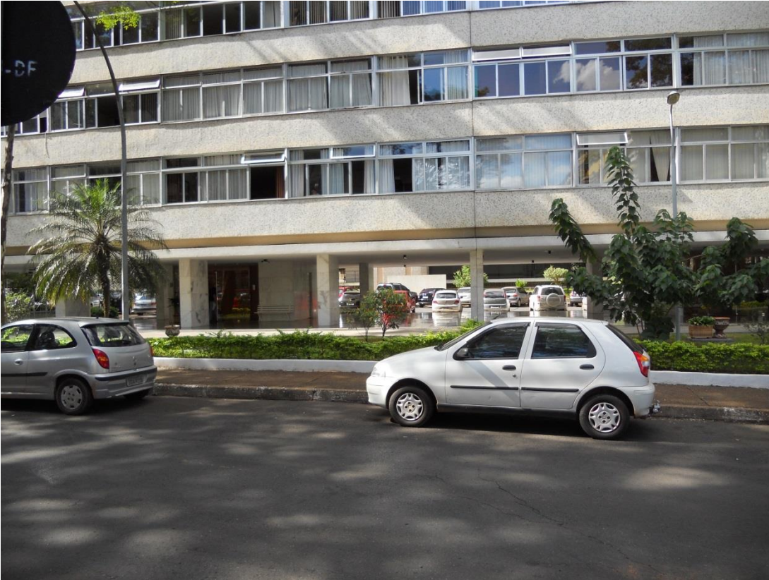
Figura 88. Brasília. SQS 302: elevação da materialidade com o uso do pilotis.
