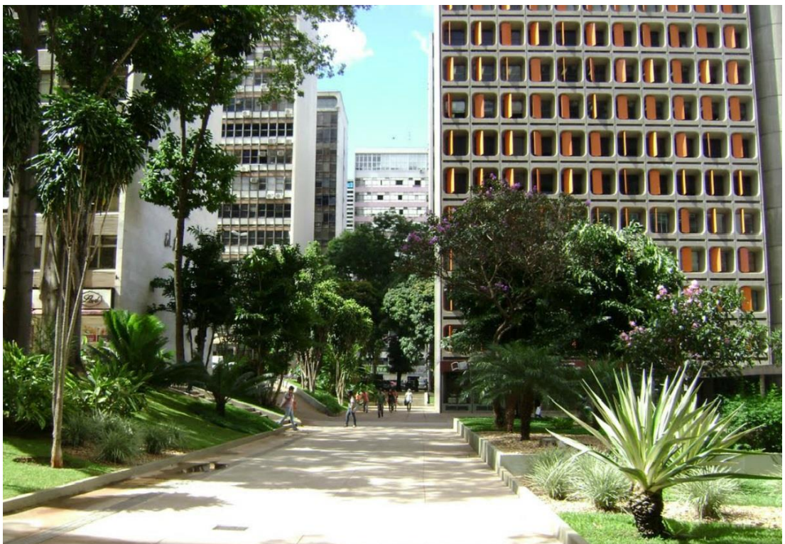
Figura 52. Brasília. SCS: edifícios implantados em um platô com percursos permeáveis. Fonte: Google Maps (agosto 1997).
