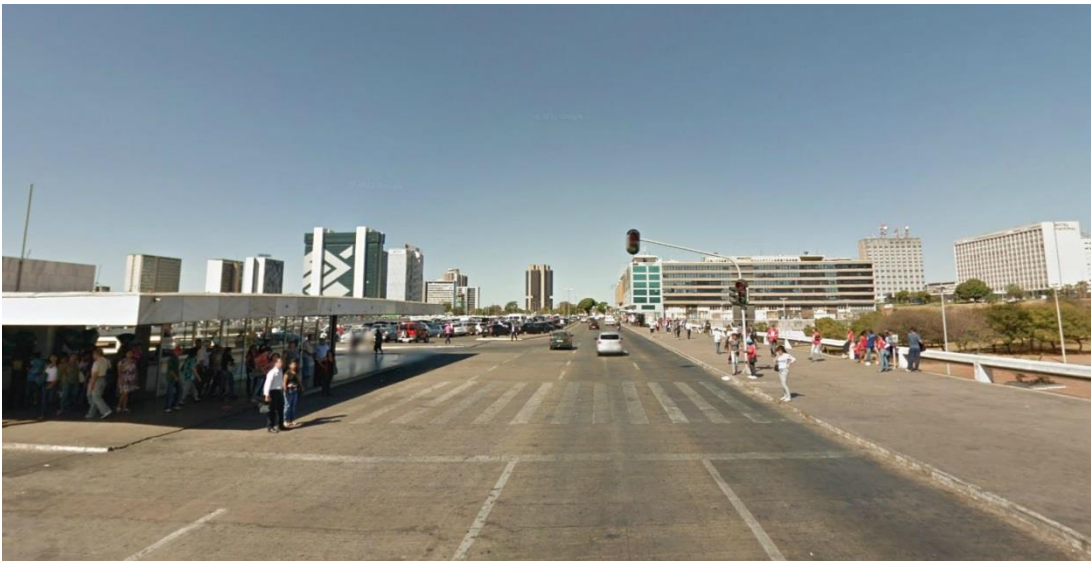
Figura 27. Brasília. Plataforma superior: via veicular e calçada. Fonte: Google Maps (agosto 1997).
