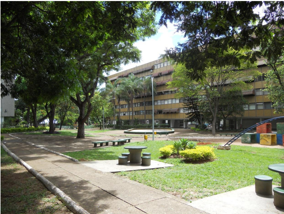
Figura 109. Brasília. SQS 303: implantação favoreceu o espaço público interno (10 horas). Fonte: Autora (11 novembro 2012).
