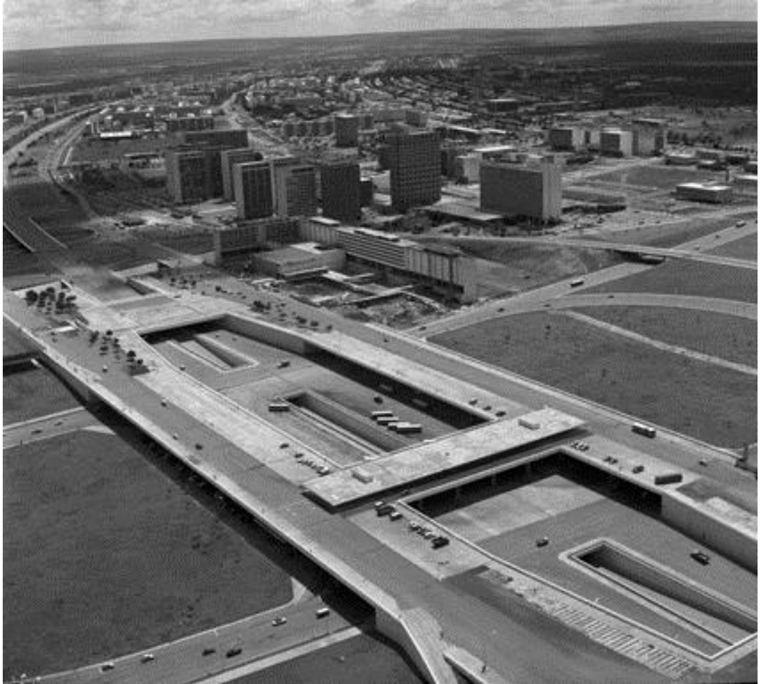
Figura 14. Brasília. Construção do edifício do Conic no Setor Comercial Sul. Fonte: Arquivo Público do DF (1970).
