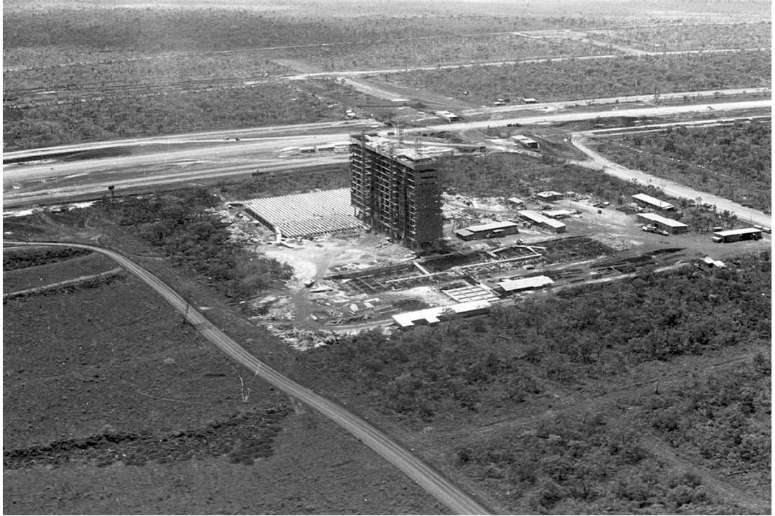
Figura 10. Brasília. Construção do Hospital de Base no Setor Médico-Hospitalar Sul. Fonte: Arquivo Público do DF (1960).
