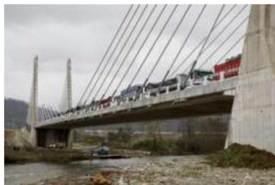
(b) Teste de carga da ponte suspensa sobre o
