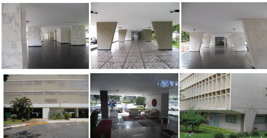
Figura 3.39- SQS 108 e 308 - pilotis permeáveis, SQS 107 e 208 - pilotis com baixa permeabilidade Fotos: acervo pessoal
