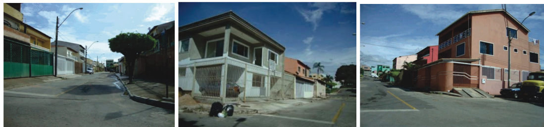
Figura 3.182 - Variedade de edificações Fotos: PPCUB - subsídios para o diagnóstico
