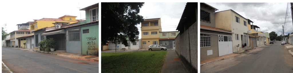
Figura 3.161 – SRES - quadras 2 e 3 - perda da uniformidade do conjunto de casas geminadas Fotos: acervo pessoal
