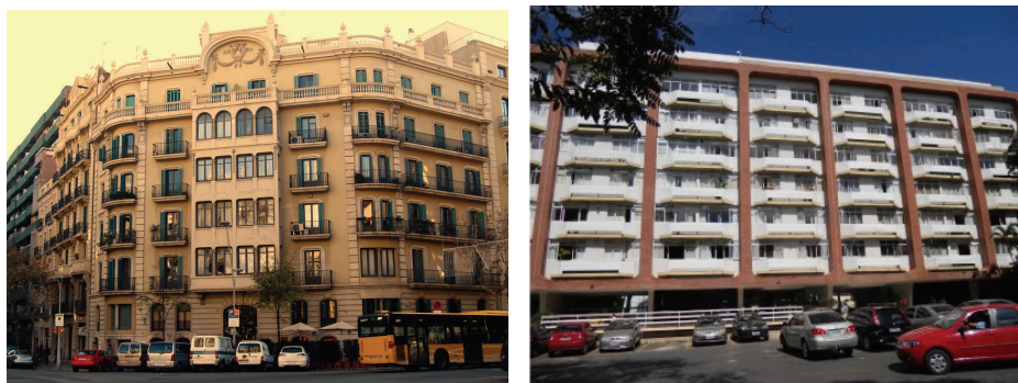
Figura 1.4 - Edificações de seis pavimentos em Barcelona e Brasília. Fonte: Google images e arquivo pessoal
