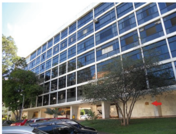
Figura 3.35 - SQS 107 - fachada principal com substituição das esquadrias Foto: acervo pessoal
