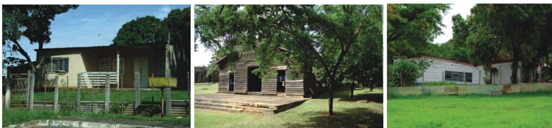
Figuras 3.181 - Edificações históricas remanescentes dos acampamentos pioneiros Fonte: PPCUB – subsídios para o diagnóstico
