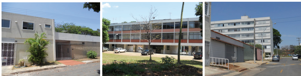
Figura 3.87 - Os três tipos edifícios do SHCGN – residências geminadas de um e dois pavimentos e blocos sobre pilotis com dois à cinco pavimentos.
