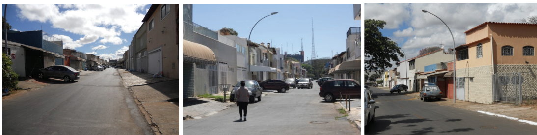
Figura 3.103 – Quadras 703/704 Sul – acesso pelas vias locais Fotos: acervo pessoal
