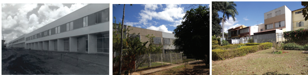
Figura 3.105 - “Casas Duplex”, casas com feições originais e casas com três pavimentos Fotos: ArPDF e acervo pessoal
