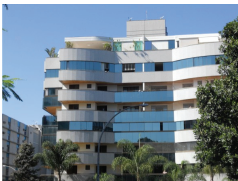
Figura 3.59 - SQS 112 – cobertura irregular Foto: acervo pessoal
