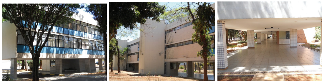
Figura 3.98 – Quadra 714 Sul - blocos residenciais de dois pavimentos sobre pilotis Fotos: acervo pessoal
