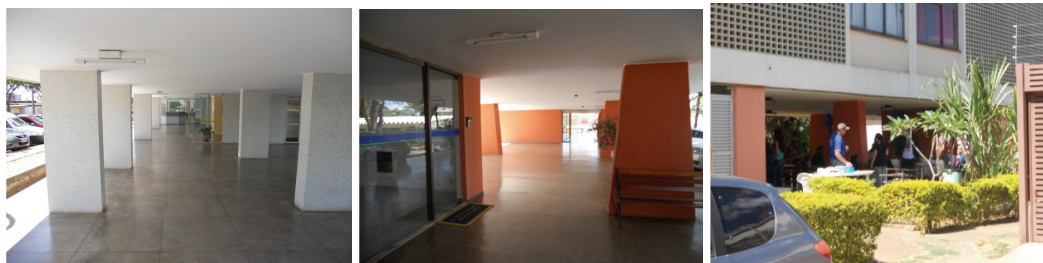
Figura 3.112 - Alta permeabilidade dos pilotis utilizado para eventos sem fechamento Fotos: acervo pessoal
