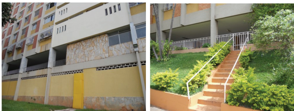
Figura 3.44 - SQN 312 – garagem aflorada com cercamento dos pilotis Fotos: acervo pessoal
