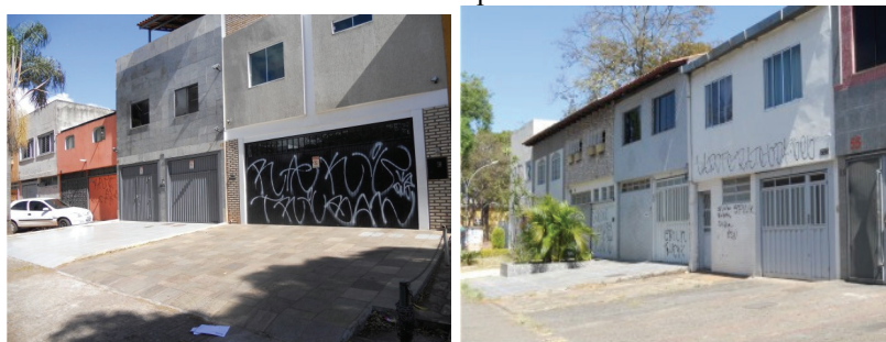
Figura 3.107 - Quadras 700 Sul com lotes voltados para a avenida W3 em 2012 Fotos: acervo pessoal
