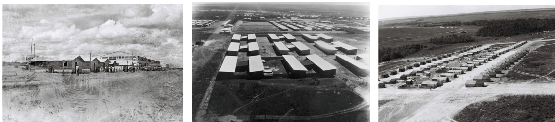
Figura 3.174 - Escritórios da NOVACAP, alojamentos “oficiais” e alojamentos “não oficiais” Fonte: ArPDF
