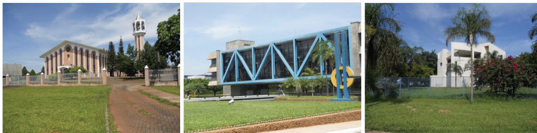
Figura 3.131 - SGAS – edificações de uso institucional Fotos: Acervo pessoal
