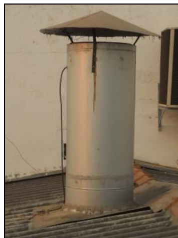
Figura 3.10 – Coifa com tubo e chapéu.
