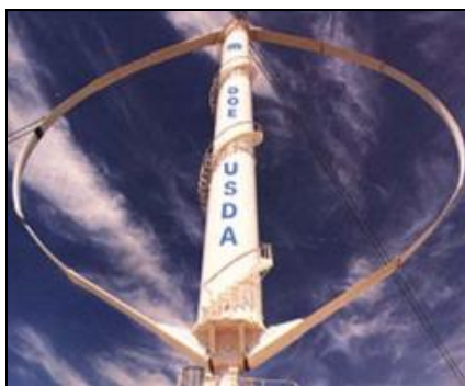
Figura 2.7 - Aerogerador experimental de eixo vertical Darrieus.
