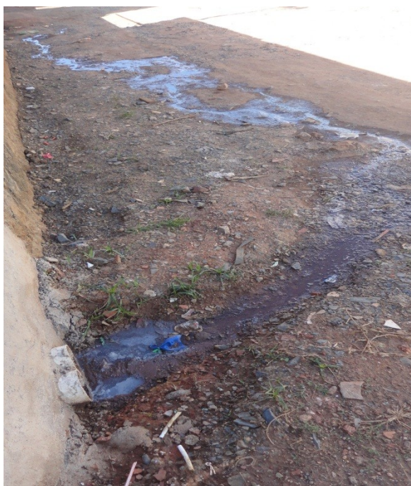
Figura 12 - Esgoto caseiro a céu aberto Fonte: fotos da autora
