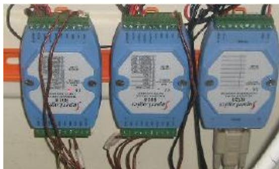
Figura 4.23 – Módulos de aquisição de dados.
