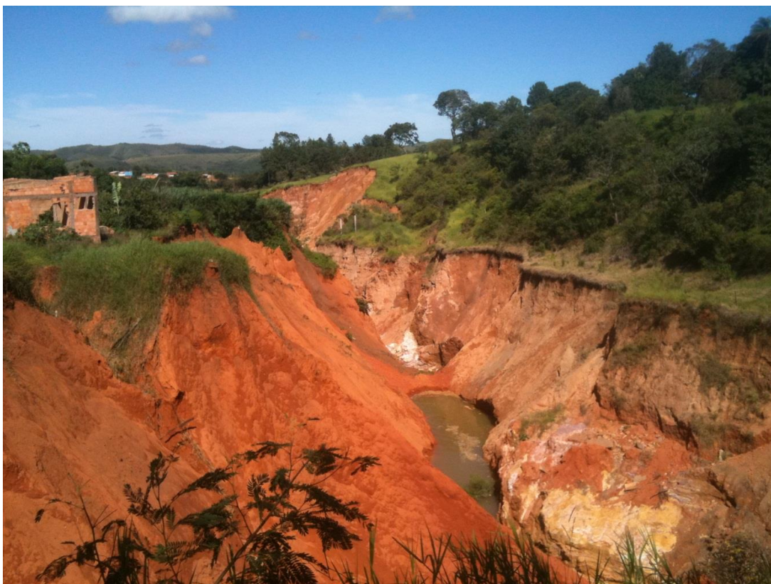
Figura 31 – Voçoroca no córrego Lambari, em Planaltina (GO), decorrente da ausência de sistemas de dissipação de energia de águas pluviais (Fotografia: Carlos Christian Della Giustina – 28/04/2010).
