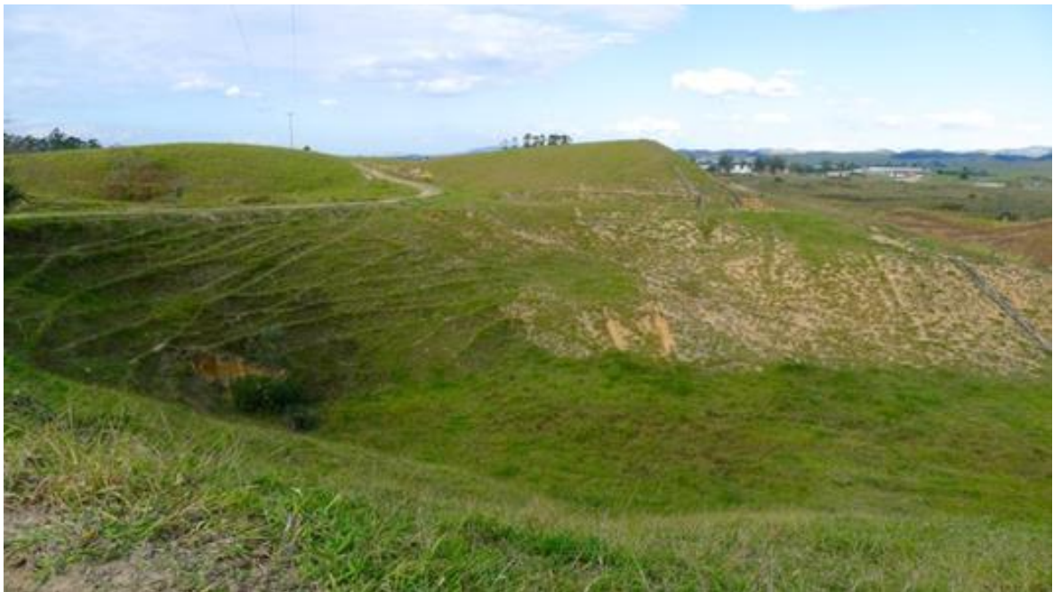
Fotografia 6 - Erosões laminares à direita e pequeno escorregamento na base de anfiteatro na Unidade de Terreno Colinas Sedimentares. Fotografia tirada próxima ao ponto 1.3.
