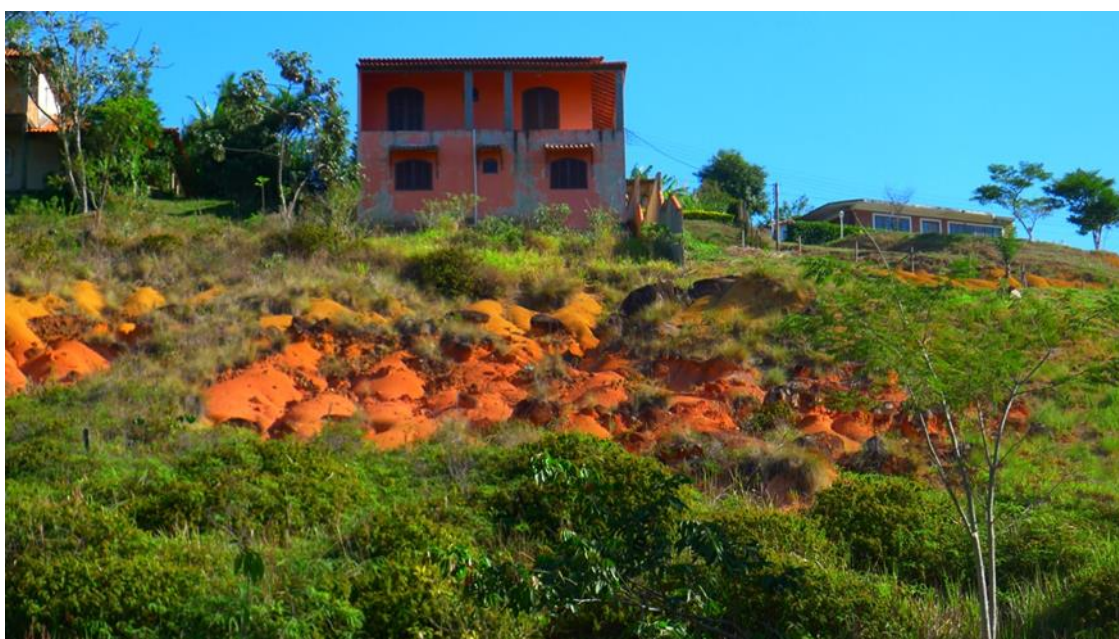
Fotografia 25 - Casa construída em bairro assentado sobre morro de tálus, com feições erosivas muito expressivas e blocos a matações de sienito, na Unidade de Terreno Rampas e Morros de Tálus. Localização: ponto 2.6.
