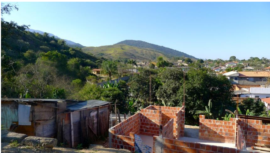
Fotografia 24 - Casas de alvenaria e barraco construídas em bairro sobre morro na Unidade de Terreno Rampas e Morros de Tálus. Ao fundo, pode-se observar rampas da mesma unidade de terreno. Fotografia tirada no ponto 2.7
