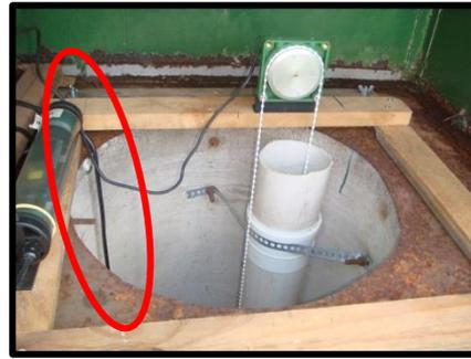
Figura 4-111. Detalhe para a fiação do sensor de nível dentro do poço.
