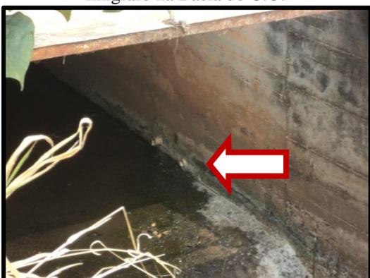
Figura 4-100. Saída do tubo de interligação entre a galeria e o poço da boia.
