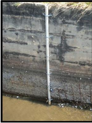
Figura 4-113. Tentativa inicial de instalar o sensor de nível a jusante da galeria de drenagem.
