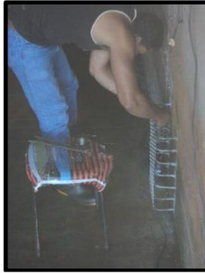
Figura 4-114. Instalação da proteção na parede interna da galeria.
