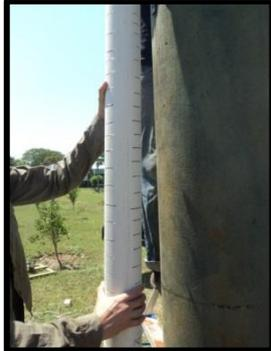
Figura 4-93. Perfuração no tubo para que a água tivesse acesso livre.
