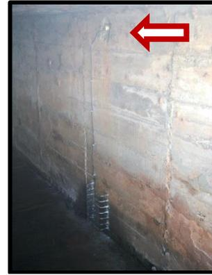
Figura 4-115. Gaiola com o sensor de nível do amostrador automático. Detalhe para a ligação entre a bóia e o amostrador.
