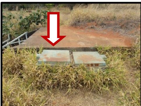
Figura 4-98. Caixa de concreto que abriga o linígrafo na Bacia do C.O.
