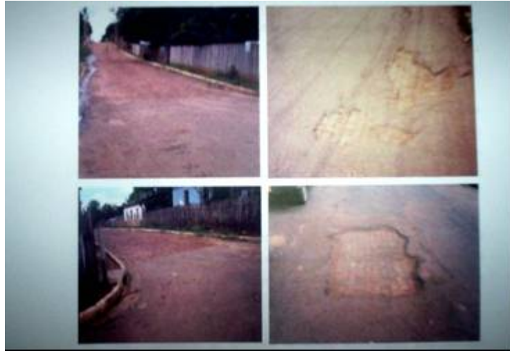
Figura 2.19 (f) - Utilização de tijolos de laterita – asfalto em Rio Branco – Acre (Foto: Jairo Lima, 1990), referência (Amaral, 2004).
