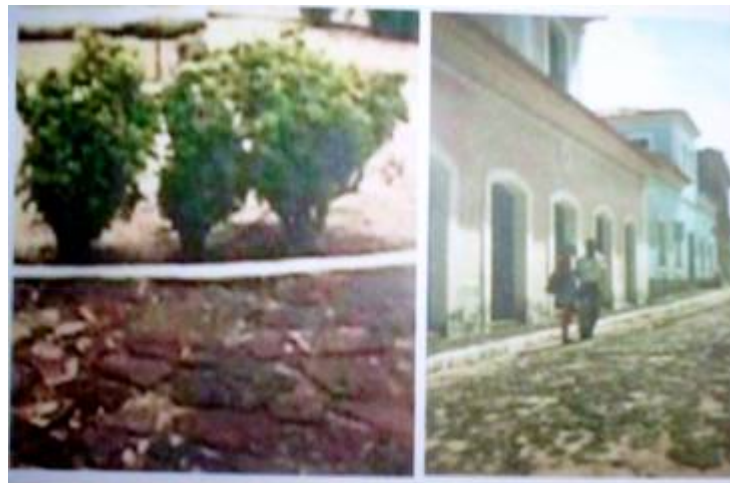
Figura 2.19 (g) - Calçamento de praças e vias públicas (Praça matriz em Mosqueiro – Belém-Pará e ladeira do jacaré em Alcântara – Maranhão) . Fonte (Amaral, 2004)
