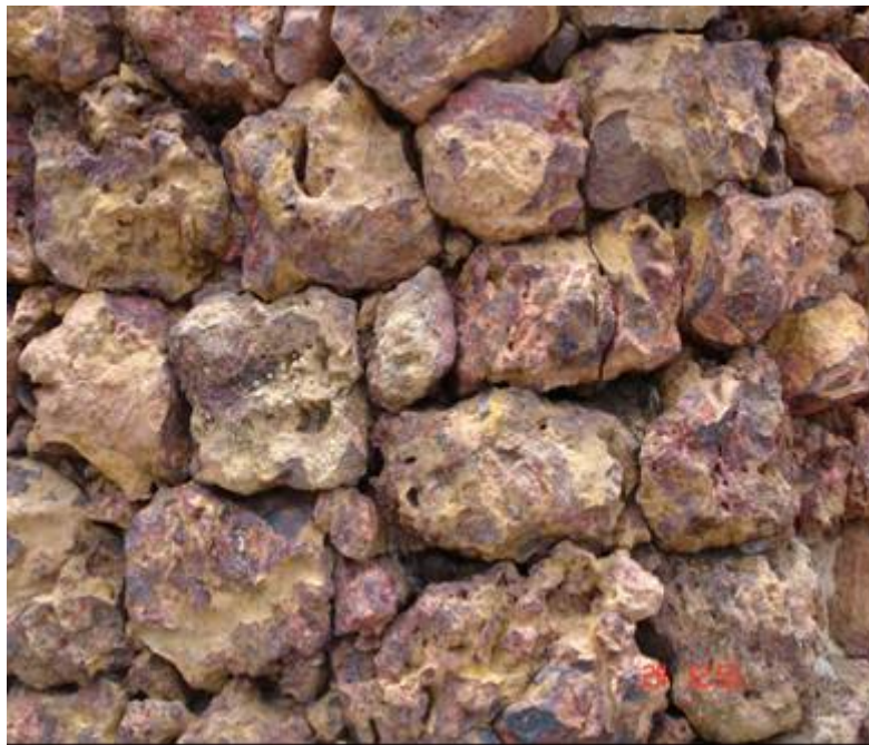
Figura 2.19 (a) - Laterita constituindo muro de arrimo – Boa Vista – Roraima.
