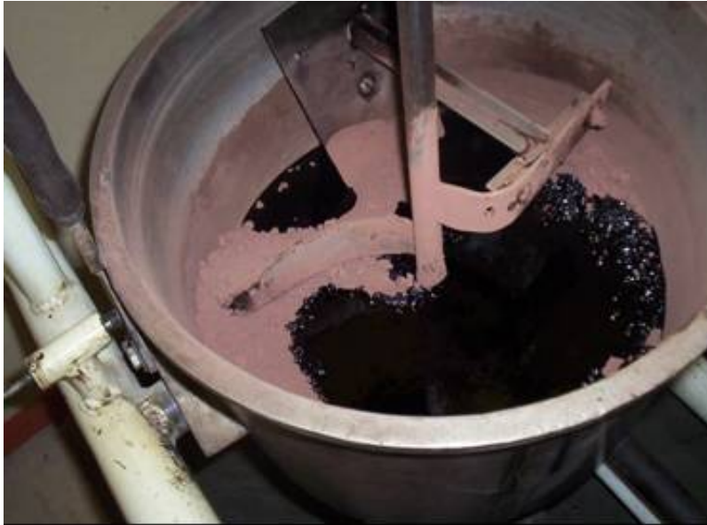
Figura 3.30 - Mistura da massa asfáltica para compactação das placas.
