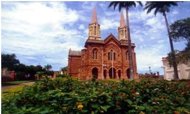
Figura 2.19 (d) - Laterita usada em alvenaria. Igreja São Domingos – Uberaba (Cruz, 2003)
