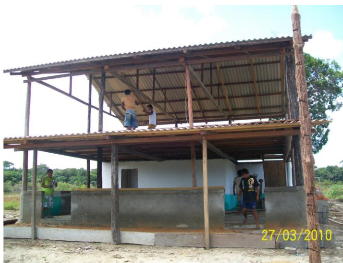
Fotografia 15: Processo de construção da escola para o ensino técnico em Tapira Ponta Autora: Francinete Soares Martins Data: 2010 Fonte: Arquivo pessoal
