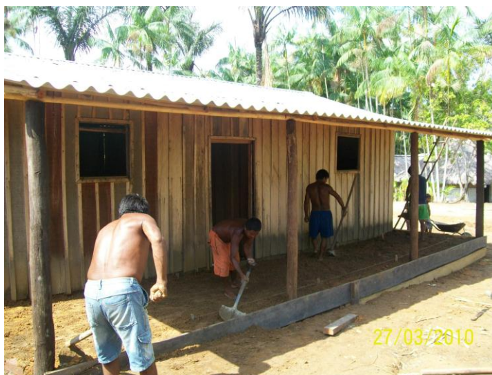
Fotografia 16: Reforma da casa para hospedagem dos professores Autora: Francinete Soares Martins Data: 2010 Fonte: Arquivo pessoal
